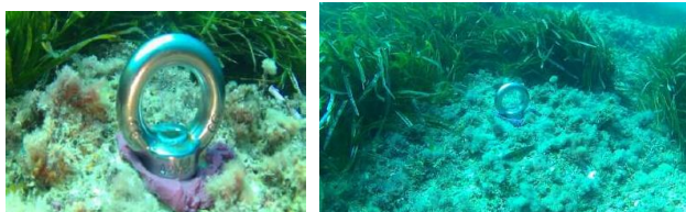
Imagen 3: Ejemplo de instalación en roca con tornillo.
