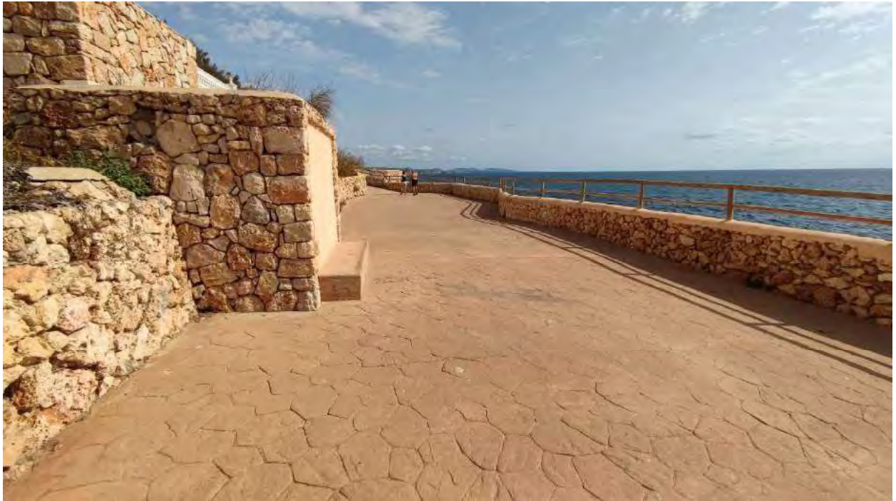
Figura 9.- Tramo 4 del paseo marítimo de Calas de Mallorca.
