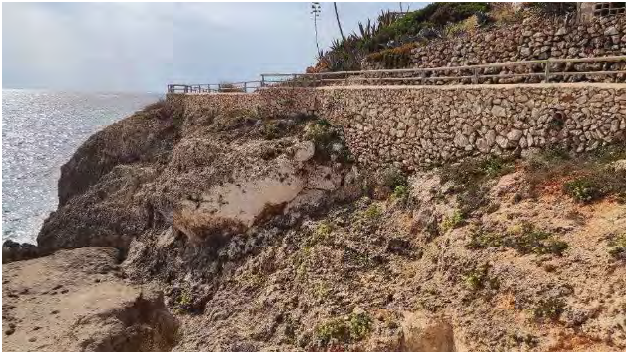
Figura 20.- Vista del muro de contención del tramo 8 del paseo marítimo de Calas de Mallorca.
