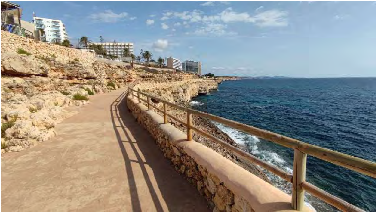
Figura 13.- Tramo 6 del paseo marítimo de Calas de Mallorca.
