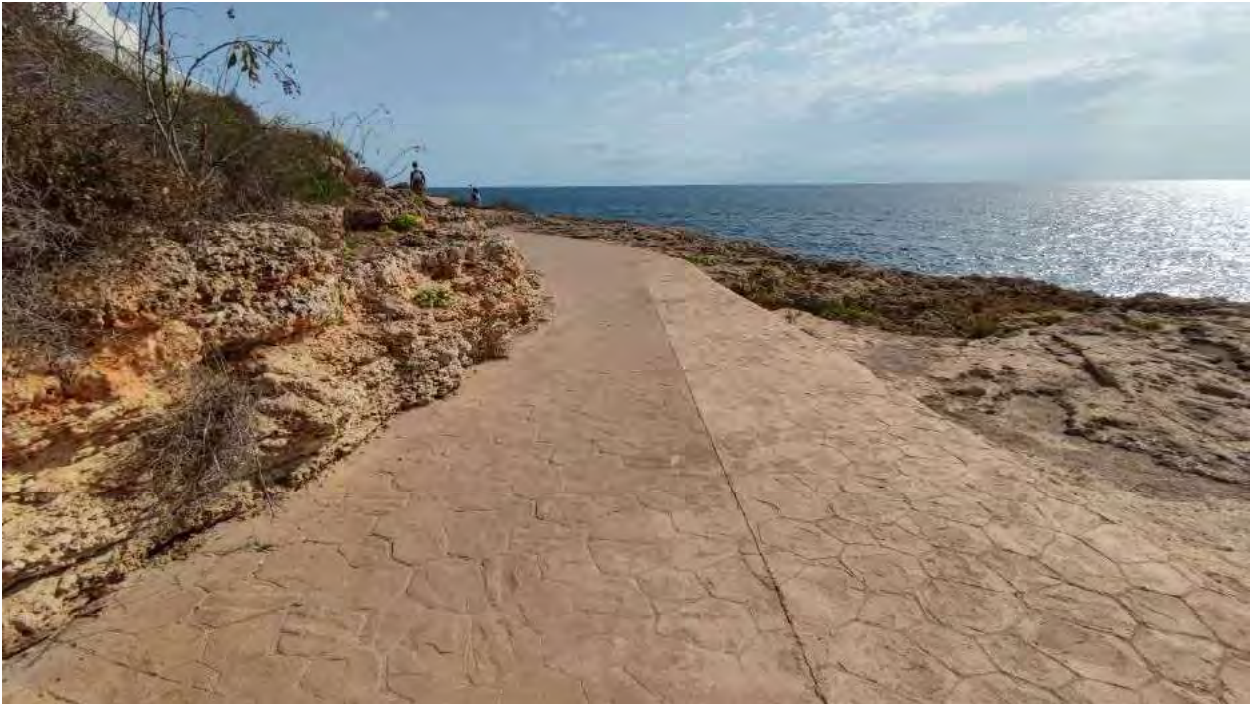
Figura 5.- Tramo 2 del paseo marítimo de Calas de Mallorca.
