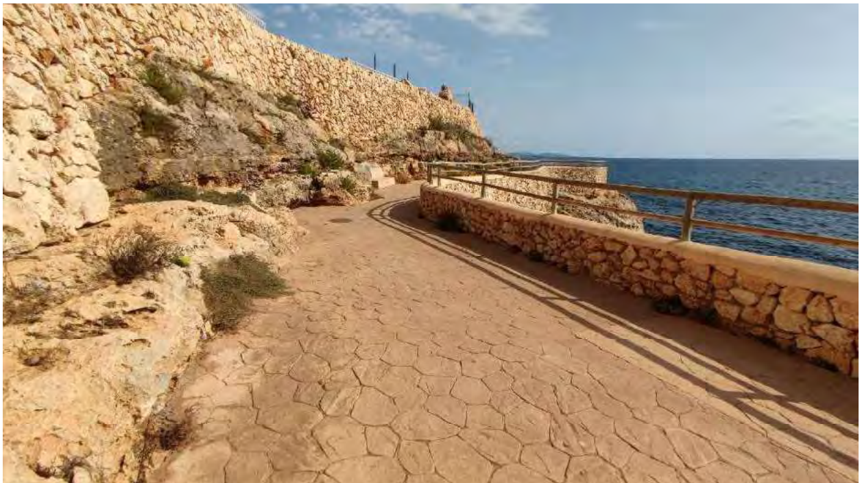
Figura 12.- Tramo 5 del paseo marítimo de Calas de Mallorca.
