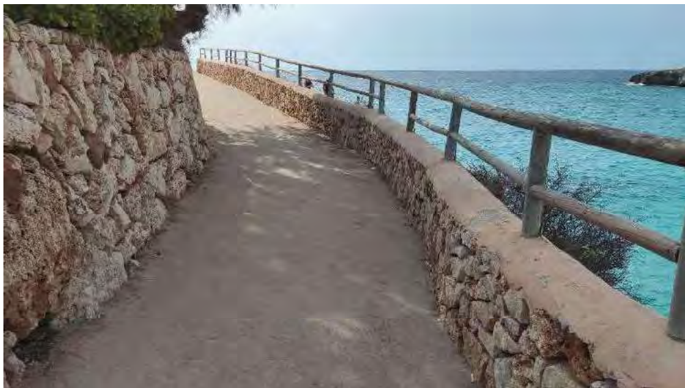
Figura 2.- Tramo 1 del paseo marítimo de Calas de Mallorca.
