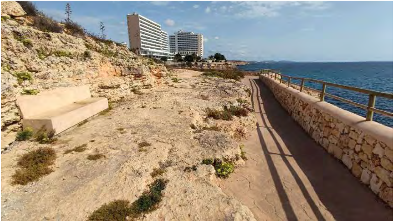
Figura 17.- Tramo 7 del paseo marítimo de Calas de Mallorca.
