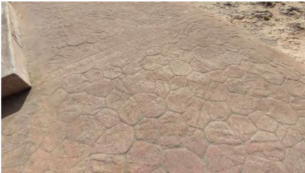
Figura 4.- Detalle del pavimento de hormigón estampado, presente en toda la superficie del paseo.
