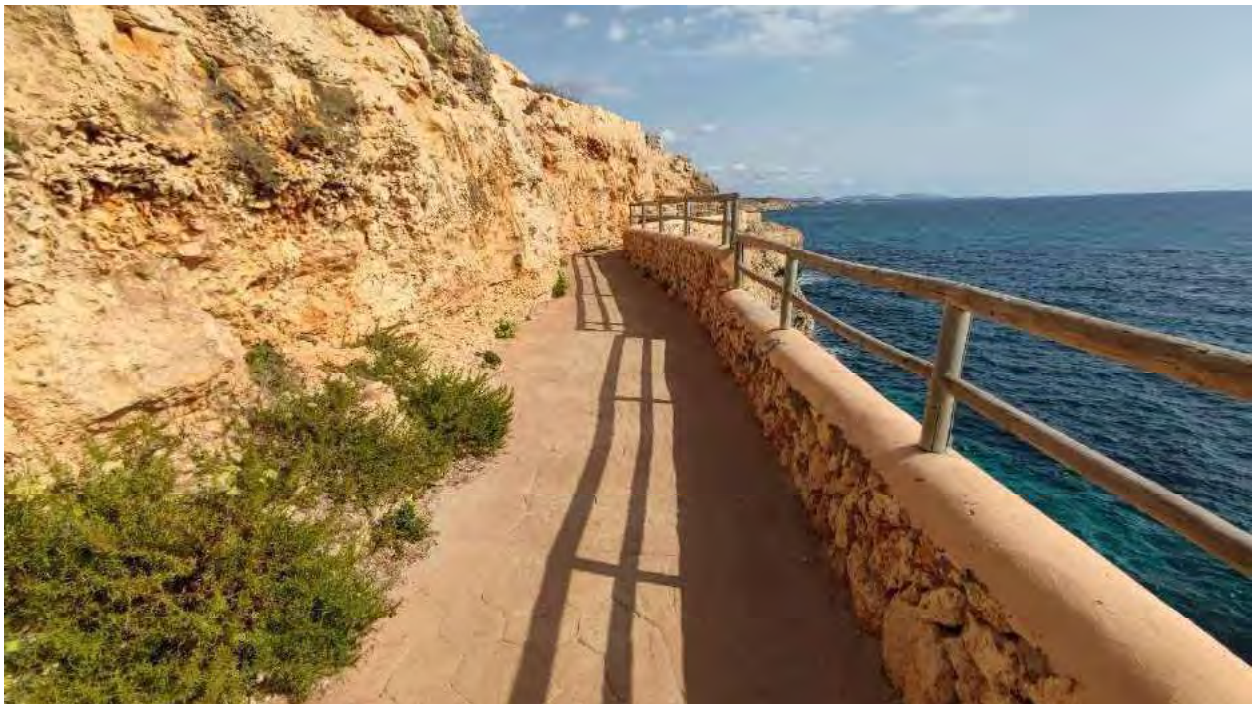
Figura 16.- Tramo 6 del paseo marítimo de Calas de Mallorca.
