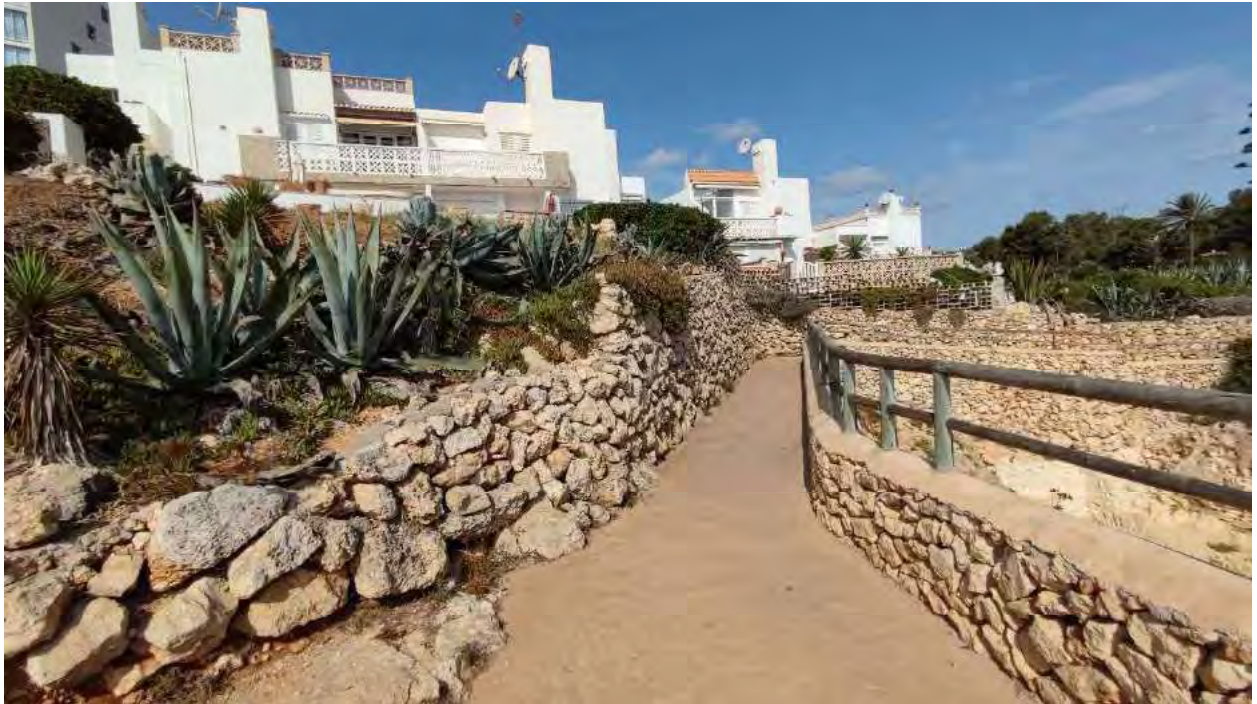
Figura 19.- Tramo 8 del paseo marítimo de Calas de Mallorca.
