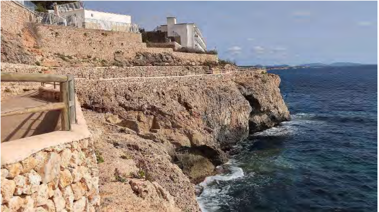
Figura 7.- Vista del muro de contención del lado mar, en el tramo 3 del paseo marítimo.
