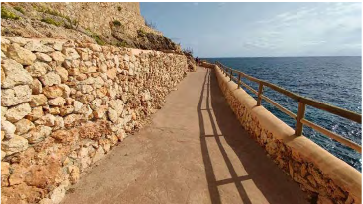
Figura 8.- Tramo 3 del paseo marítimo de Calas de Mallorca.
