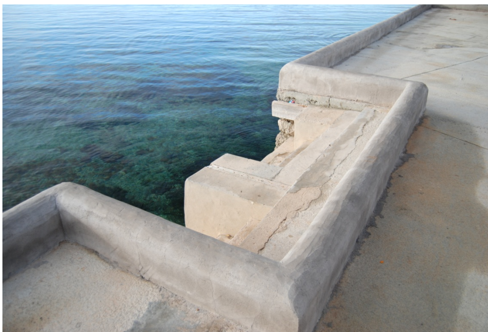
Escaleras de acceso al mar.
