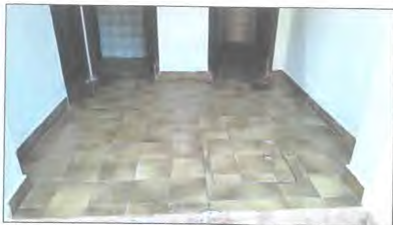
08 Detalle acceso aseos y arqueta registro fosa séptica
