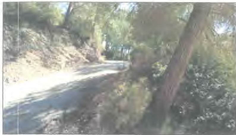
01 Camino asfaltado acceso vehículos
