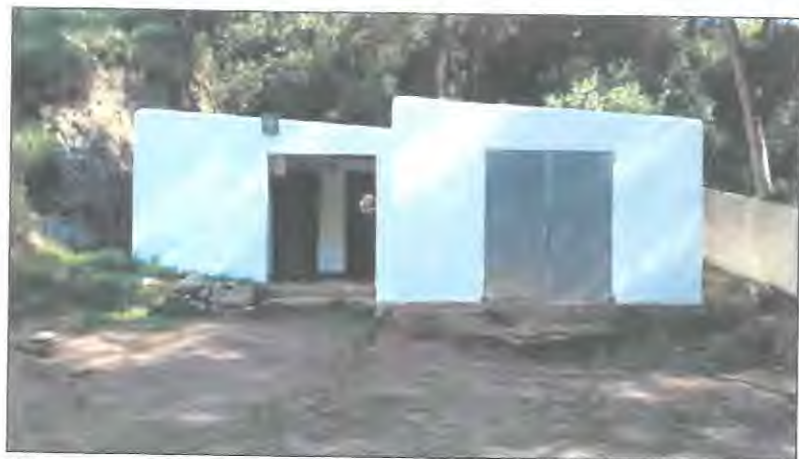
07 Fachada zona aseos y fosa séptica, y almacén
