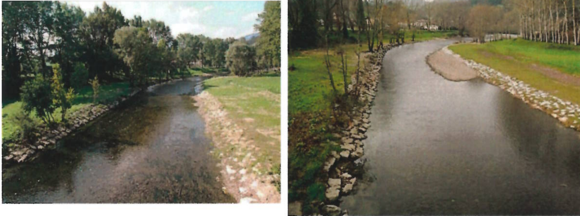
Figura AII.7. Empiezan a aparecer nuevos depósitos de gravas (aguas arriba del puente).
