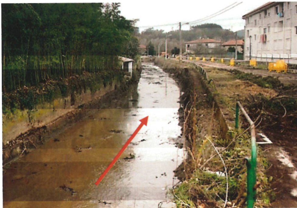
Figura 28. Canal de Viesgo. Estado actual.
