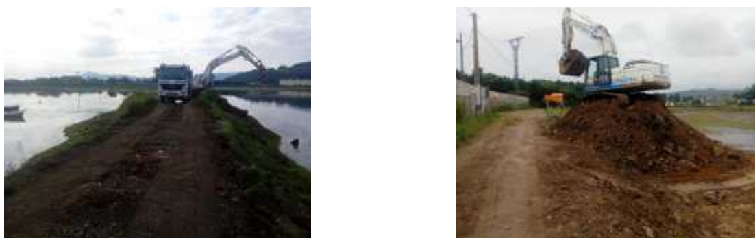
Dique retirado en Cicero, procedencia del material
