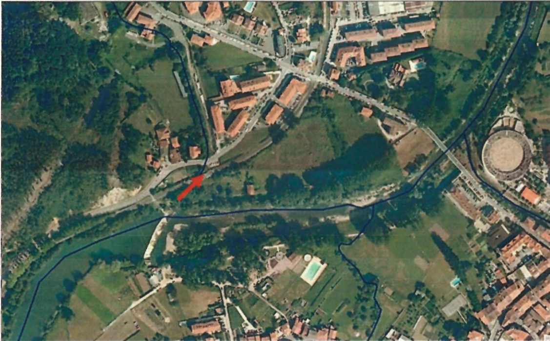
Figura AII.11. Azud de comienzo del canal de Viesgo para aprovechamiento hidroeléctrico (fuera de servicio).
