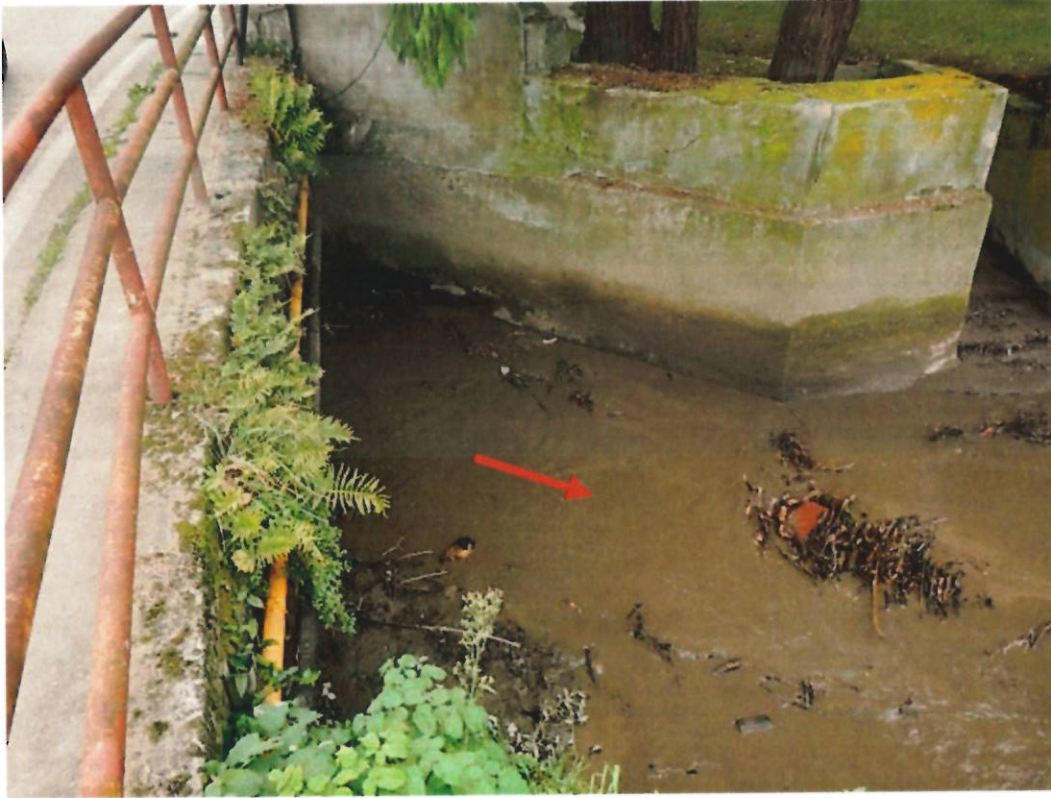
Figura AII.13. Puente de la carretera.
