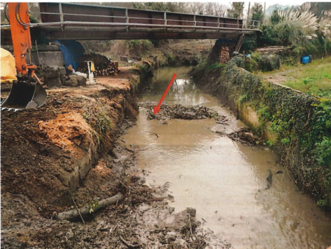
Figura AII.12. Inicio del canal de Viesgo (a partir del azud, en su parte inicial atraviesa dos caños de unos 80 cm de diámetro) a continuación pasa por debajo de las vías del tren y de la carretera.
