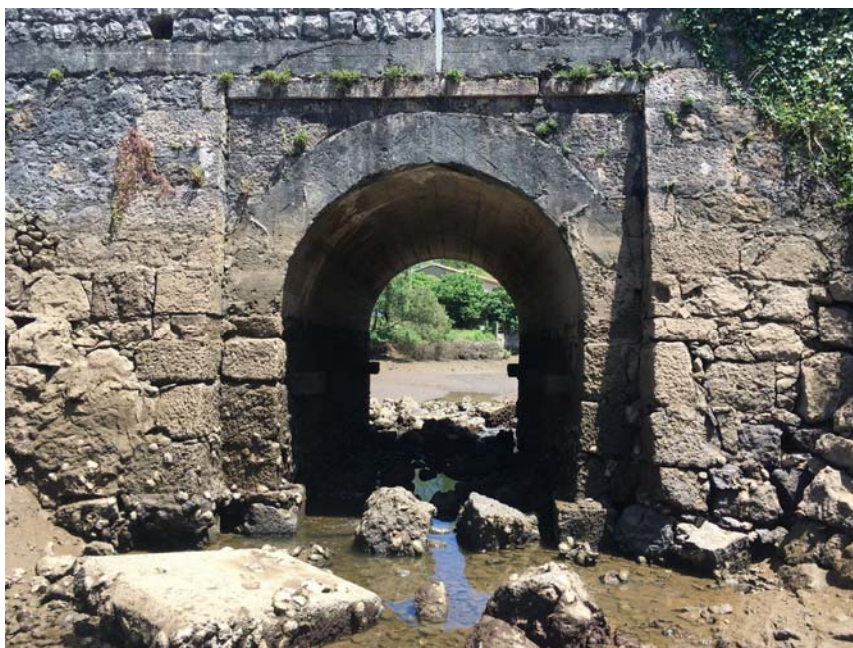
FOTO 4: Carretera CA-934 Puente de Arna
