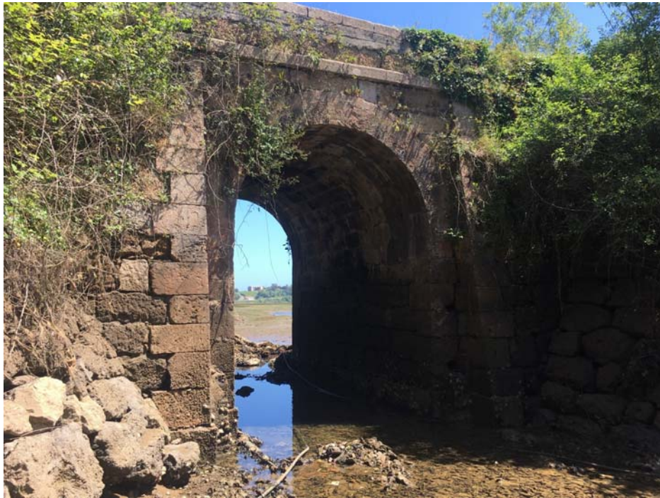
FOTO 6: Puente mampostería Acceso Abañó
