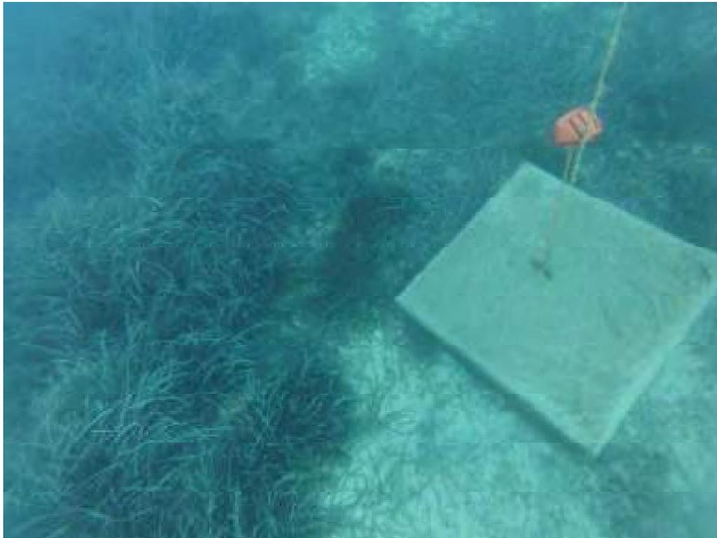
**Figura 8.** Lastre de hormigón y tren de fondeo con cadena de amarre. Fuente: GEN
