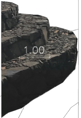
ESCALONES ACCESO A PISCINA EXISTENTE
