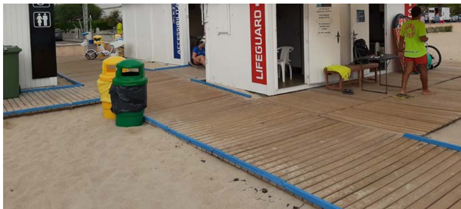
Detalle de pasarela de madera sobre arena para unificar las instalaciones fijas y comunicarlas al paseo urbano
