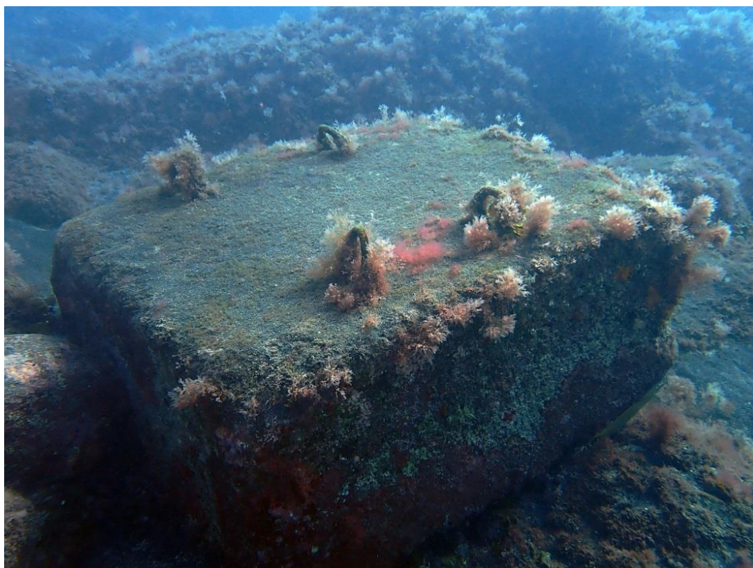
Fotografía 8. Detalle de uno de los muertos de amarre sin la línea de fondeo.
