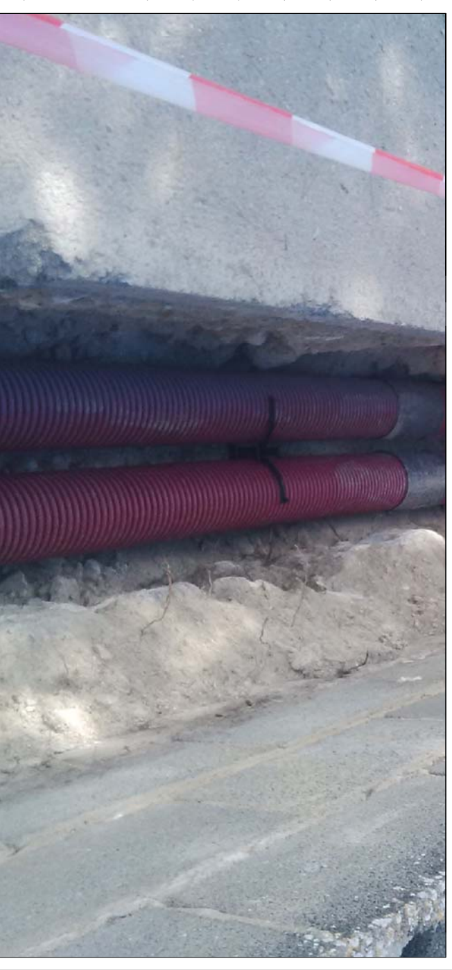
EJEMPLO ZANJA BAJO ASFALTO
