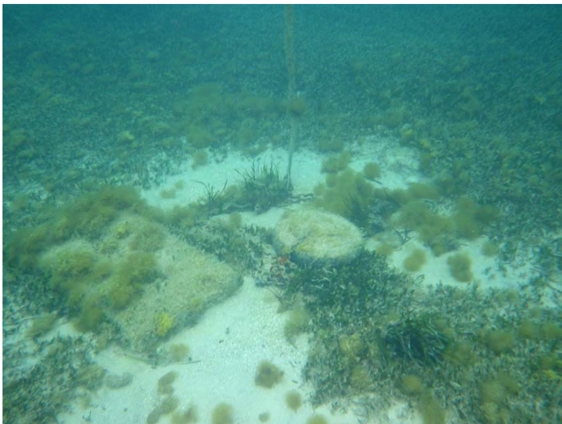
Figura 29. Conjunto de lastres y neumáticos de hormigón con cadenas que han erosionado el fondo creando un claro arenoso.
