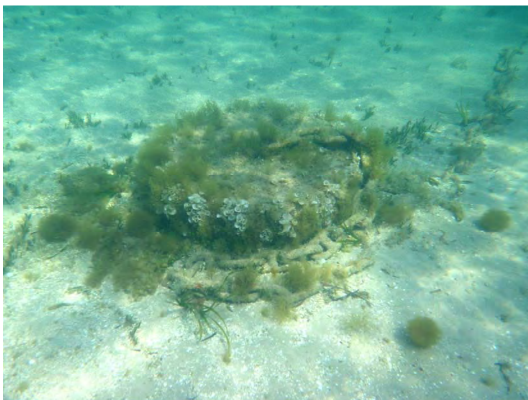
Figura 24. Lastre abandonado mediante el uso de neumático relleno de hormigón y cadena.
