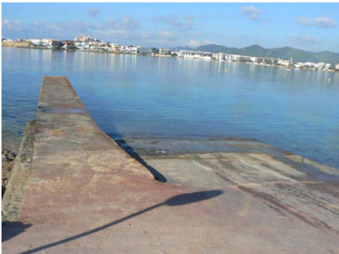
Figura 13. Embarcadero y rampa de varada en la ribera Este de la bahía de Talamanca (Sa Punta).
