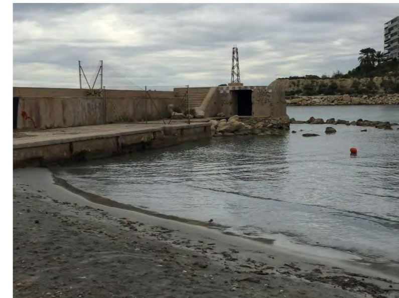
Imagen 77: Dique existente en la playa. Fuente: Elaboración propia.
