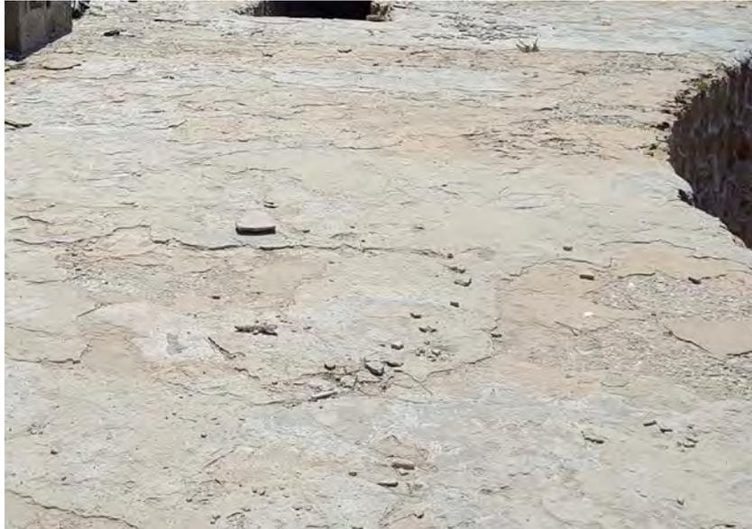
Foto 7: Vista detalle de estado actual del pavimento de la plataforma-solárium.
