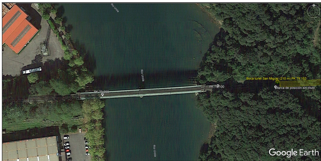
Puente sobre el Río Urola (PK 78+940 – 79+120)
