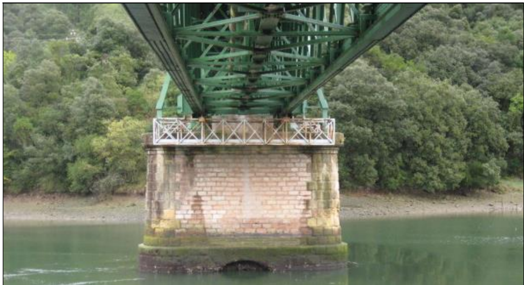
Alzado de pila 1 desde estribo 1
