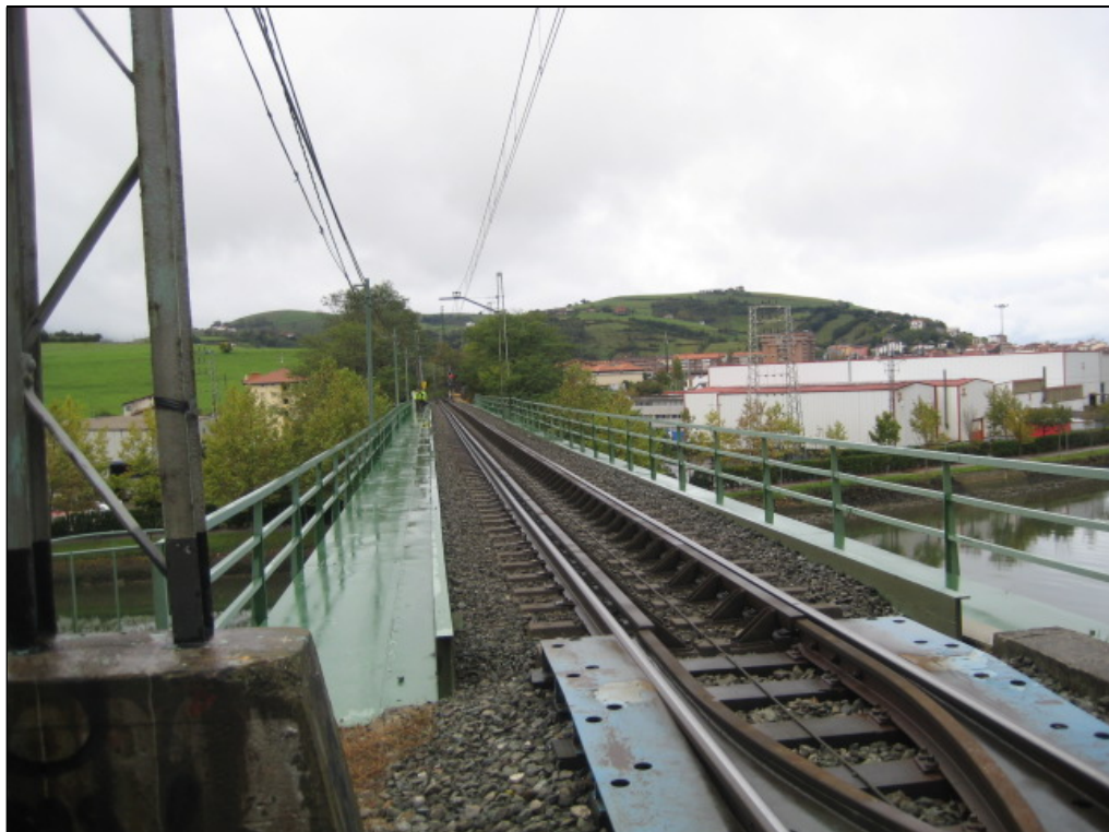
Vista de la plataforma en sentido PK decreciente desde el estribo 2
