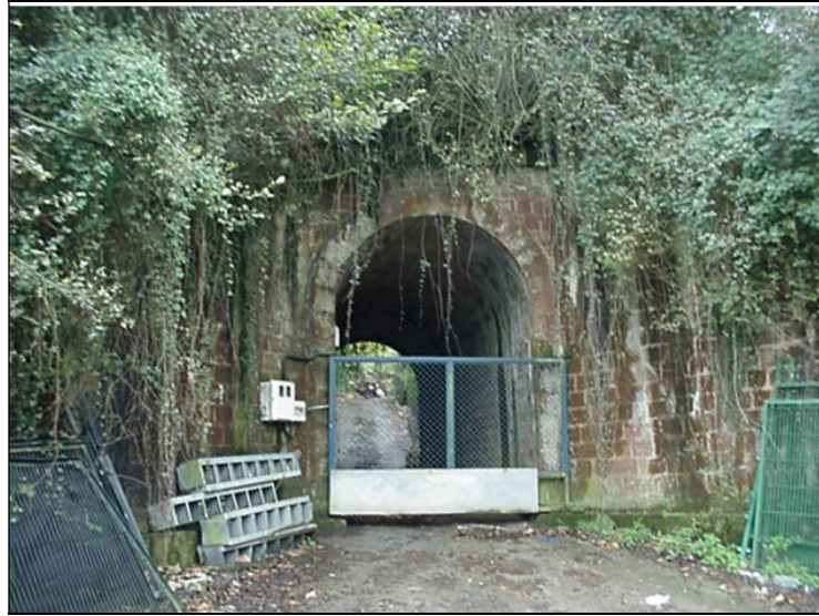
Paso inferior PK 77+086
