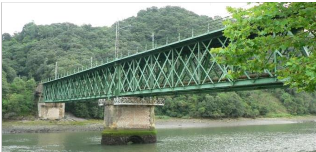
Vista en escorzo desde lado izquierdo del estribo 1
