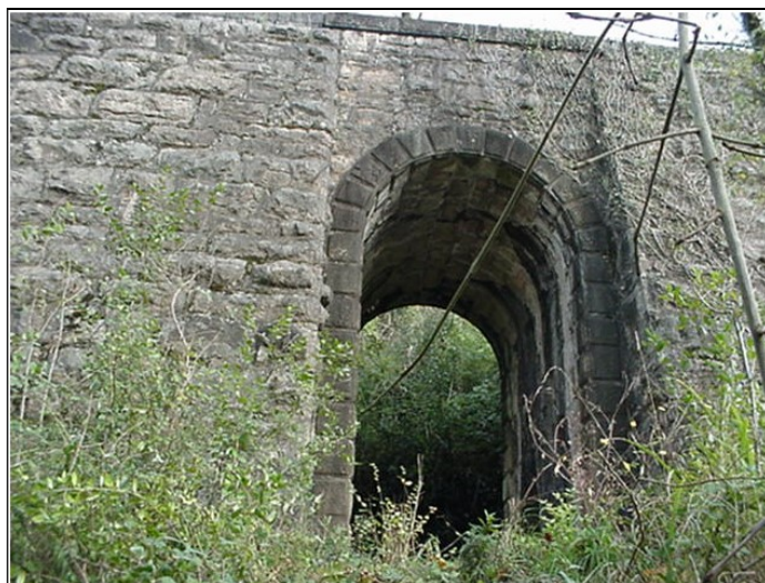
Paso inferior PK 80+200
