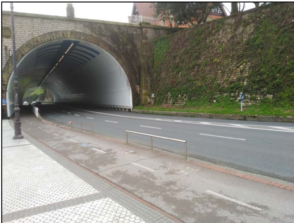
Figura 27. Túnel del Antiguo y ladera del parque de Miramar.
