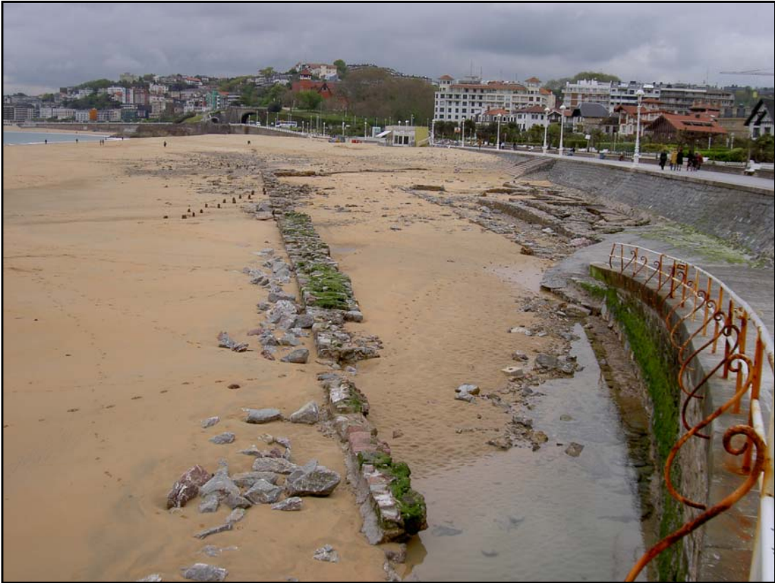
Figura 11. Detalle de las estructuras de la antigua cárcel y de los cascotes que retenía (Autor: Francisco Etxeberria Gabilondo).
