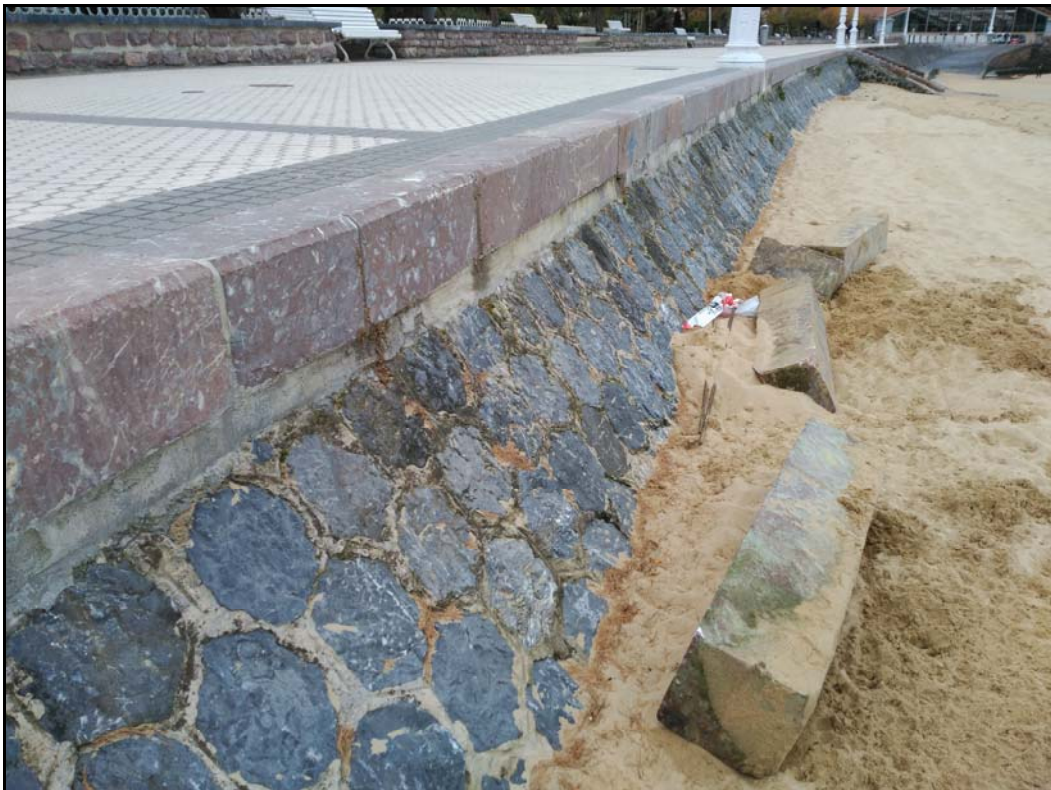
Figura 33. Muro de Costa construido en 1925.
