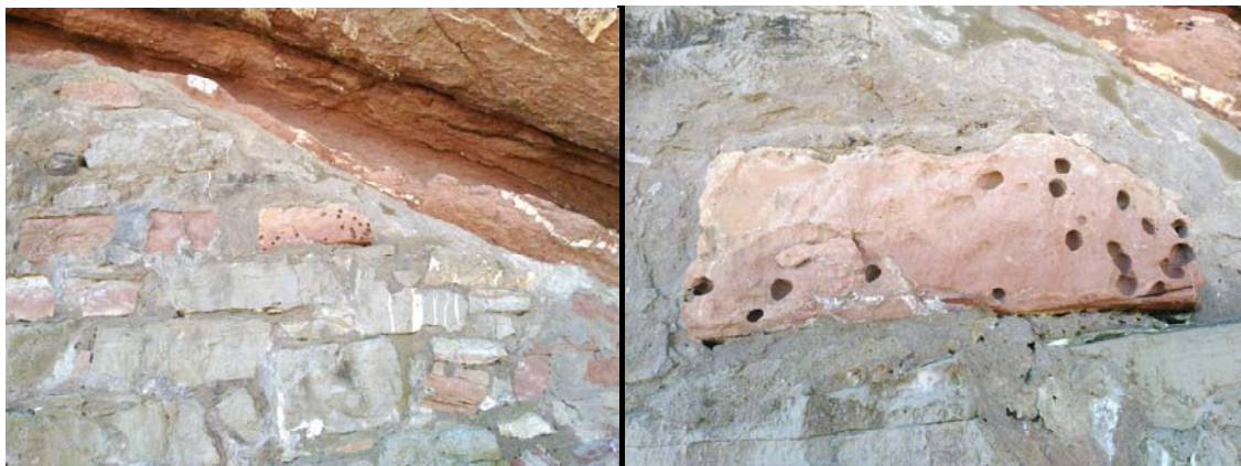
Figura 23. Detalle de muro de costa en Loretopea, caliza roja afectada con lithófagas.
