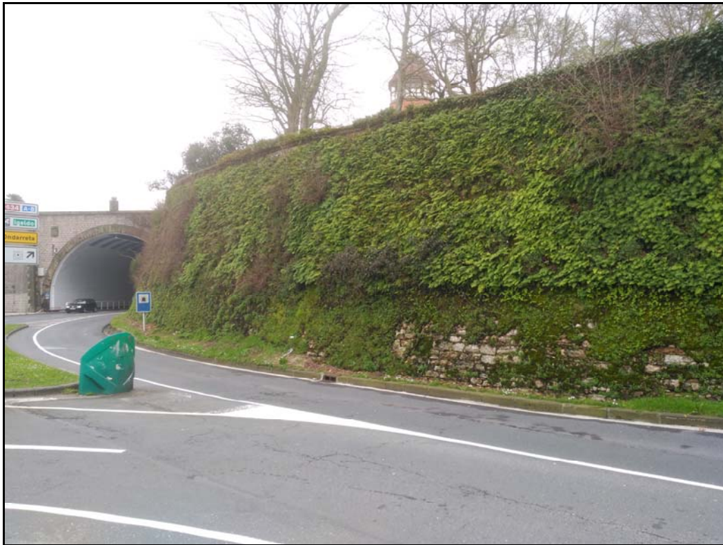
Figura 24. Ladera con el muro de contención actual.
