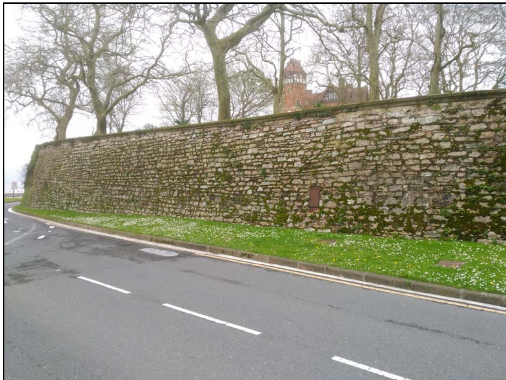
Figura 25. Ladera de Miramar con el muro de contención.
