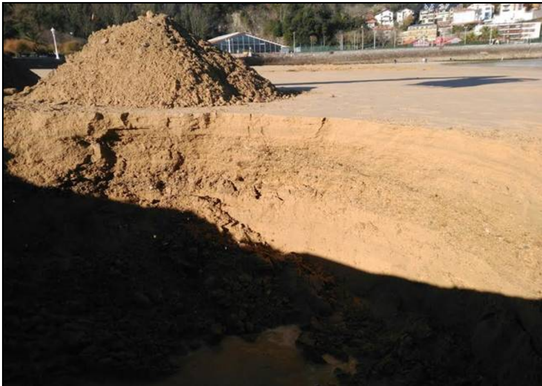
Figura 39. Monocapa de escombros (arena-escombros-arena), y debajo más arena limpia.
