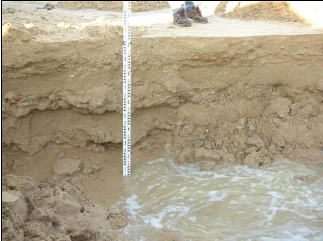
Figura 40. Triple capa de escombros (arena-escombros-arena-escombros-arena-escombros-arena), y debajo más arena limpia.
