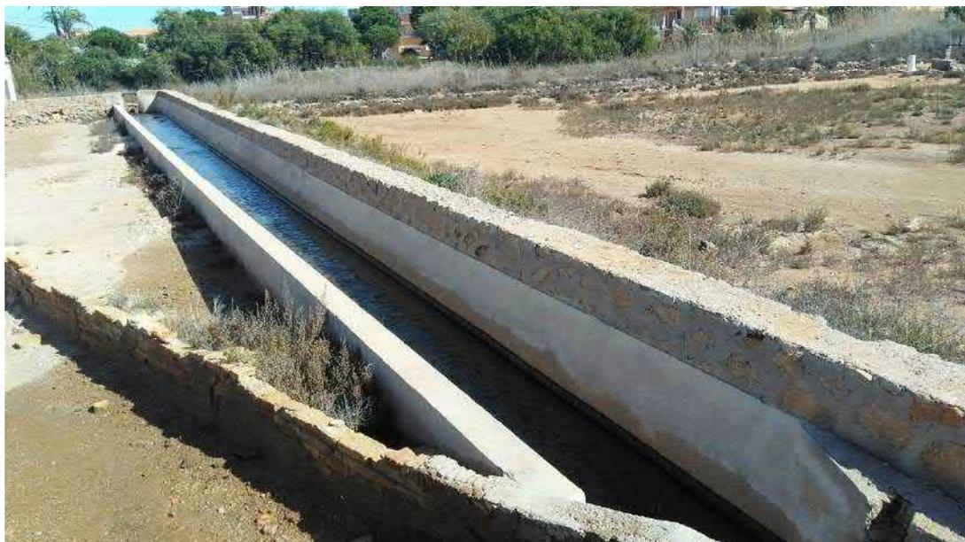
Imagen 6. Canal de entrada a los recintos salineros impermeabilizado
