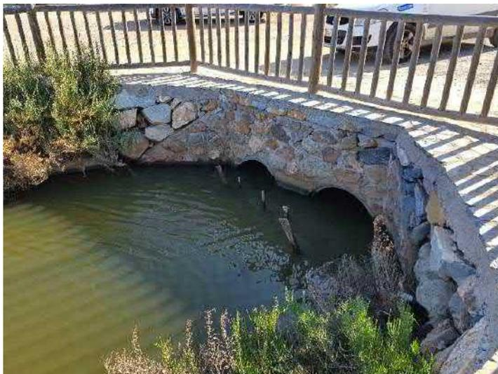
Imagen 10. Elementos de desbaste en la piscina de entrada existentes
