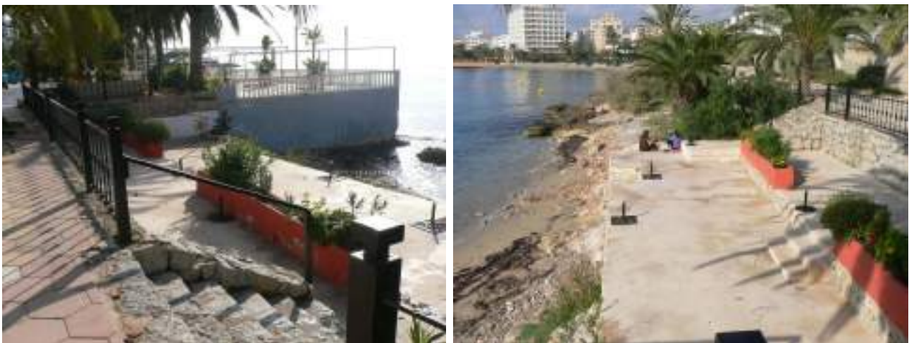
Foto 2. Vista del acceso a la terraza desde el Paseo de Ses Pitiüses (izquierda), y vista de la terraza hacia el oeste.
