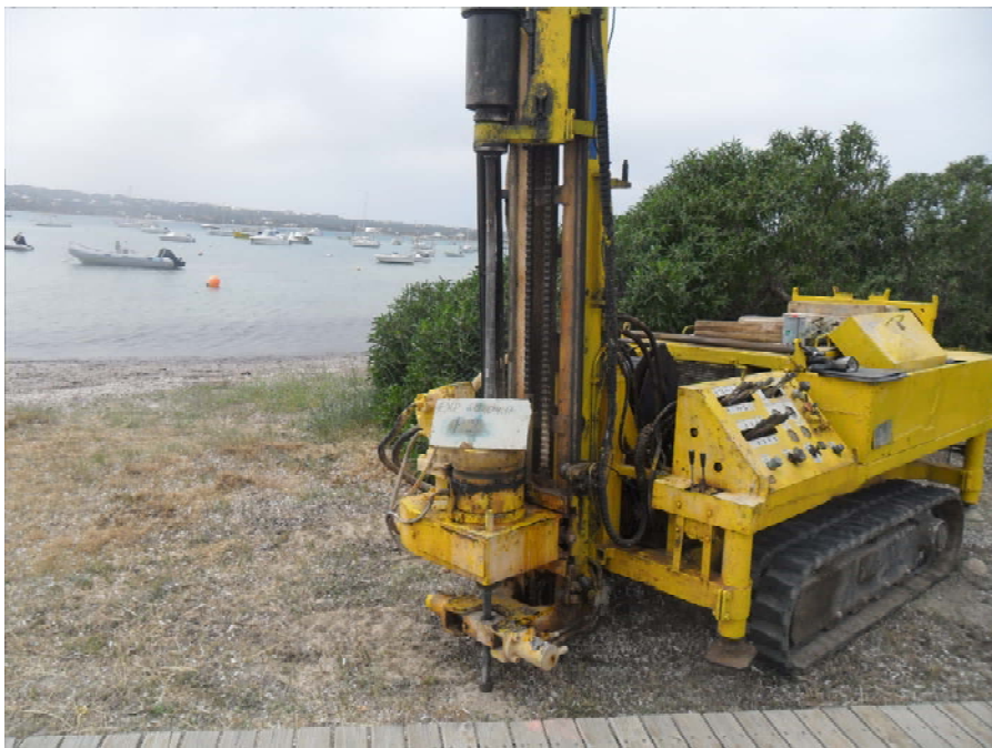
Foto 2: Emplazamiento de sonda en punto P 2
