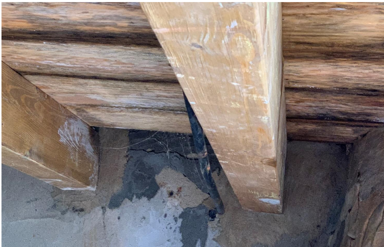
Foto 5. Vista de la estructura de cubierta existente, formada por vigas y travesaños de madera.
