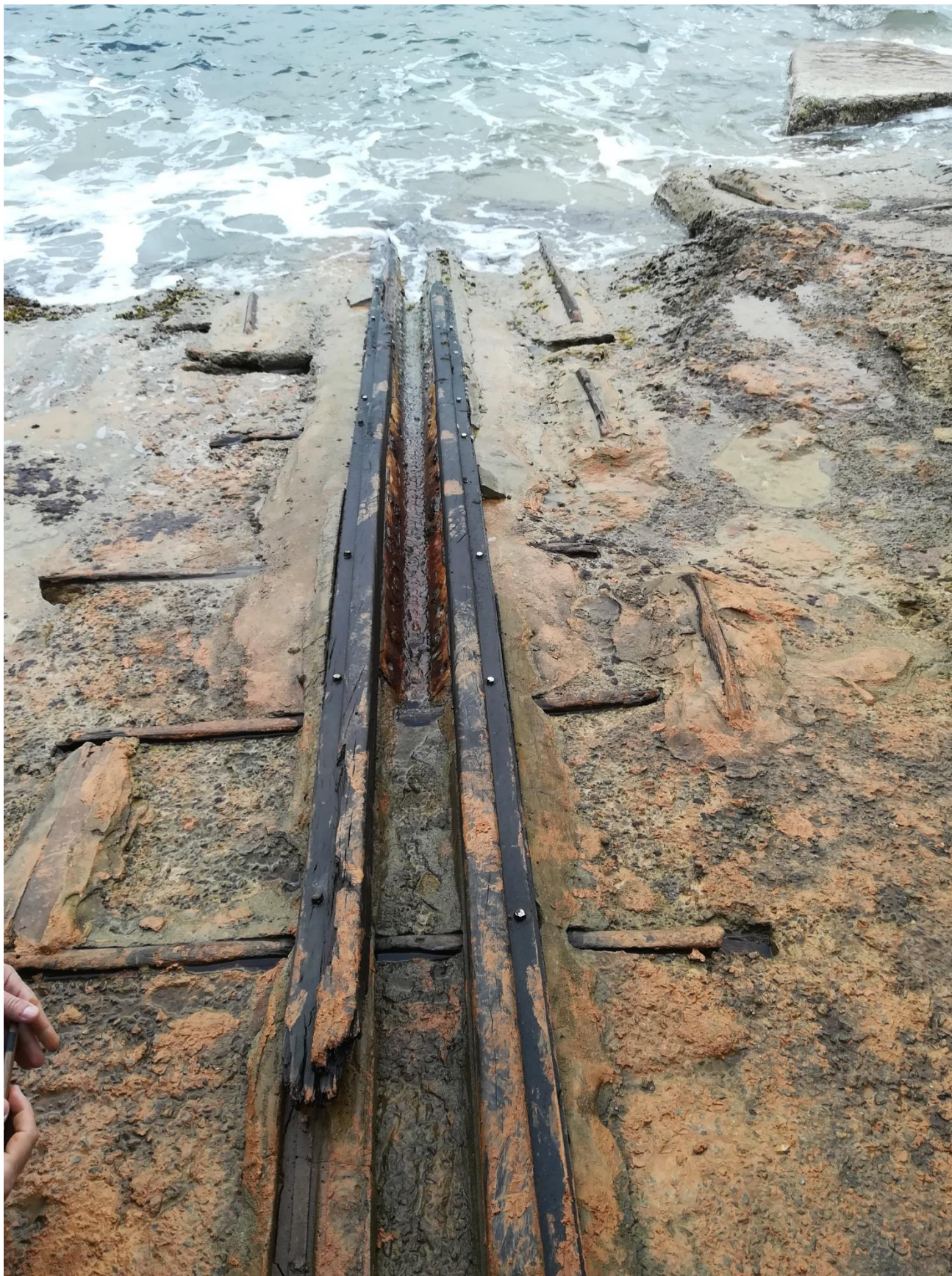
Foto 8. Detalle del arriadero de raíles metálicos y travesaños de madera; y del muelle exterior con superficie regularizada con hormigón.
