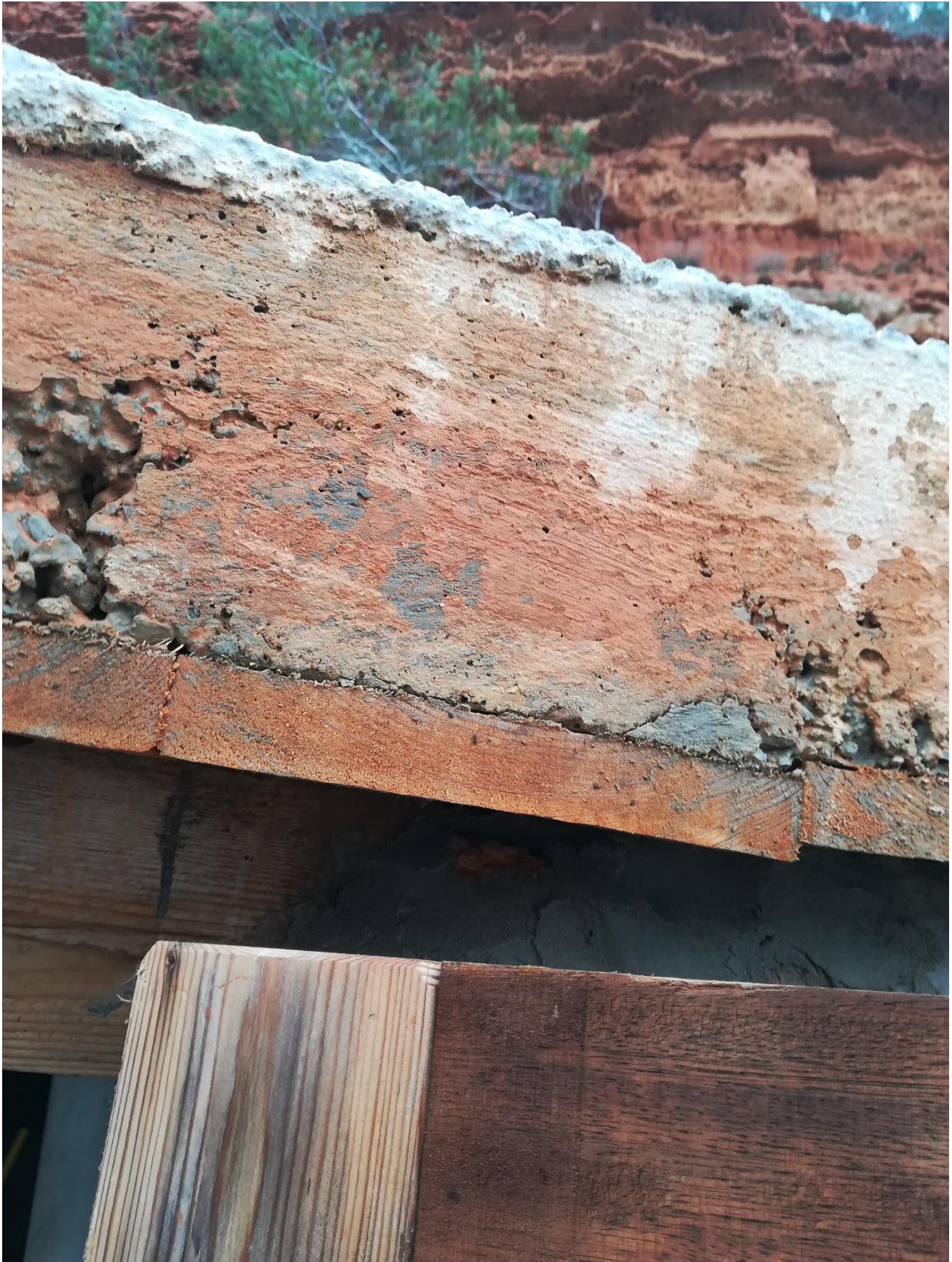
Foto 7. Detalle de la plancha de hormigón y su encofrado, que forman la cubierta exterior.
