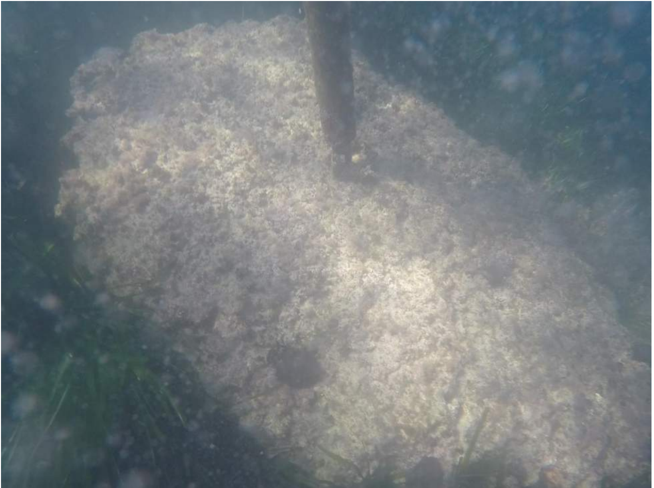
Figura 8.- Cimentación 1º baliza exterior a estribor del canal de navegación.
