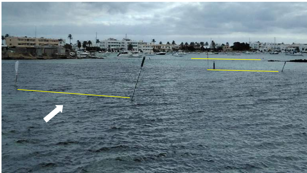
Figura 15.- Vista de la sección del canal de navegación (Desde exterior)
