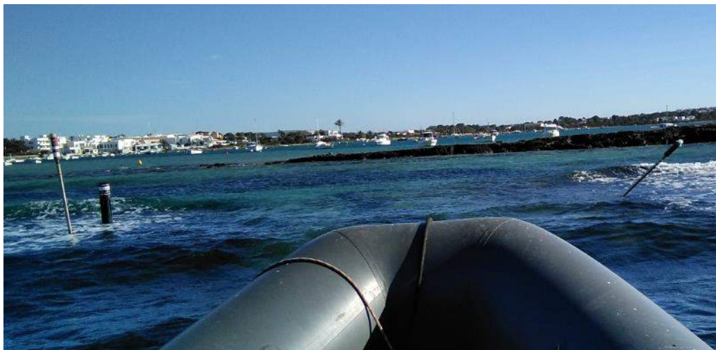
Figura 17.- Vista de la sección canal de entrada (zona rompiente de la ola)
