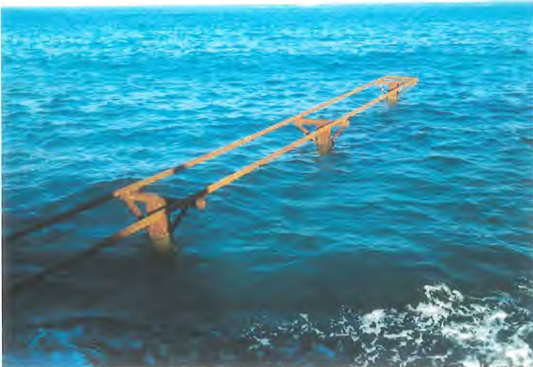
Fotografía 7.- Estructura existente del embarcadero.
