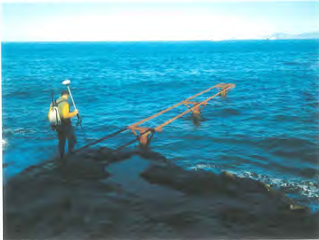
Fotografía 2.- Embarcadero Cavall den Borràs frente al Molí de Sal. La estructura existente arranca desde un tramo rocoso y consiste básicamente en tres pilotes metálicos hincados en el fondo y conectados por un ligero perfil metálico de sección circular. La estructura está oxidada superficialmente.
