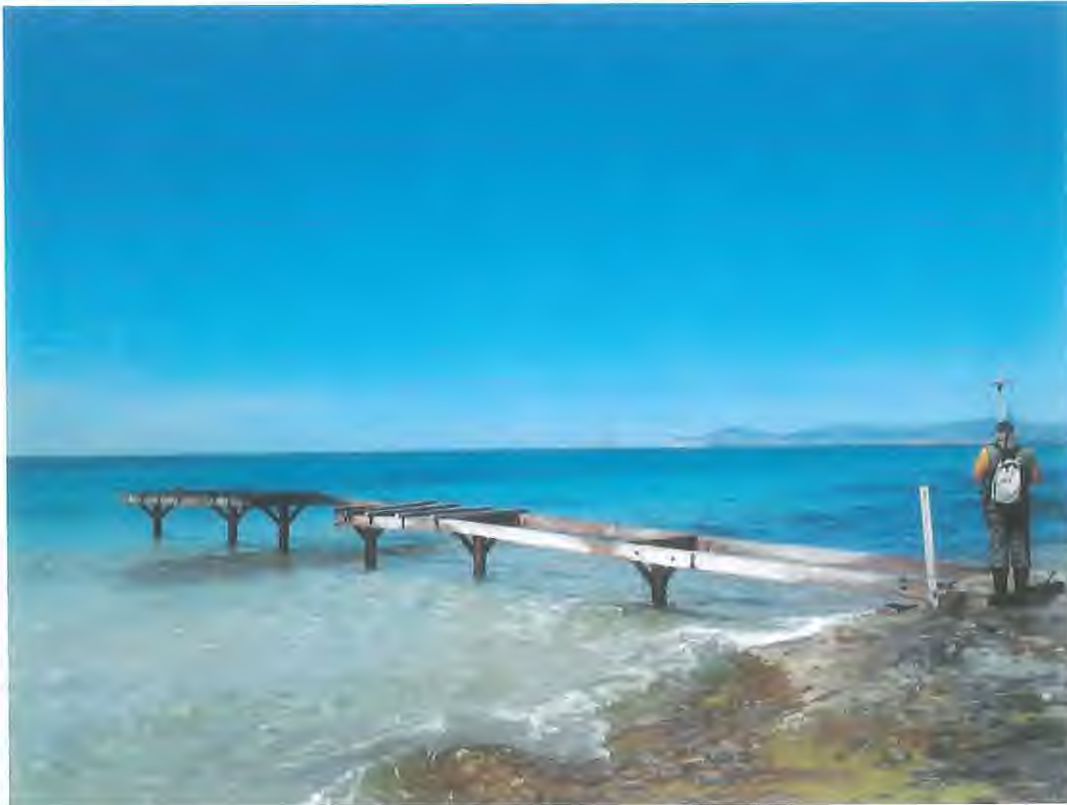
Fotografía 4.- Estructura existente del embarcadero.
