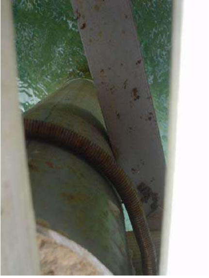
DETALLE AIADO PILAR MEDIANTE BARRA ROSCADA HASTA PLETINA
