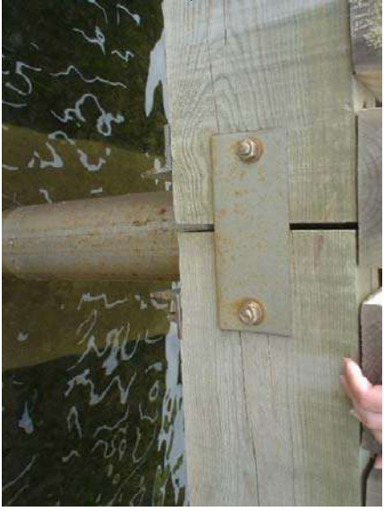
DETALLE PLETINA UNIÓN VIGAS DE MADERA
