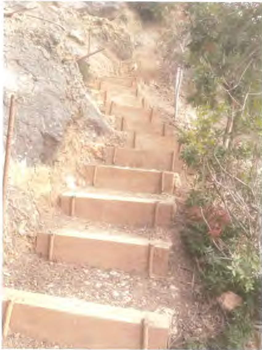
Otro detalle, donde se ve la necesidad de ejecutar un pequeño y discreto muro de contención
