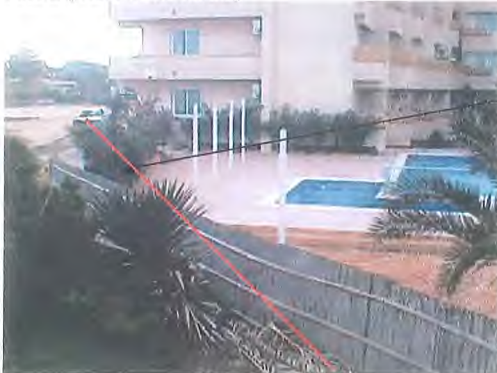
Foto 2 (Vista de la zona C)
