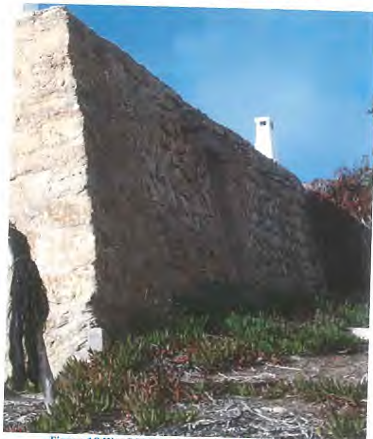
Figura 18 Hito DPMT en la esquina de la edificación
