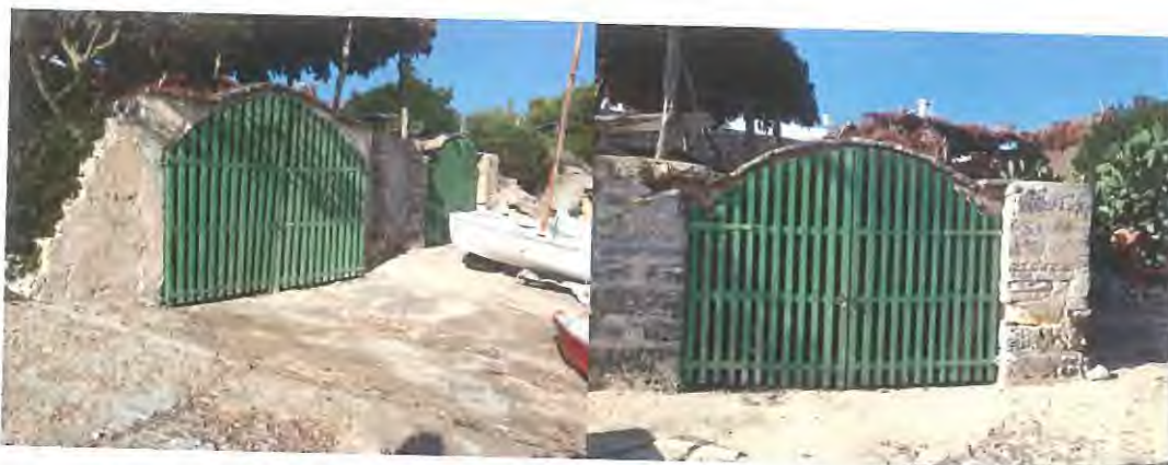
Figura 9 Imagen frontal de las dos casetas guardabotes nº1 y nº2
