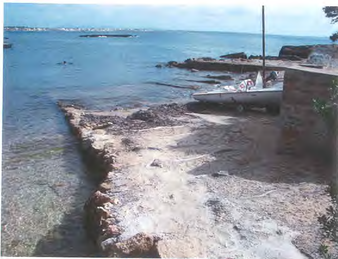
Figura 11 Rampa de izado y caseta guardabotes
