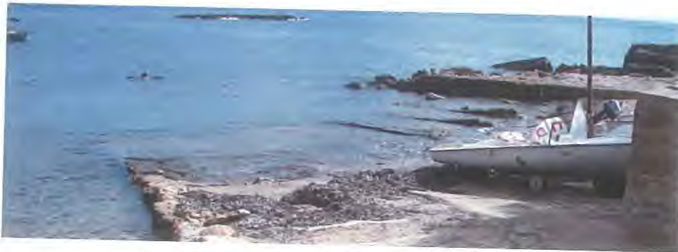
Figura 8 Zona de izado sumergida en el mar
