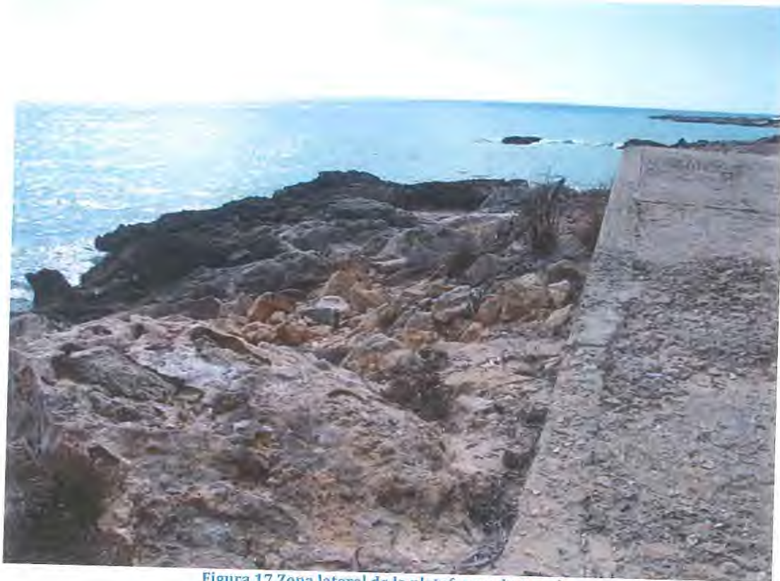
Figura 17 Zona lateral de la plataforma de varado
