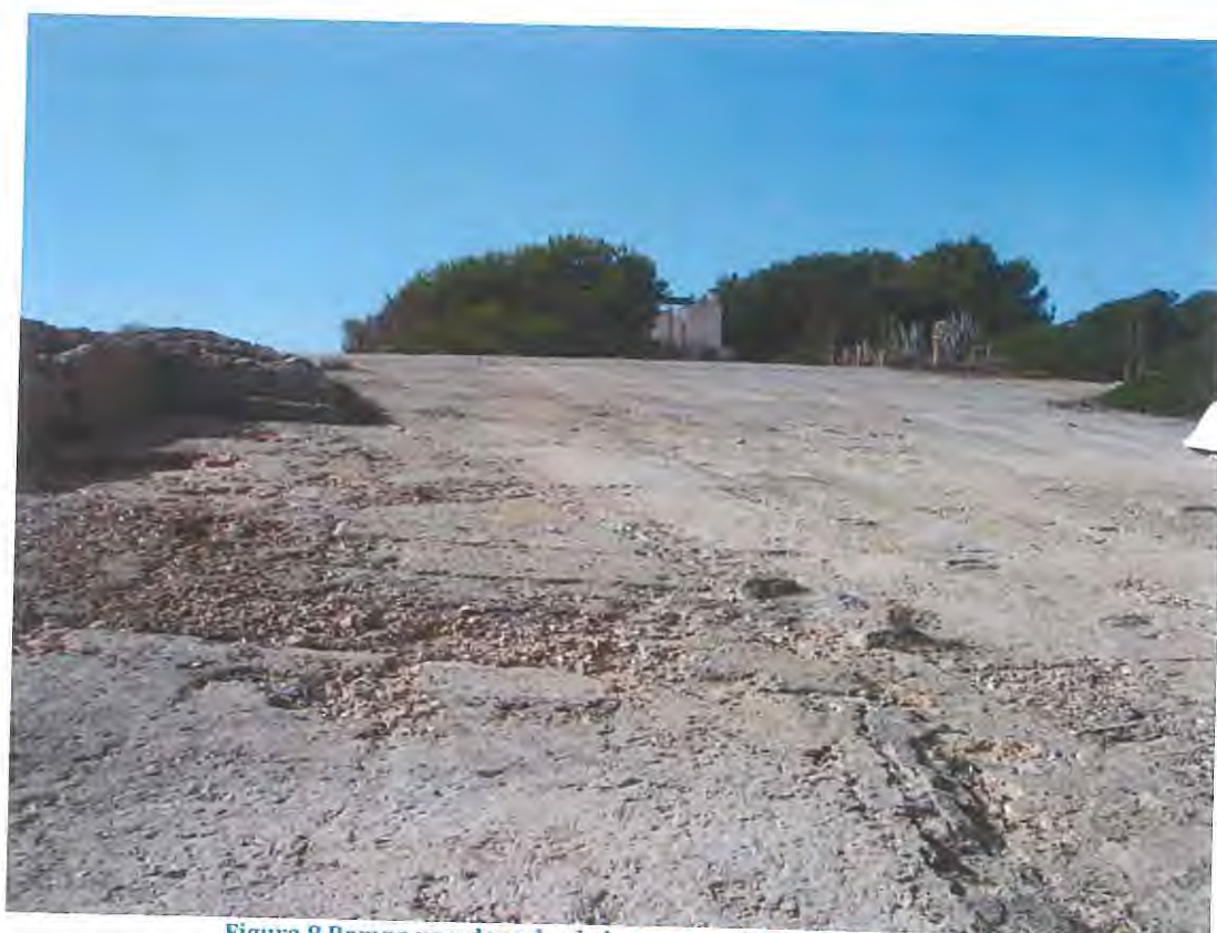
Figura 8 Rampa varadero desde la parte media hasta la parte alta
