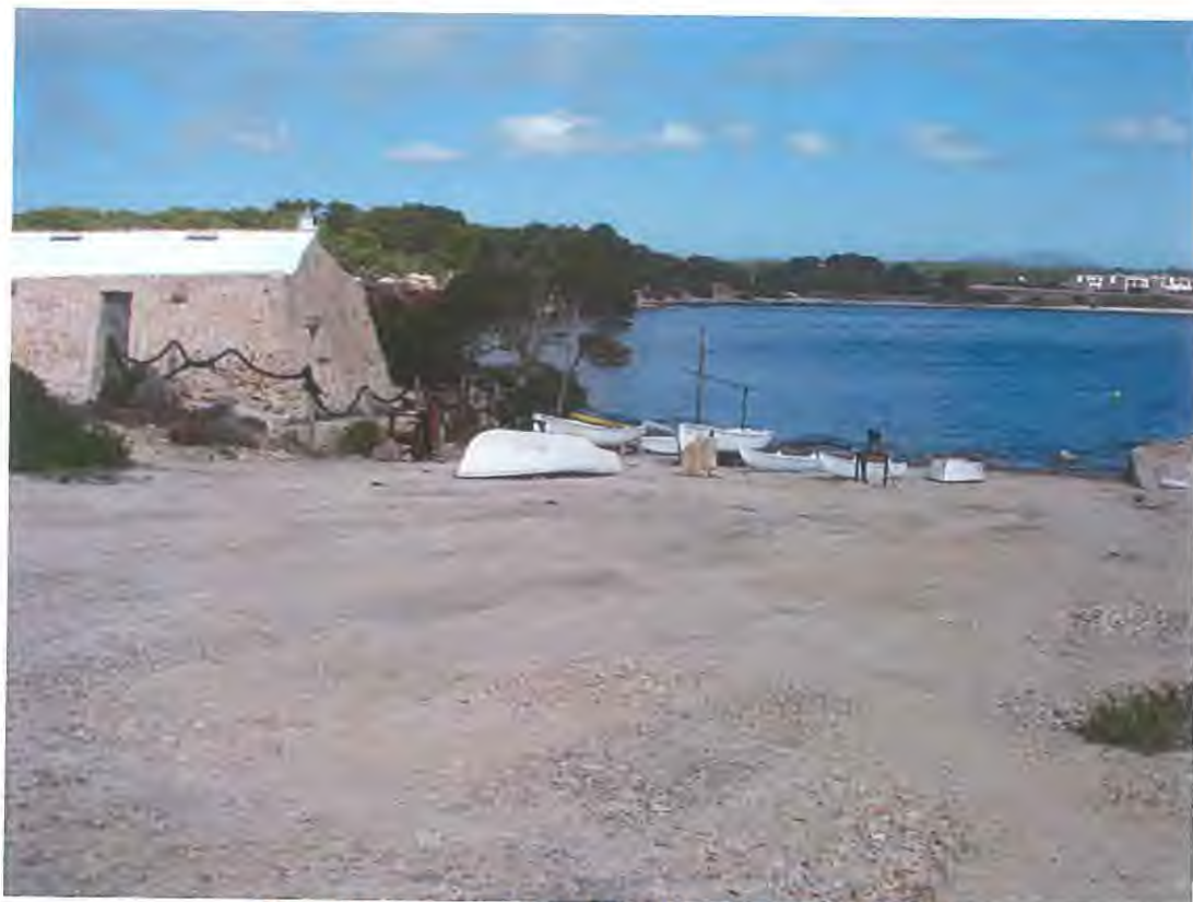
Figura 12 Rampa varadero desde la parte superior lateral
