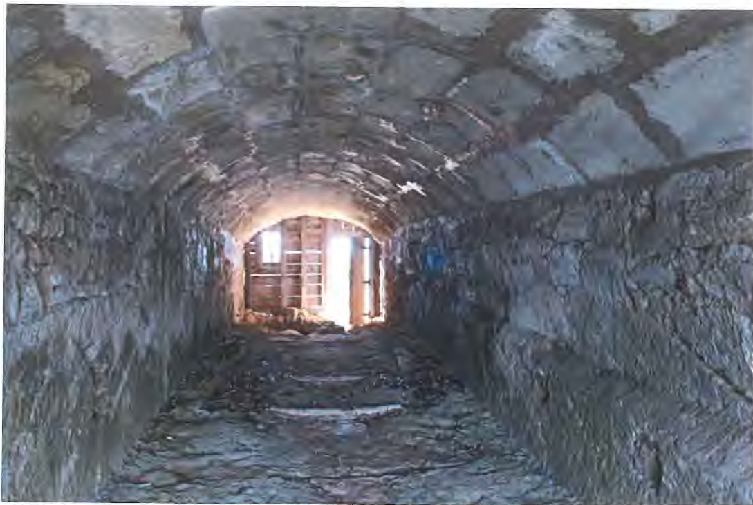
Figura 20 Vista interior desde el frontal
