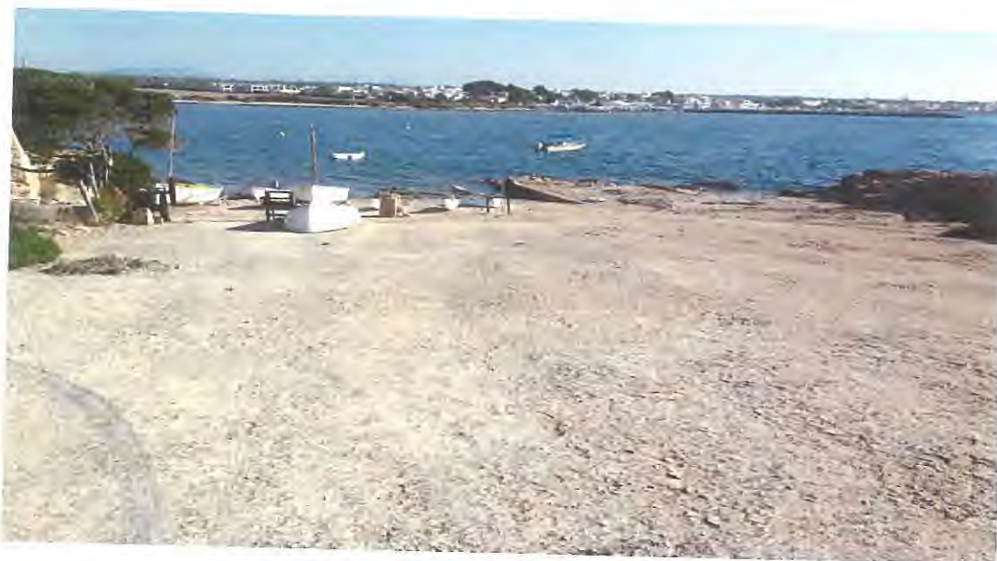
Figura 7 Rampa varadero de hormigón
