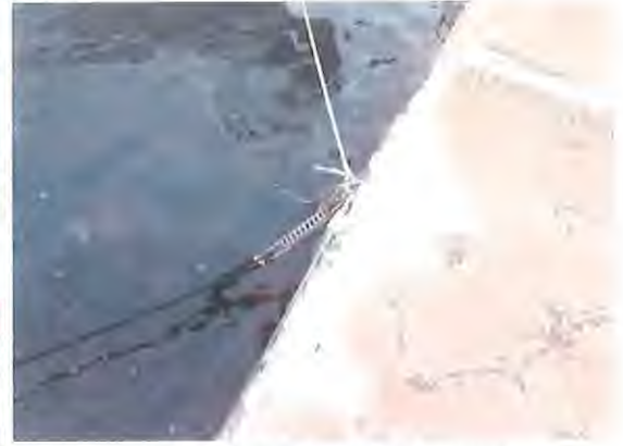
Foto 8.-Elementos de amarre en cantil de pasarela
