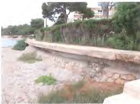
Foto 13.- Sendero litoral, vista murete cemento y plataforma volada
