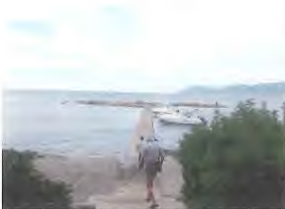
Foto 3.-Vista general de la pasarela desde frente costero
