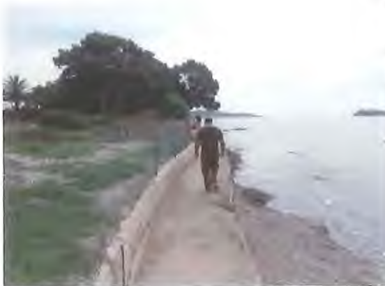
Foto 15.-Sendero litoral, vista murete y verja
