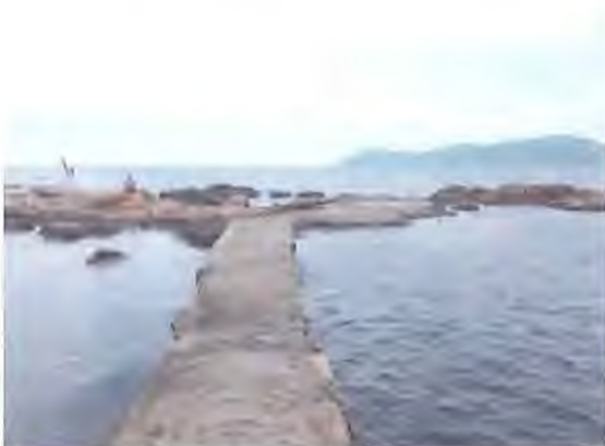
Foto 5.-Tramo final de pasarela hacia el islote
