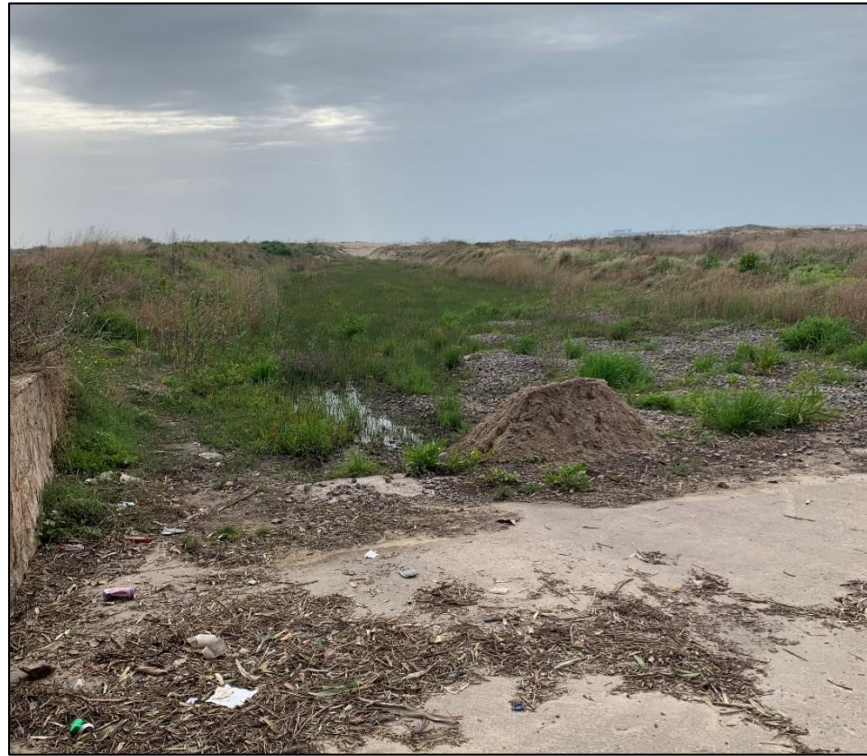
Ilustración 1. Inicio del canal de la Lonja (orientación oeste – este)
