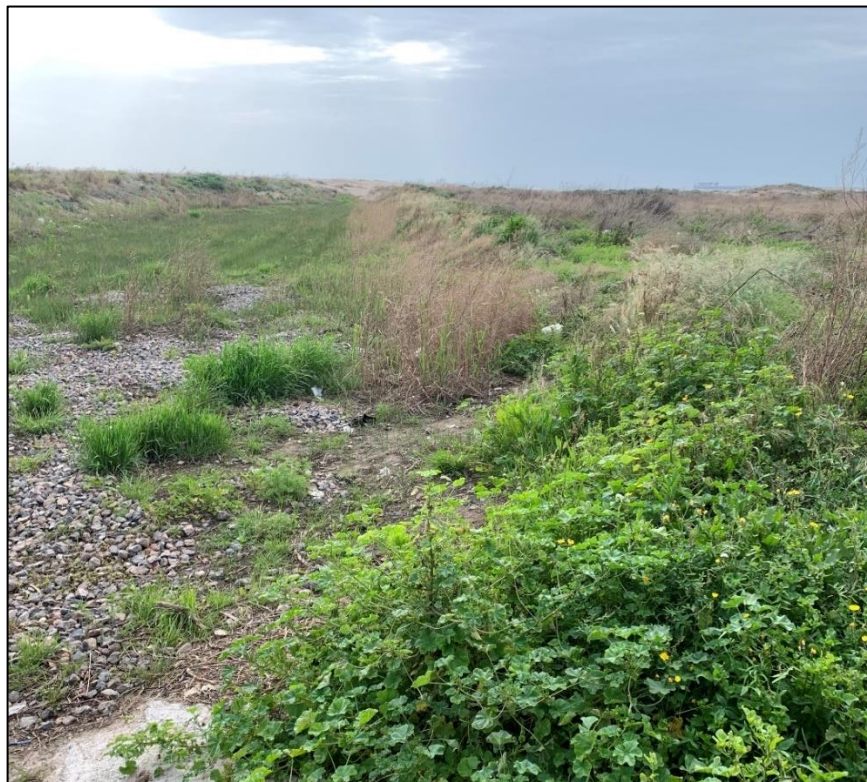
Ilustración 2. Vista del talud sur y fondo del canal de la Lonja (orientación oeste – este)
