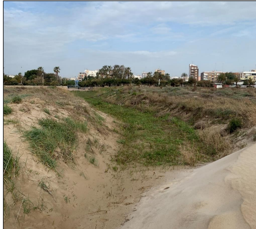
Ilustración 5. Vista del estrechamiento final del canal (orientación este – oeste)
