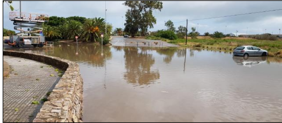
Ilustración 3. Acumulación de agua pluvial en la zona previa al canal
