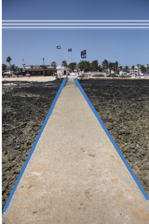
Trazado de la rampa delimitada por el encofrado del recrecido para la mejora.
