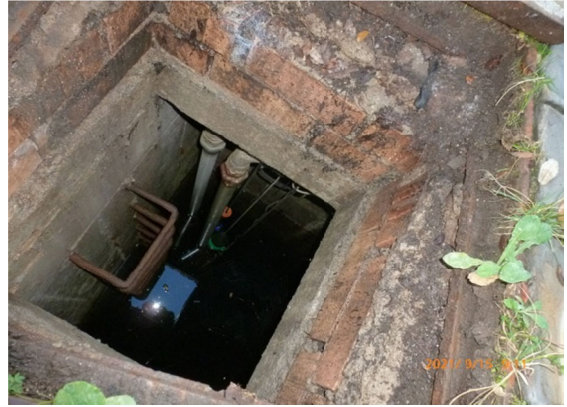
Interior pozo bombeo.
