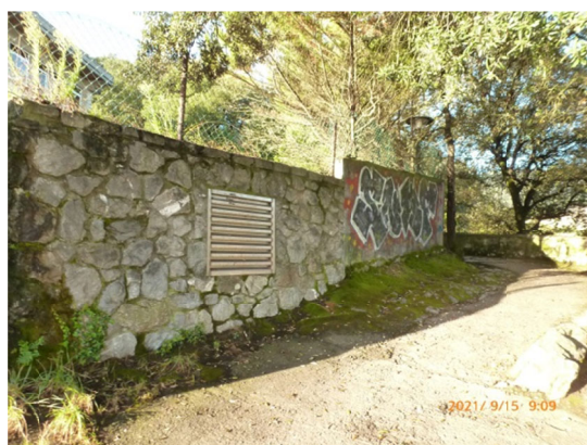
Final paseo peatonal lado norte de la isla
