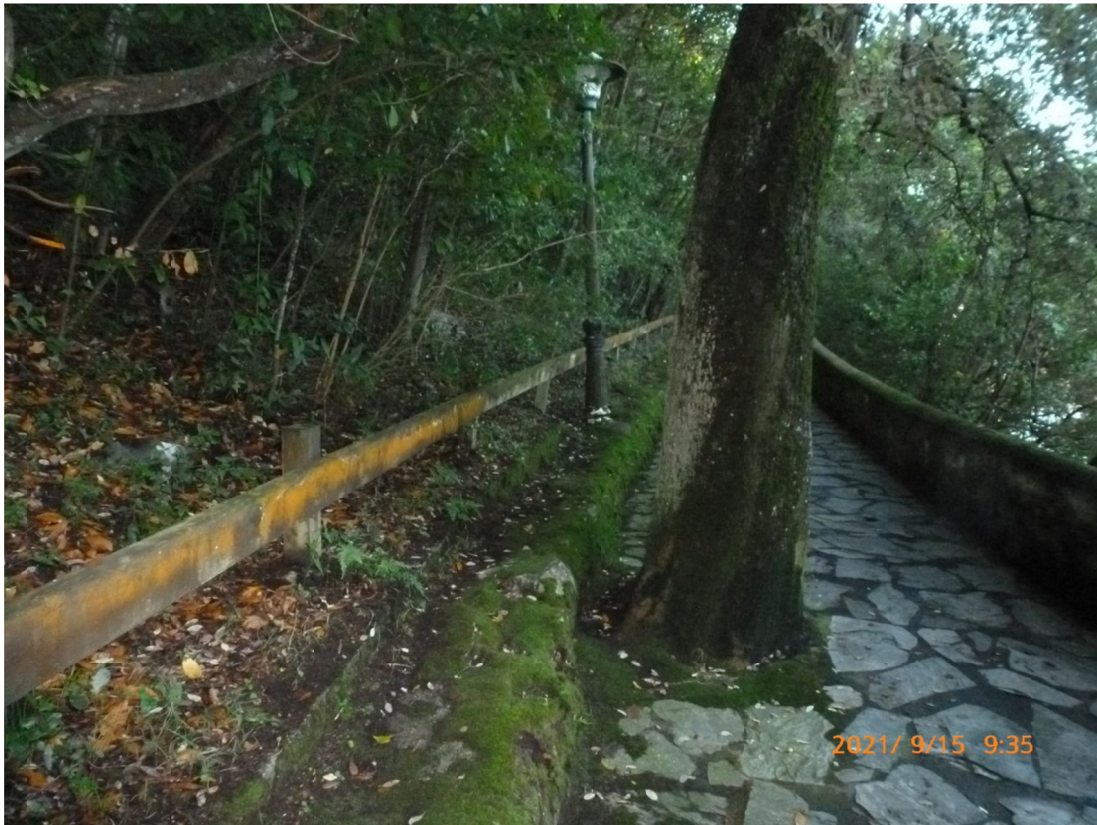
Fotografía n° 4: Paseo peatonal lado monte
