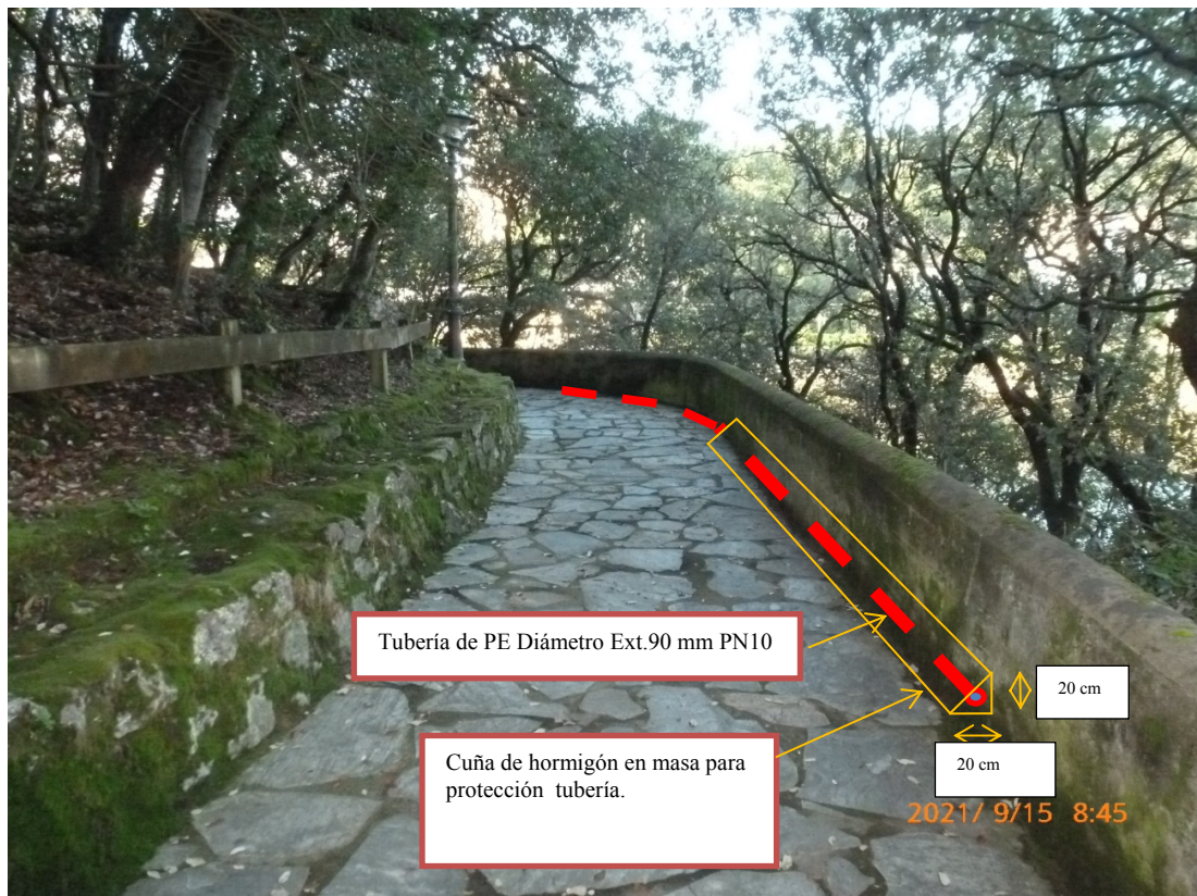
Fotografía n° 3: Paseo peatonal y tubería IMPLANTACIÓN TUBERIA PEHD DE.90- PN10 EN PASEO PEATONAL
