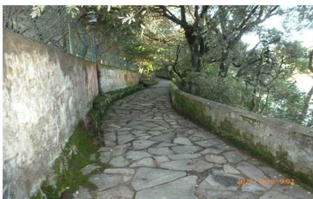
Paseo peatonal muro de separación lado bombeo
