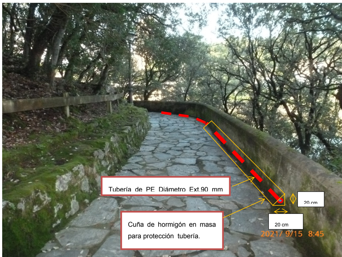
Fotografía n° 3: Paseo peatonal y tubería
