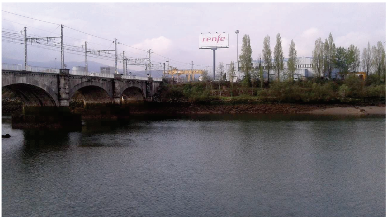
Vista a Puente de Adif desde Hendaya
