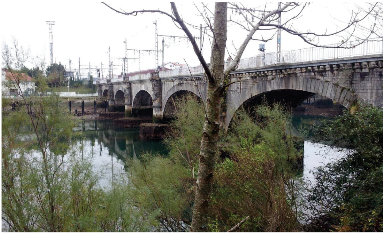
Vista a Puente de Adif desde sendero existente
