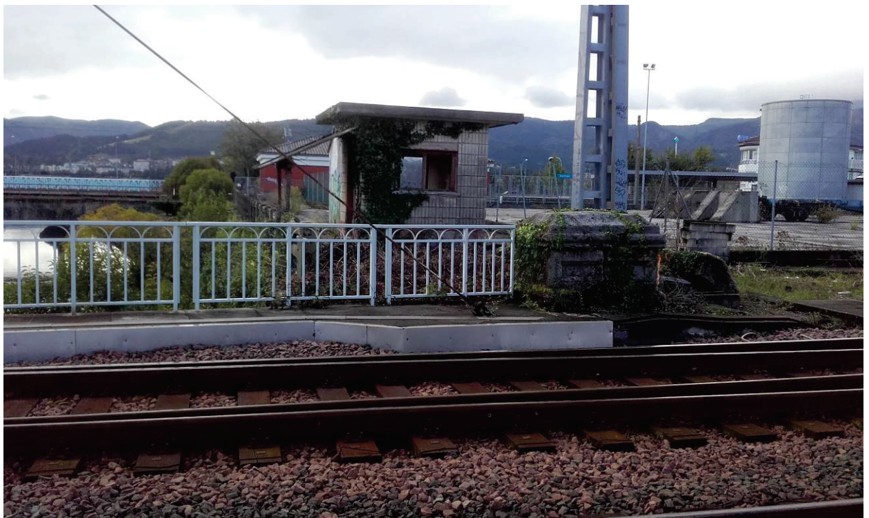
Vista de antigua caseta de control fronterizo
