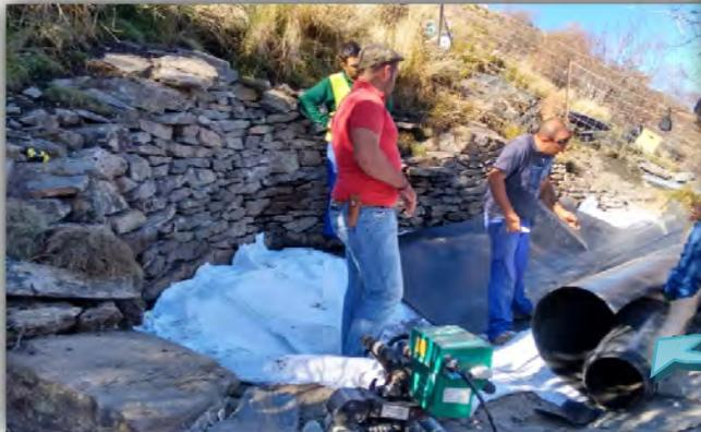
*Construcción de los muretes e impermeabilización*
