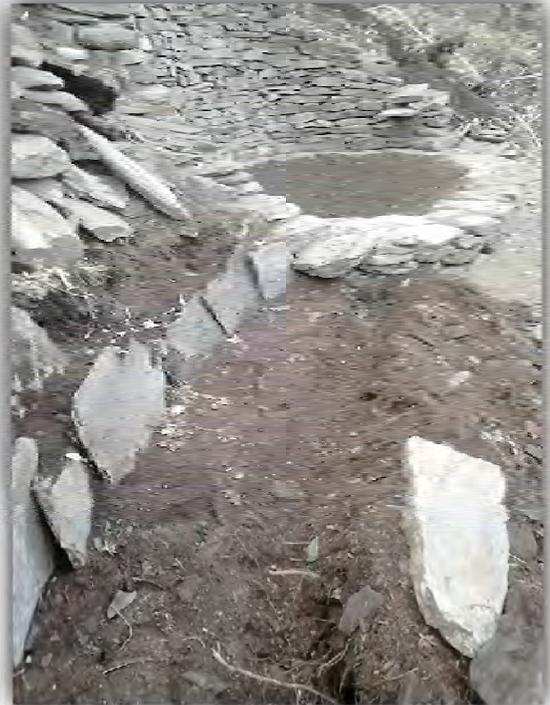
*Preparación del encachado para la salida del agua de la balseta*
