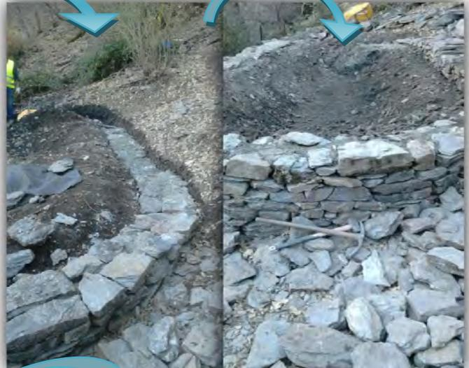
*Cimentación, construcción de muretes y excavación de la balsa*
