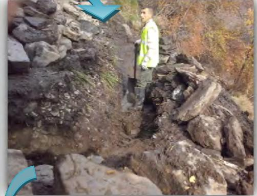
*Excavación de la balsa y cimentación en muro inferior*
