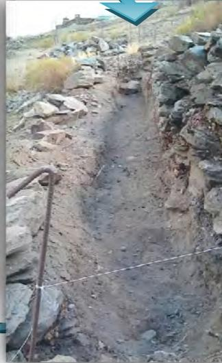
*Cimentación y excavación para la toma*
