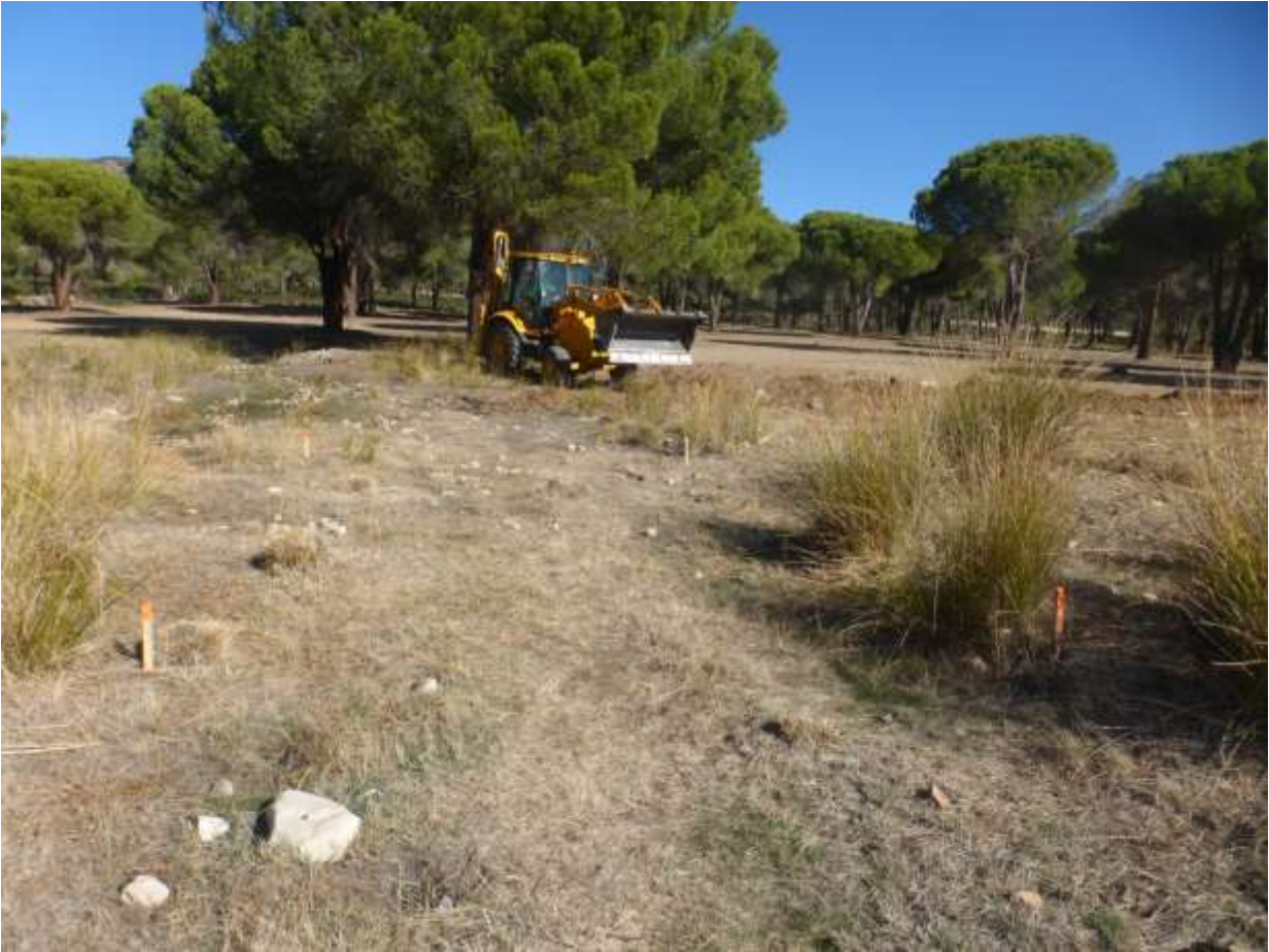
Inicio trabajos de apertura y explanación de tierras
