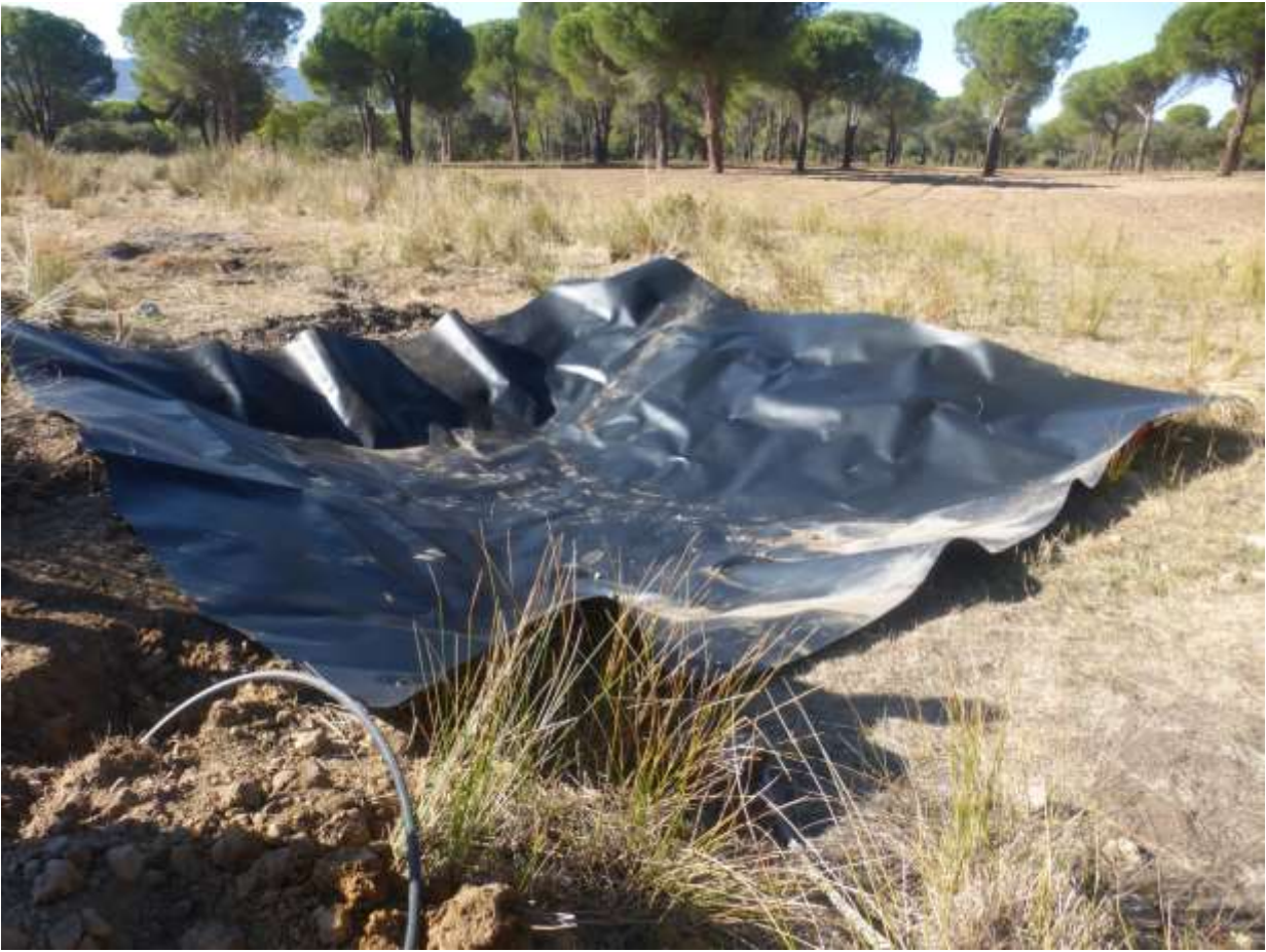
Impermeabilización de la balsa
