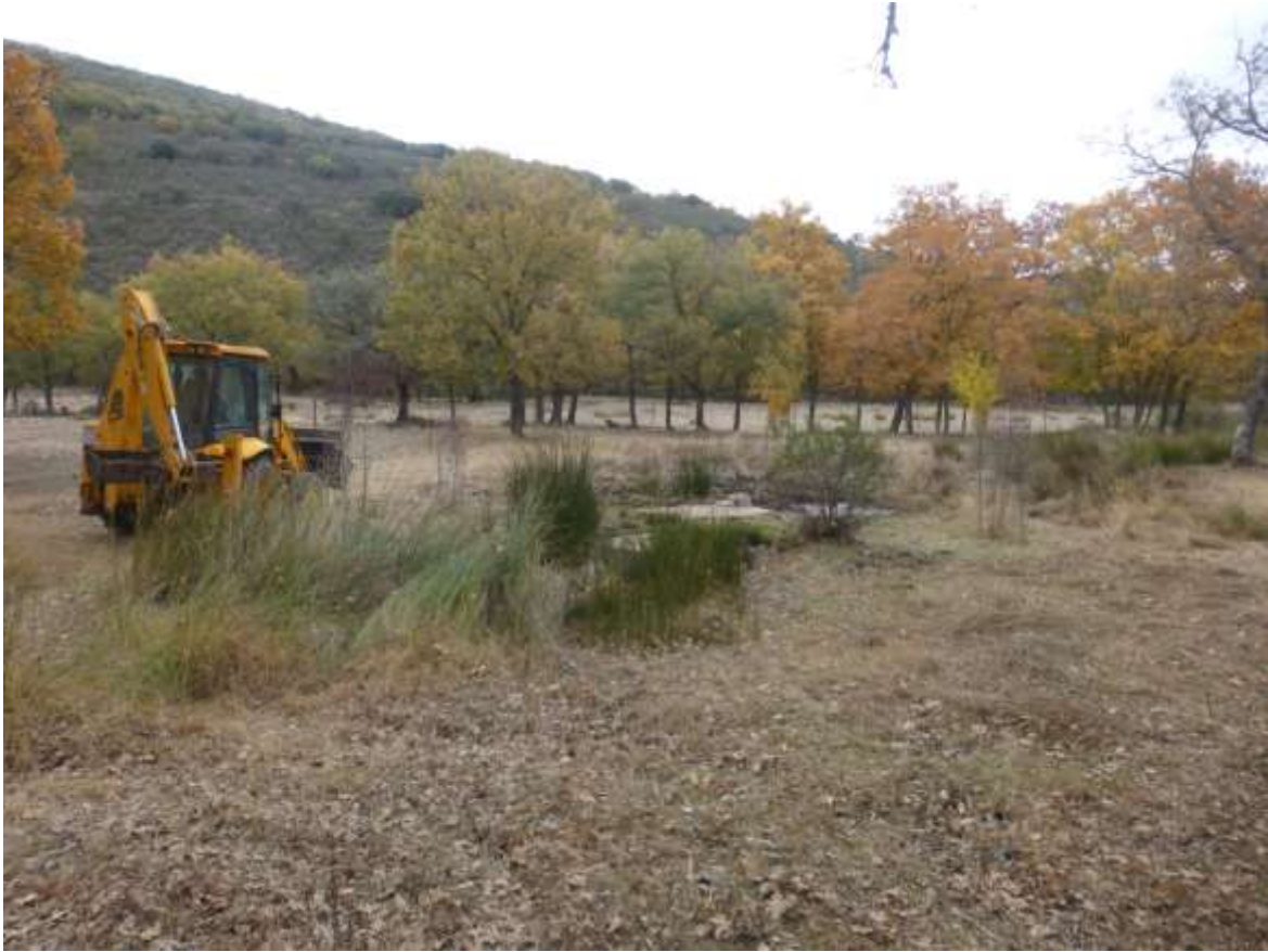
Inicio trabajos de movimiento de tierras
