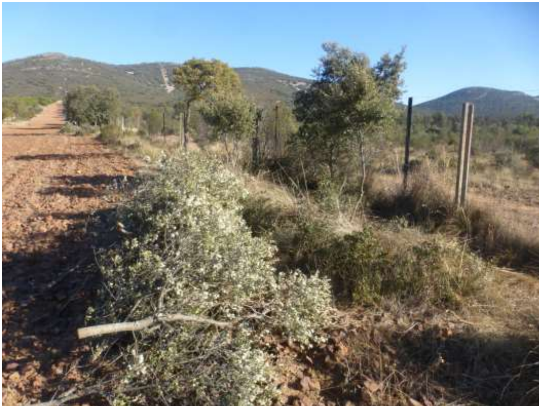
Trabajos de resalveo: Preparación de madera, recogida, saca y apilado de residuos
