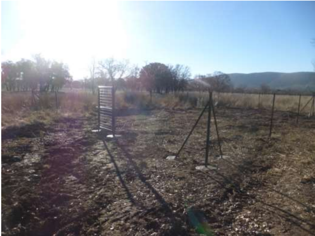
Instalación de postes para cerramiento malla cingética y puerta de paso
