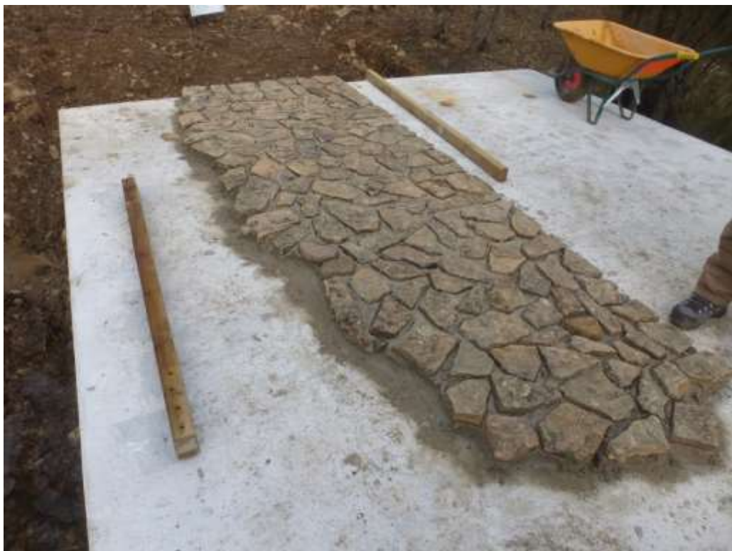
Ejecución chapado de piedra
