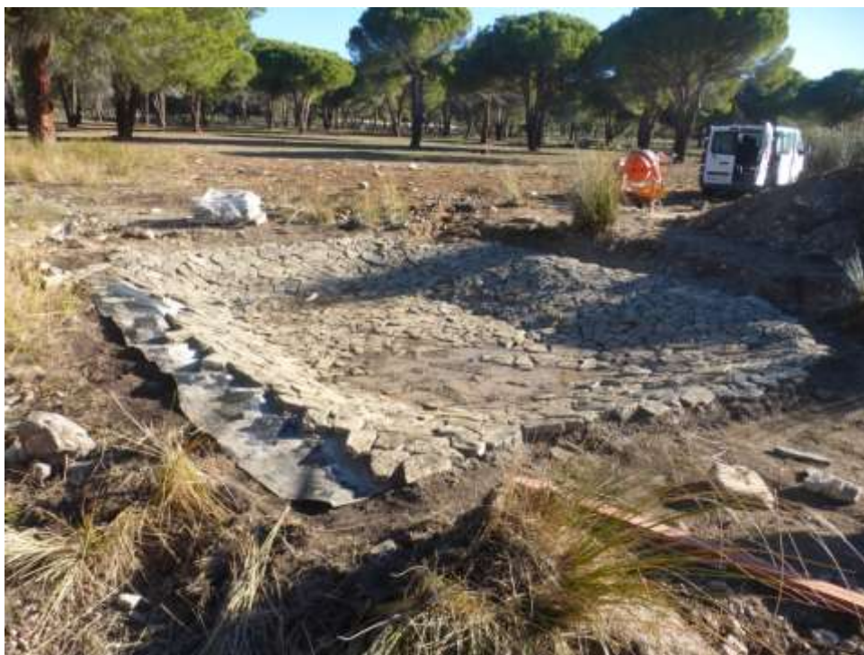
Ejecución de mampostería
