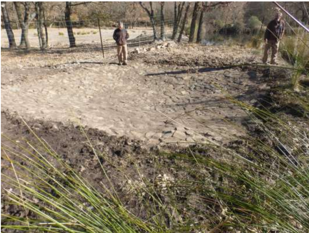
Ejecución de mampostería
