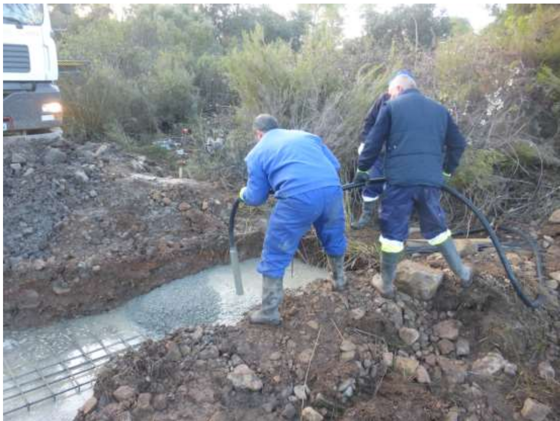
Trabajos de hormigonado de zapatas de cimentación
