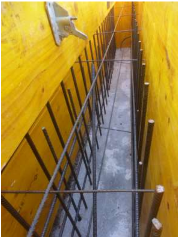
Encofrado y hormigonado de estribos
