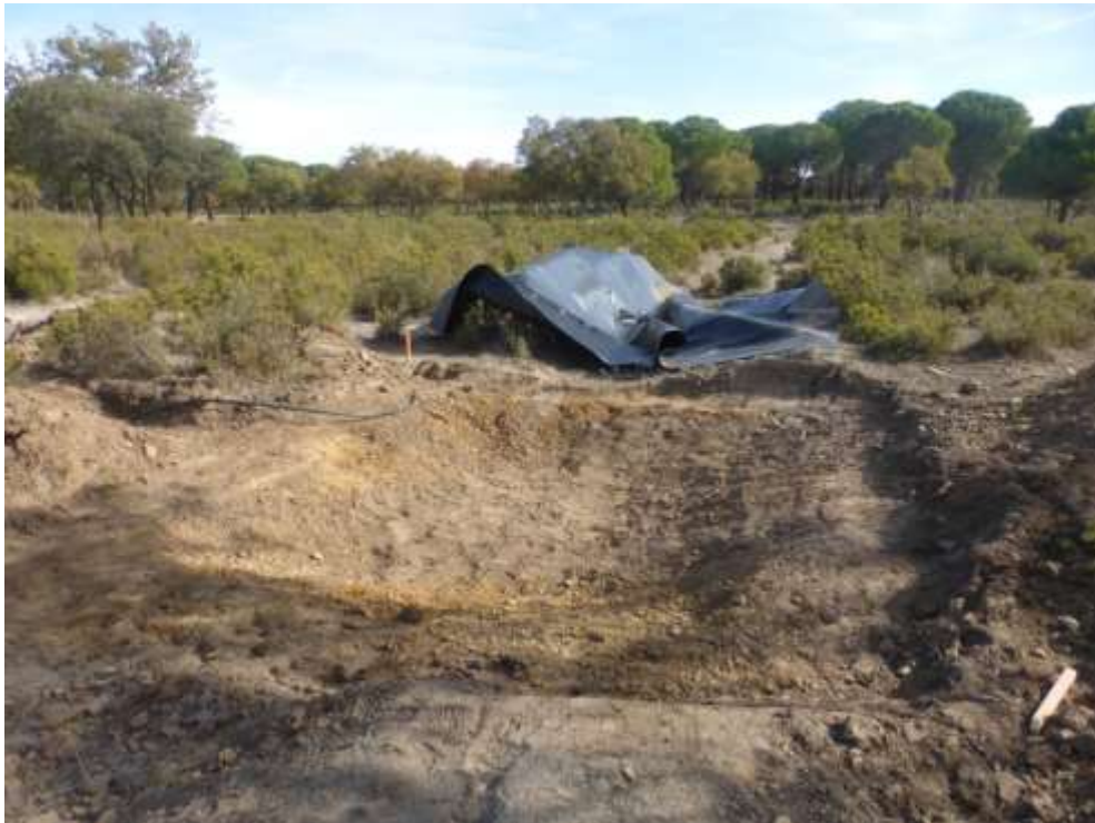
Trabajos de preparación de la impermeabilización de la balsa
