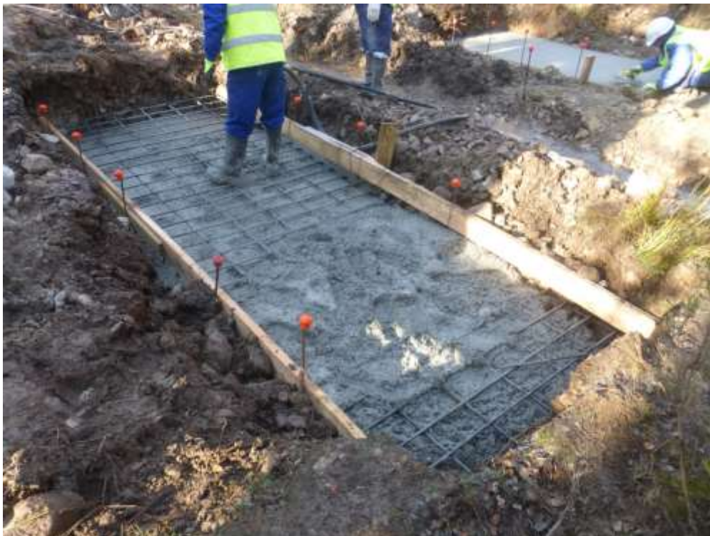
Encofrado y hormigonado de zapatas de cimentación
