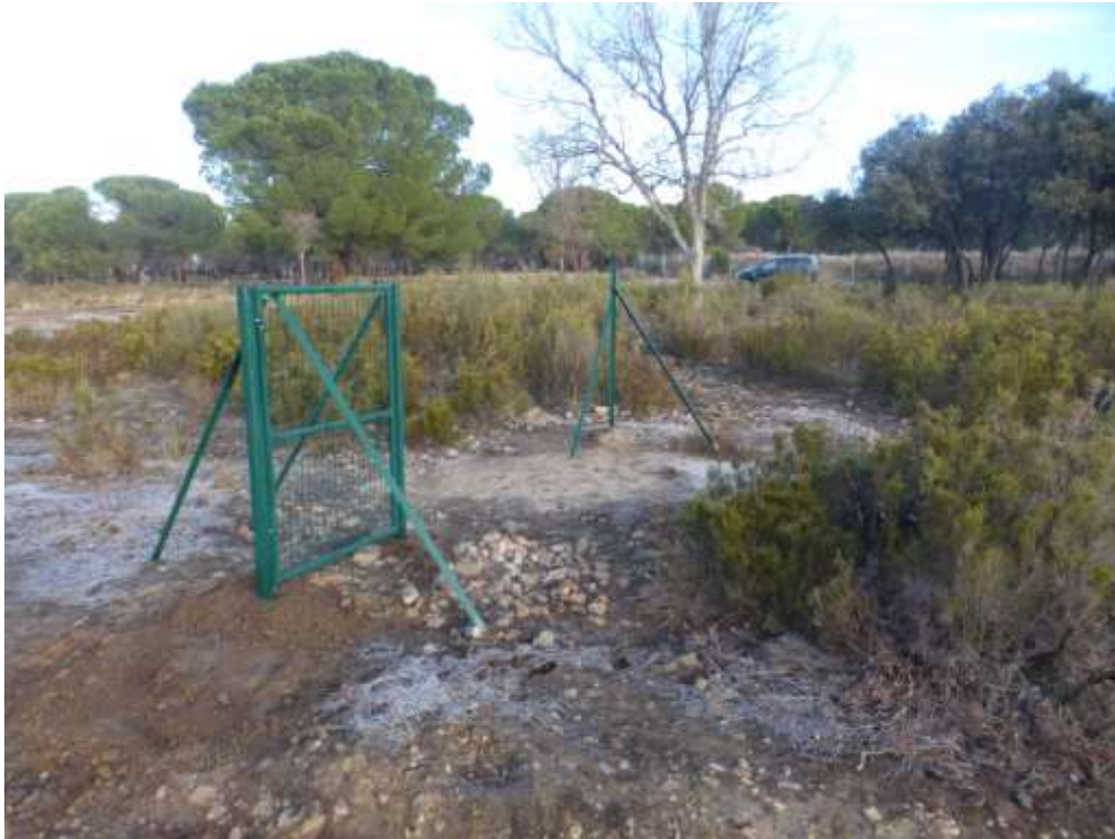
Instalación de portes para cerramiento con malla cinegética y puerta de paso
