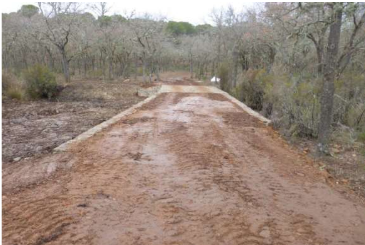
Recogida, explanación, extendido y relleno de accesos al paso
