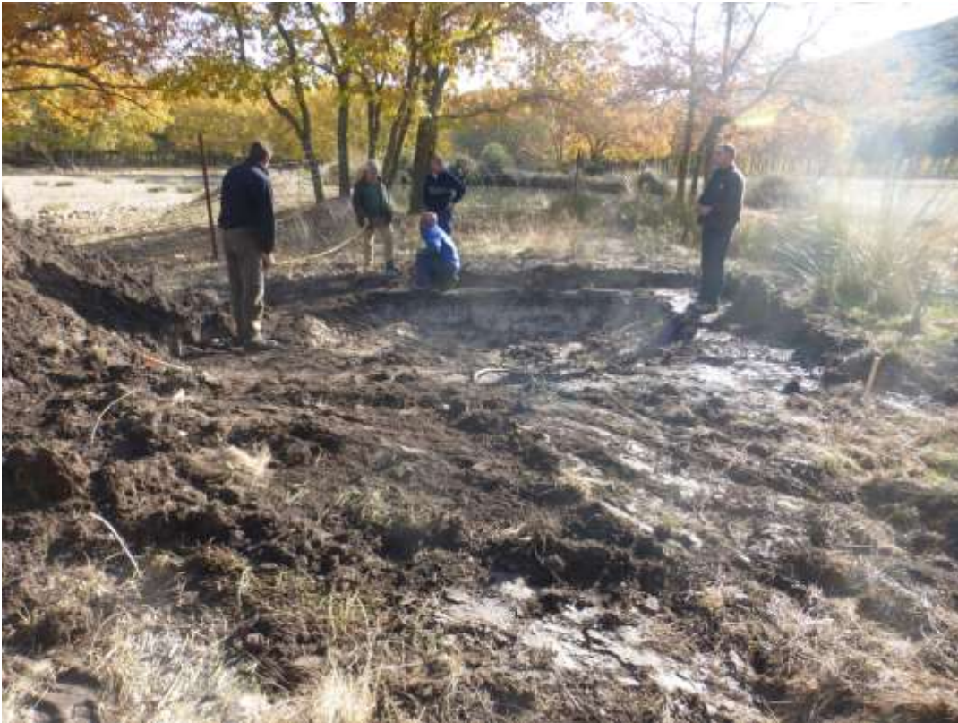
Trabajos de replanteo
