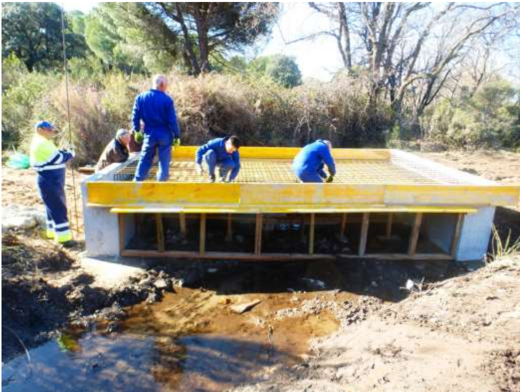
Encofrado de pavimento de losa
