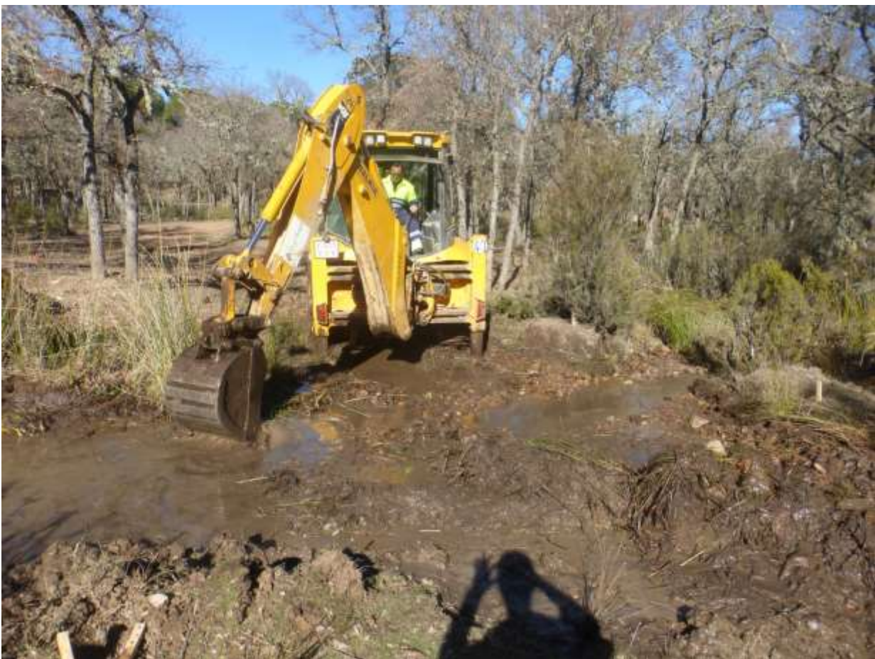
Excavación mecanizada de zanja
