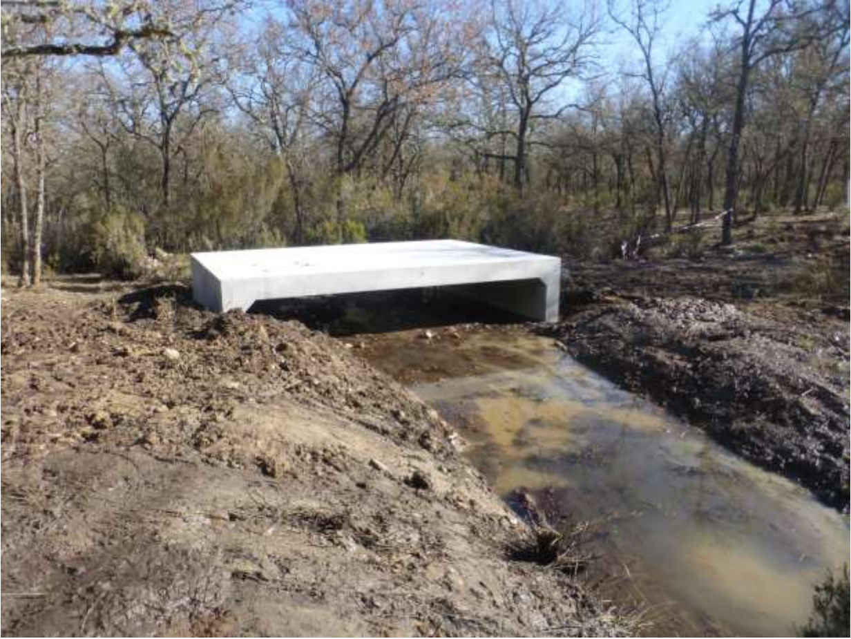
Estructura del paso de agua en hormigón
