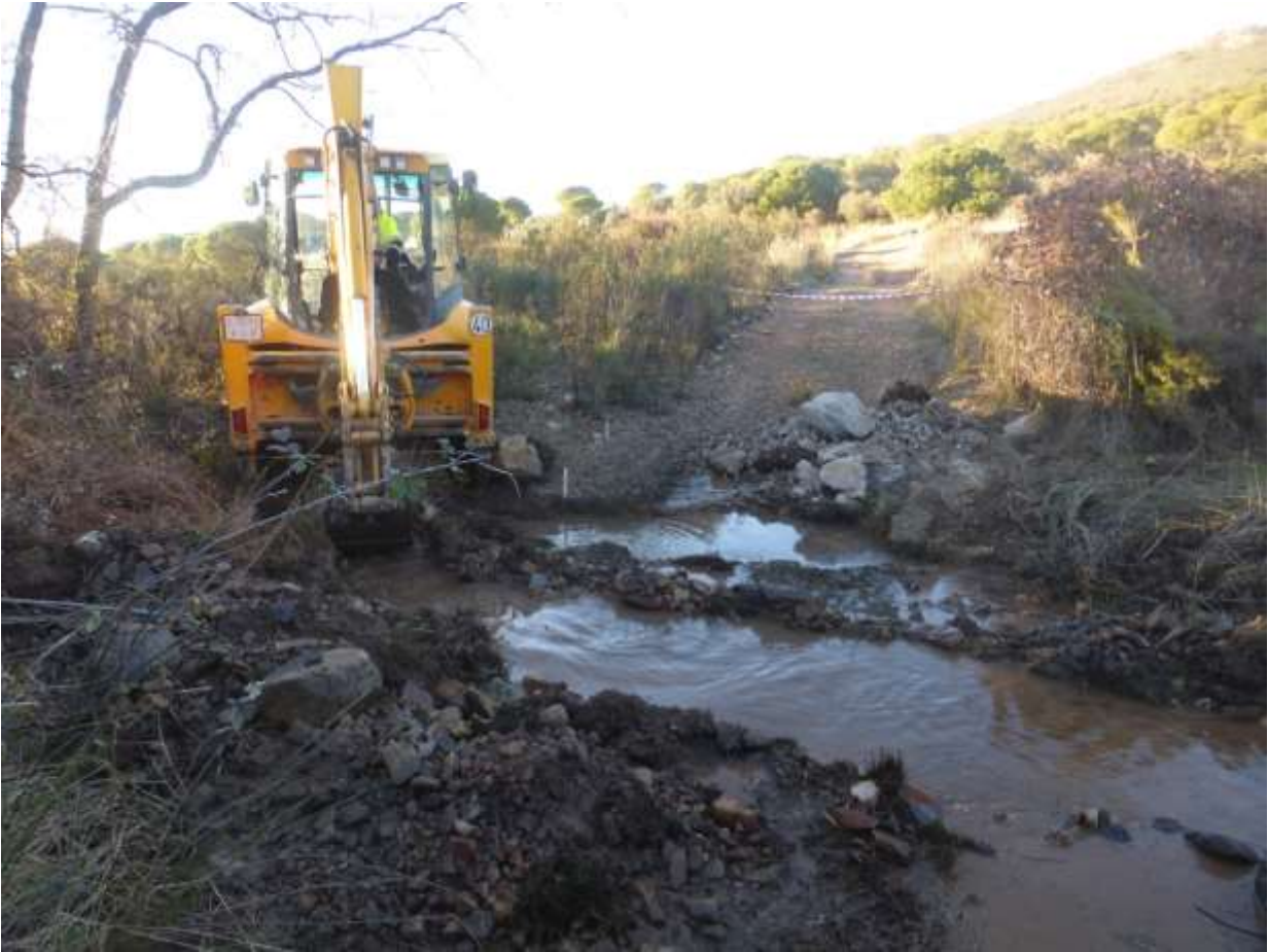
Excavación mecanizada de zanja
