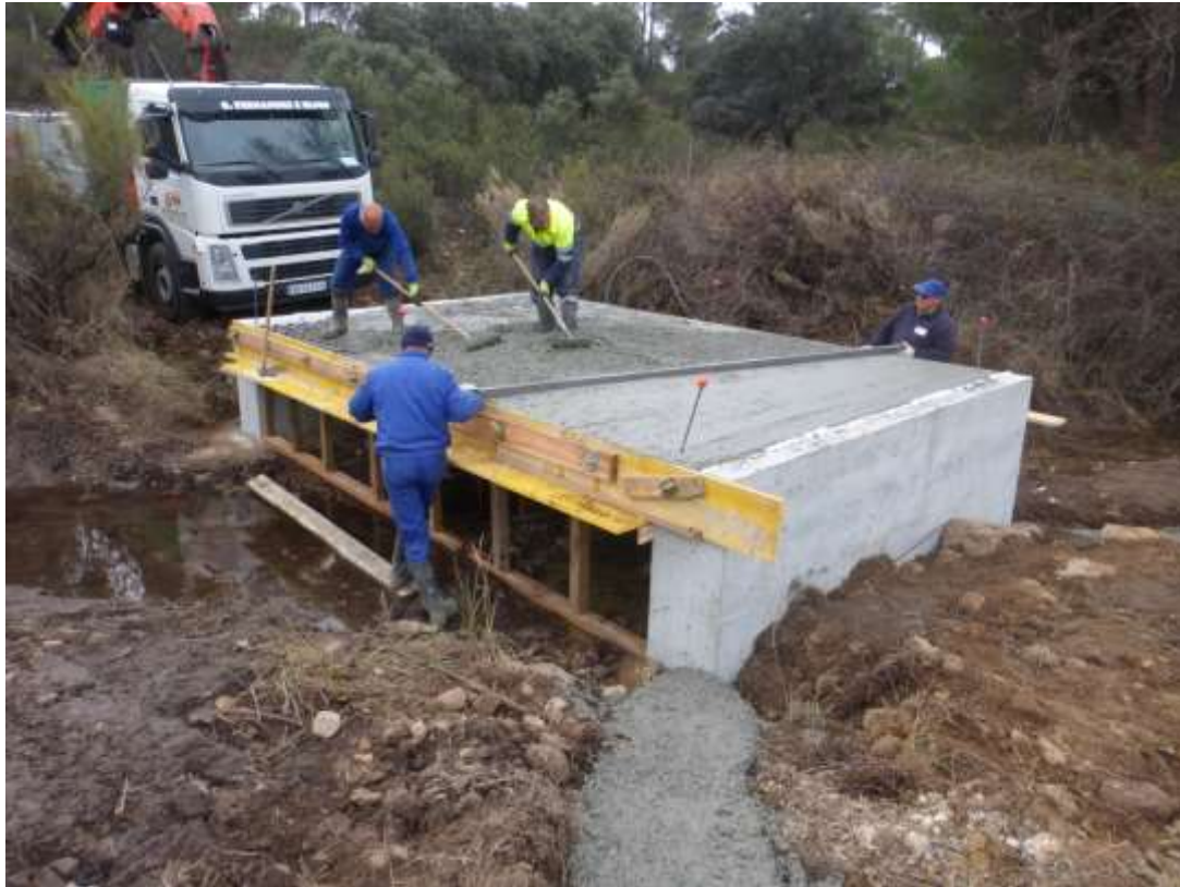
Hormigonado de losa
