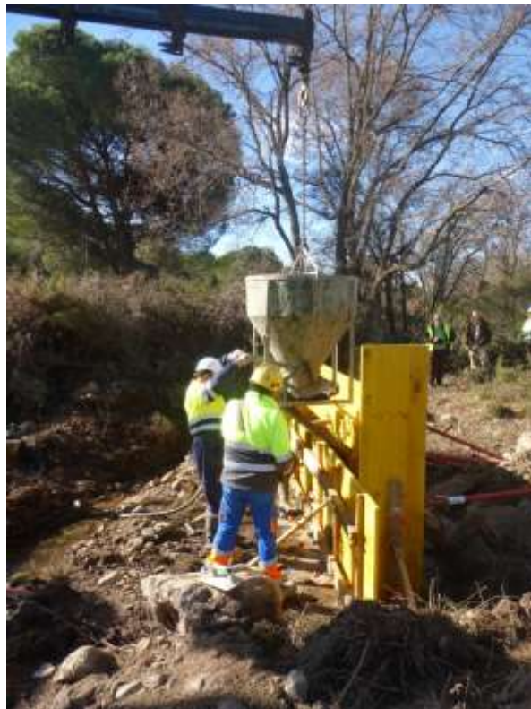
Encofrado y hormigonado de estribos
