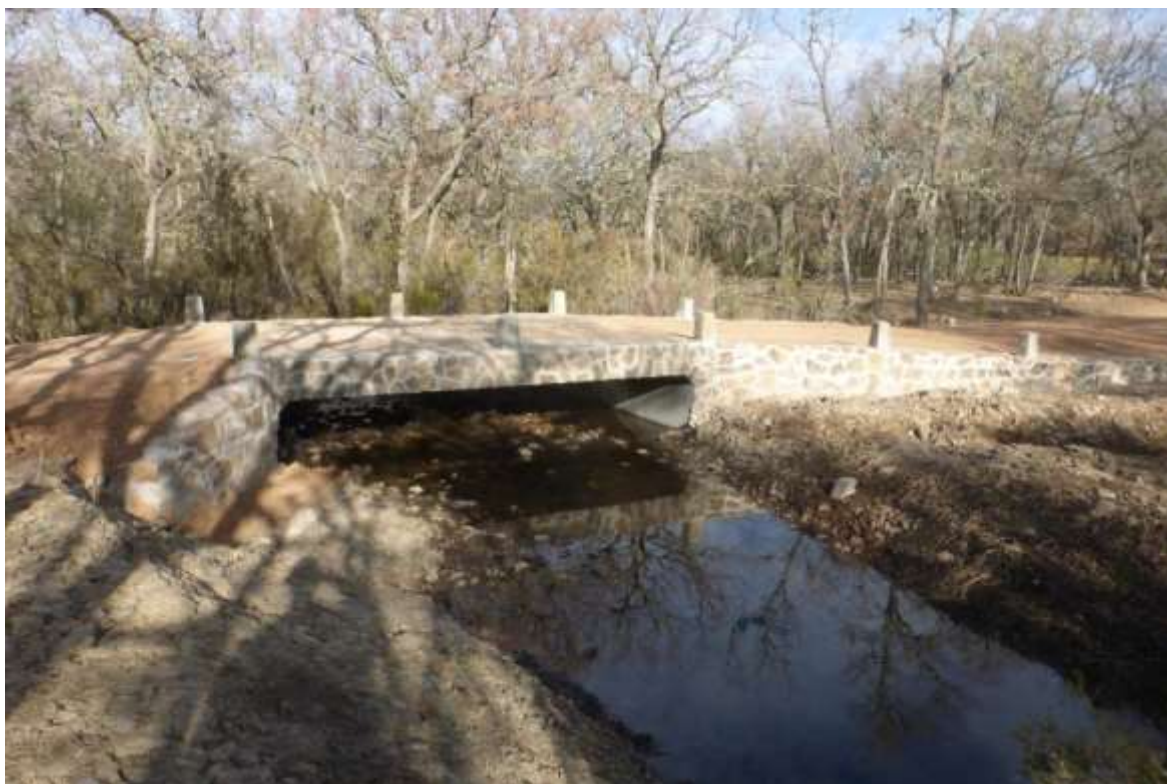
Paso de agua finalizado
