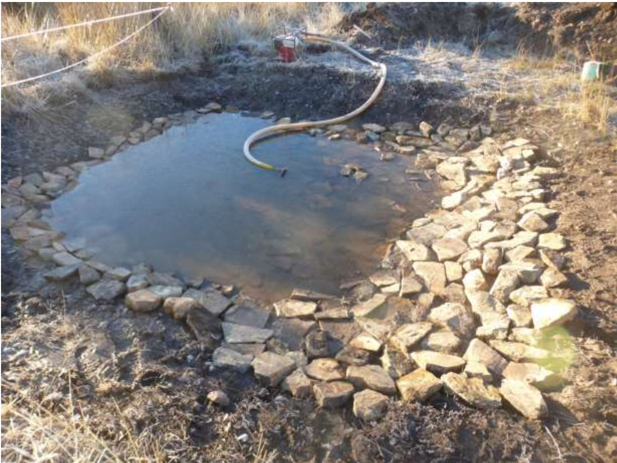
Ejecución de mampostería
