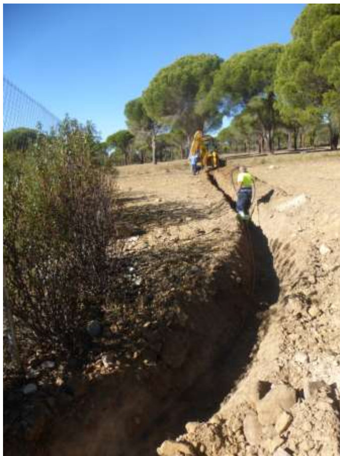
Excavación mecánica de zanjas para tuberías
