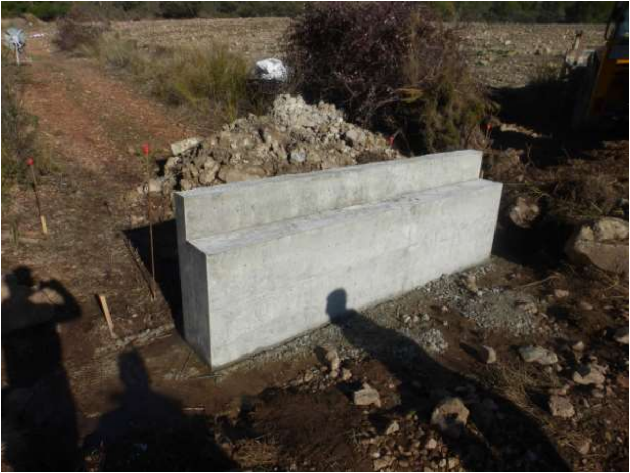
Acabado de estribos
