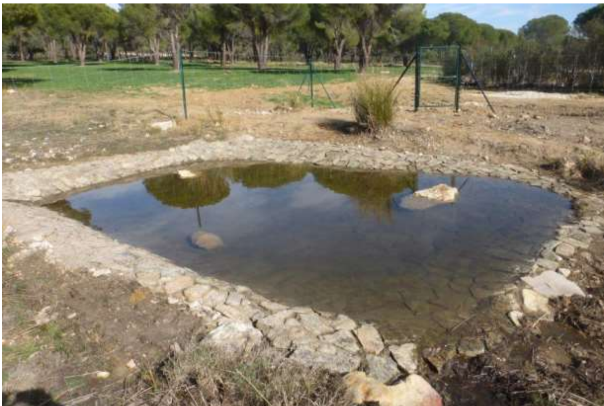
Estado final de la charca con Cerramiento malla cinegética y Puerta de paso
