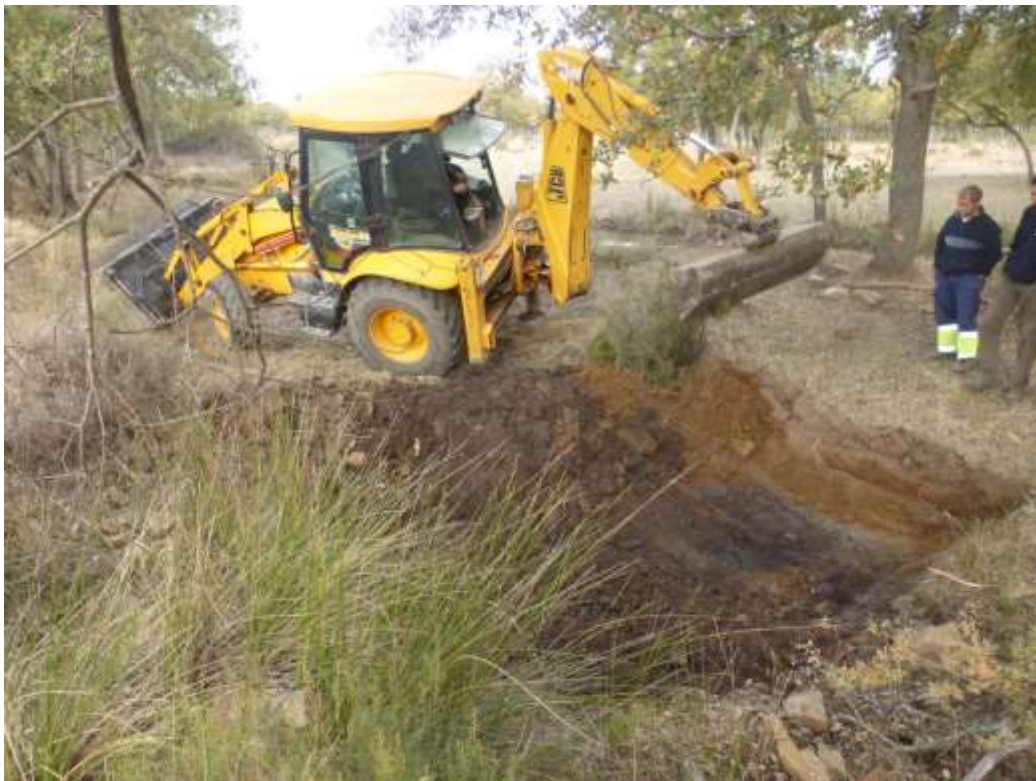
Apertura de charca: excavación de tierras
