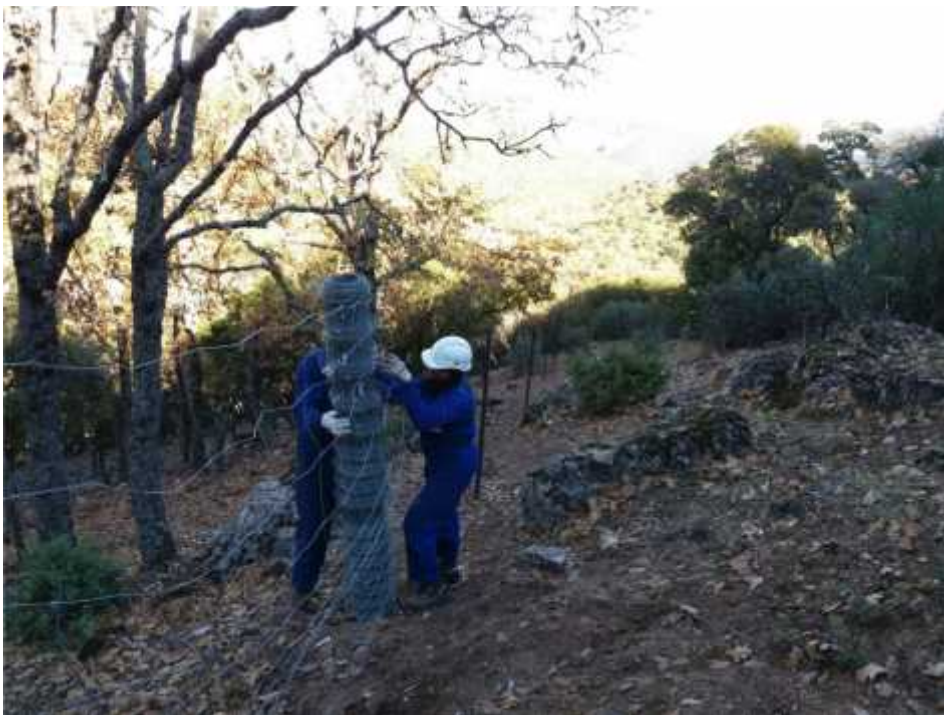
Reparación de malla perimetral
