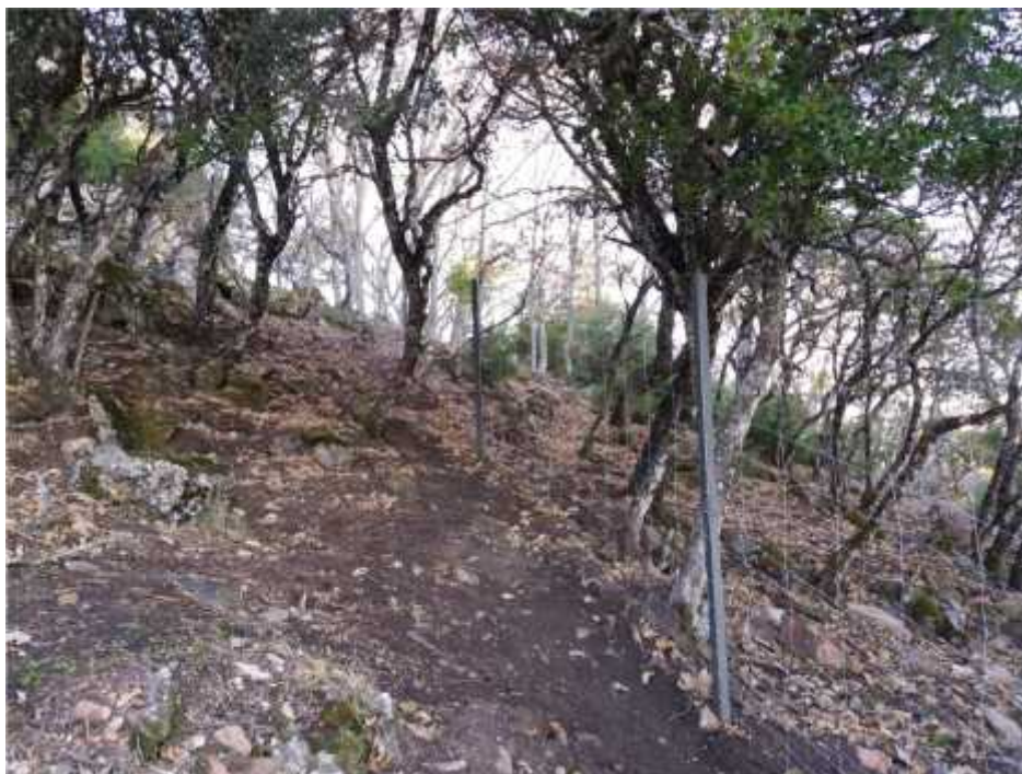
Despedregado manual en zona de asentamiento de la malla
