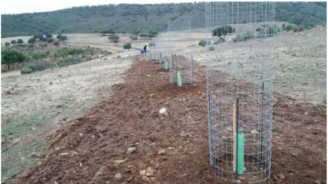
Instalación jaula protectora en repoblaciones de 2 metros de altura, sección circular de 60 cm, cuadro 50x100 mm y protector de tubo en su interior
