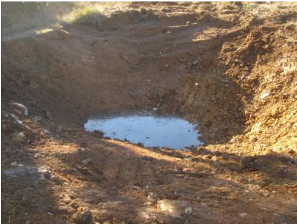
Trabajos de apertura y explanación de charca
