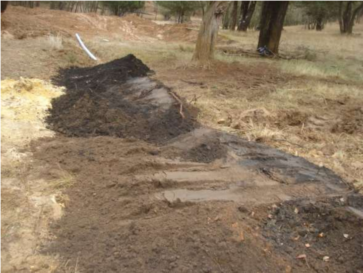
Excavación de zanjas, tubería y relleno y compactado de zanjas
