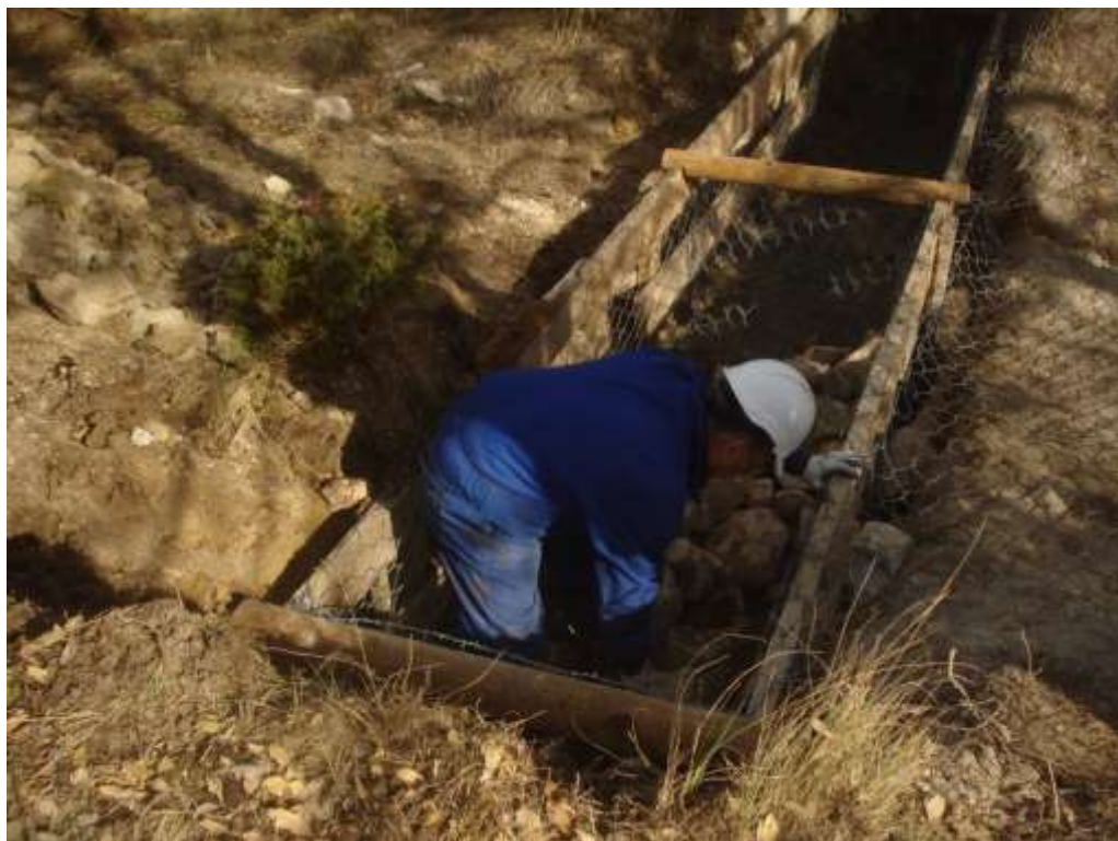
Trabajos de construcción de gabión con malla metálica
