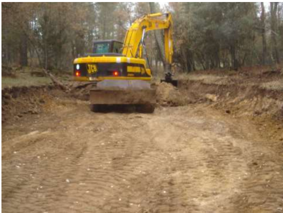
Trabajos de apertura y explanación de charca
