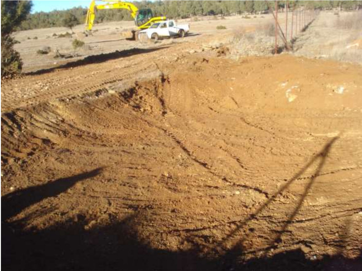
Trabajos de apertura, explanación, acopio y extendido de tierras
