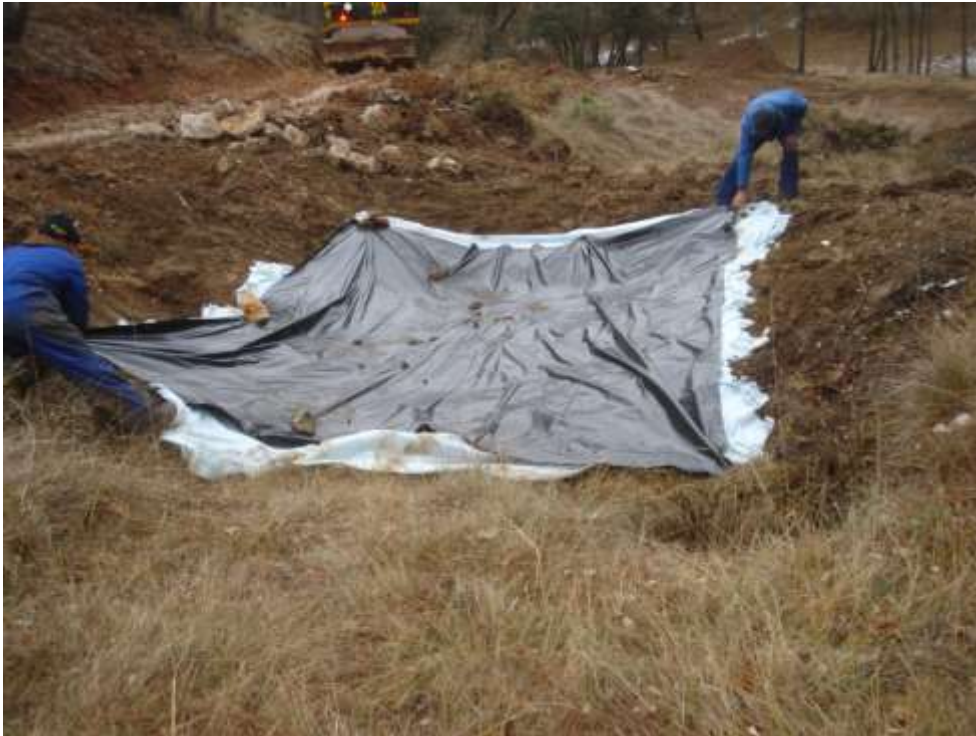
Impermeabilización de nueva charca
