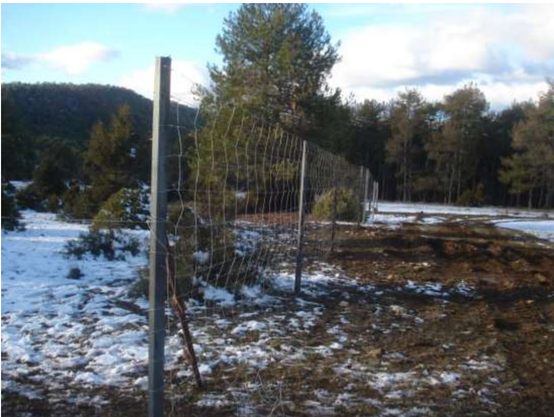
Trabajos de colocación de cerramiento en sabinar (malla cinegética)
