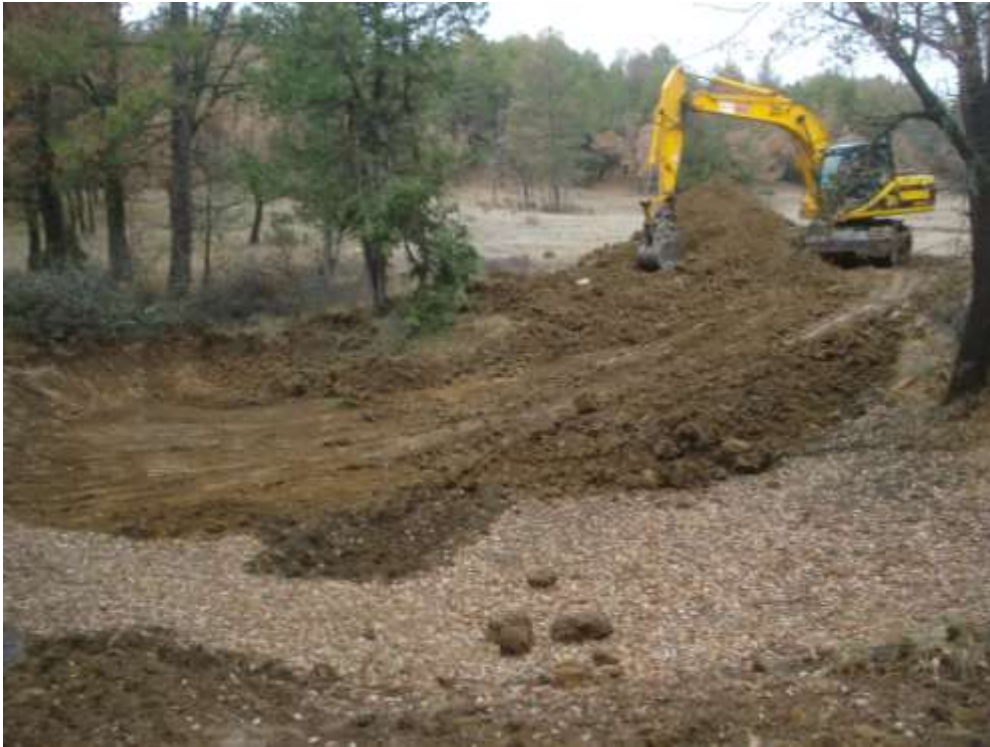
Trabajos de apertura de la charca
