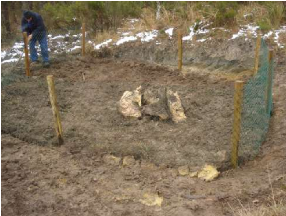
Instalación de refugios y valla de 1 m con rollizos de madera y malla
