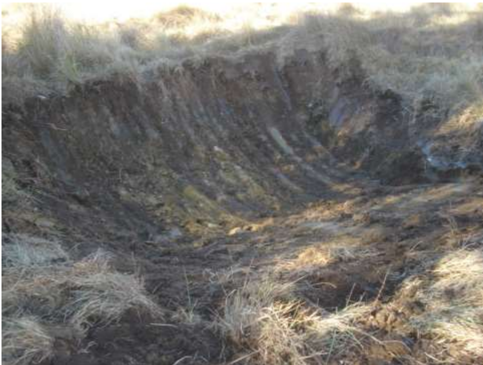
Trabajos de apertura y excavación de nuevas charcas
