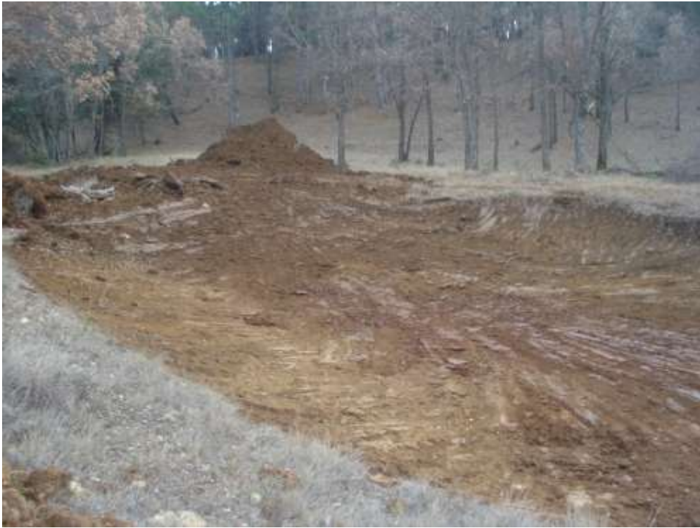
Apertura y explanación de charca existente
