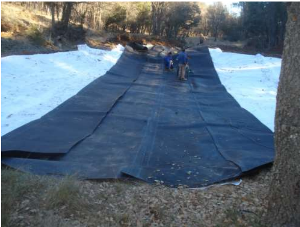
Impermeabilización de charca existente
