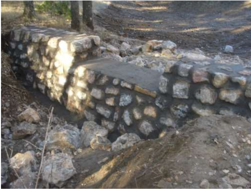
Ejecución de mampostería ordinaria
