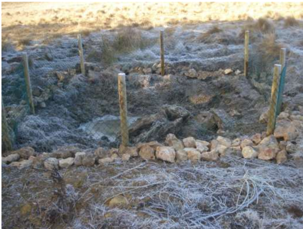
Instalación de refugios y valla con rollizos de madera y malla
