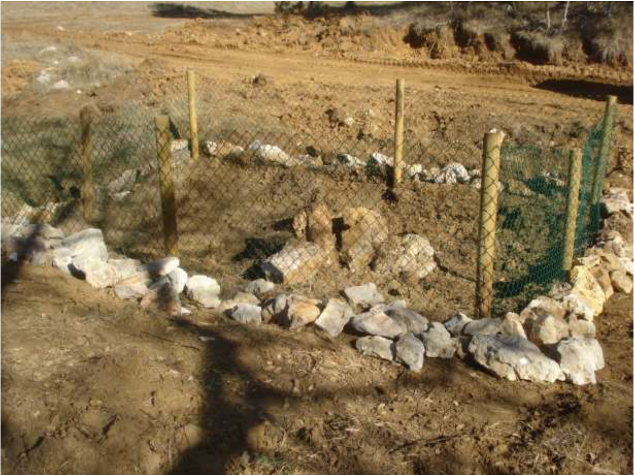
Instalación de refugios, adecuación de márgenes y valla con rollizos de madera y malla en charca nueva
