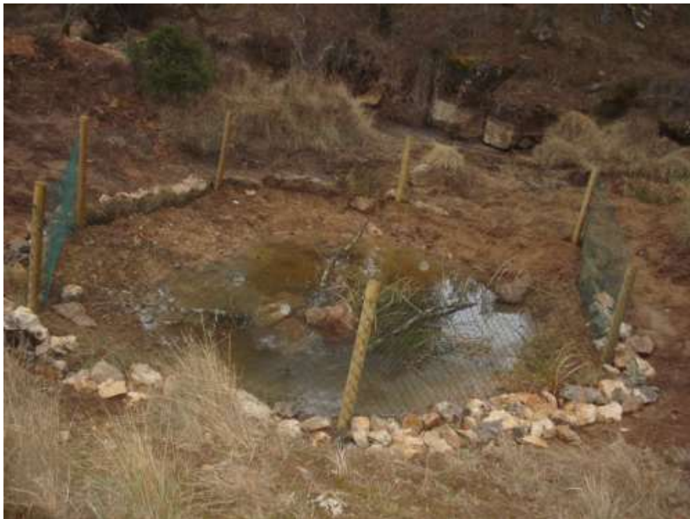
Instalación de valla con rollizos de madera y malla
