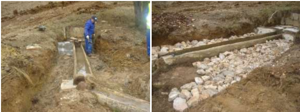
Trabajos de restauración de fuente y abrevadero
