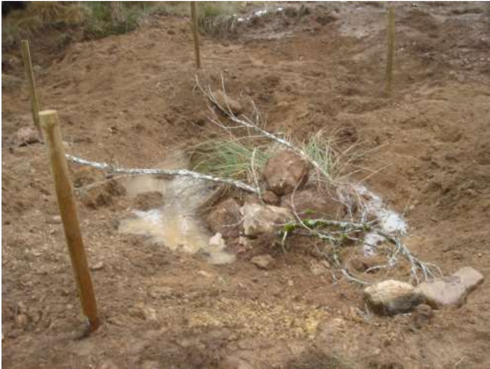
Trabajos de instalación de refugios
