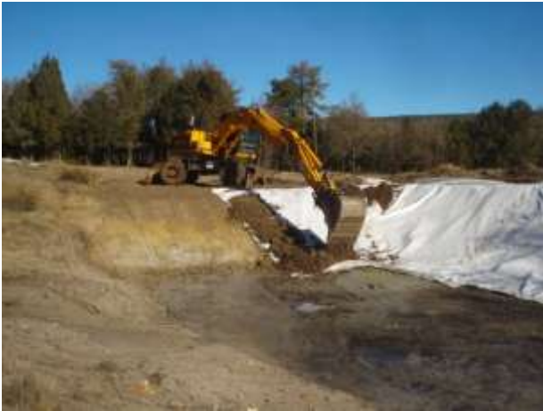
Trabajos de excavación, acopio, y reextendido de tierras sobre geotextil
