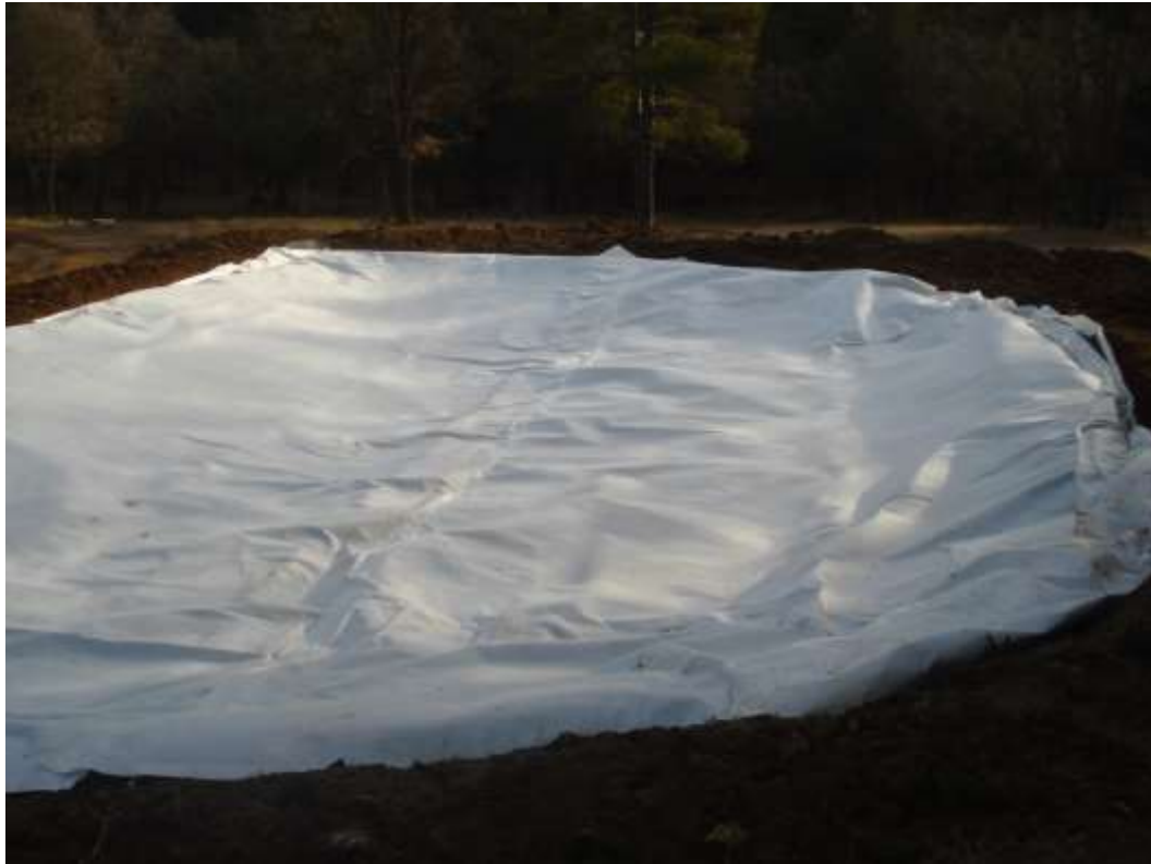
Impermeabilización de charca
