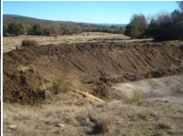
Trabajos de excavación, acopio, y reextendido de tierras sobre geotextil
