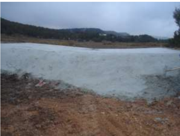
Ejecución de badén de hormigón
