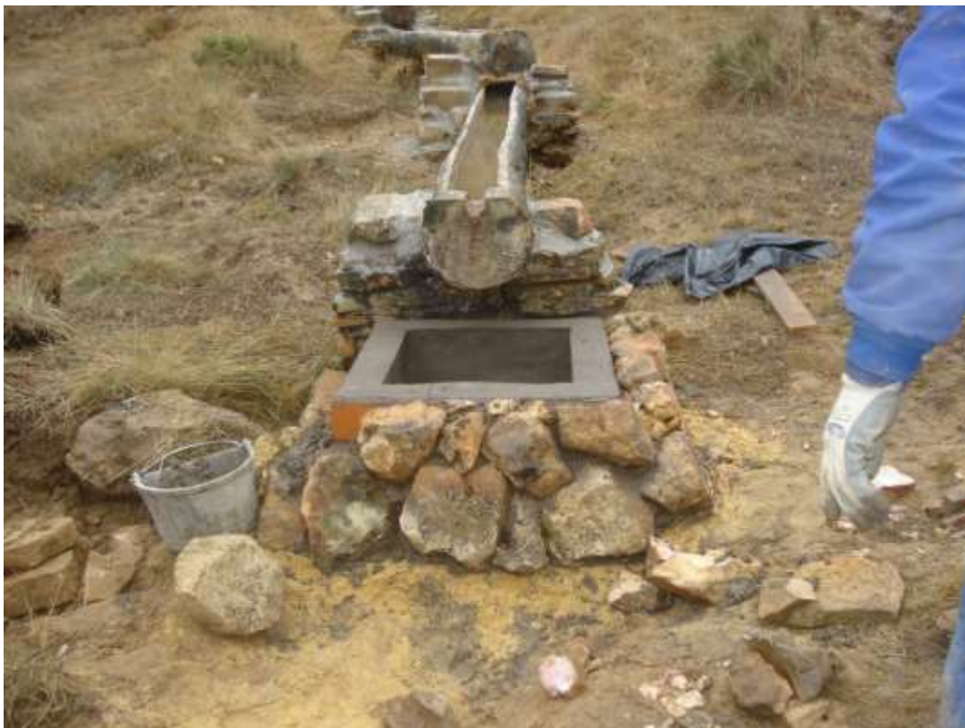
Arqueta de ladrillo
