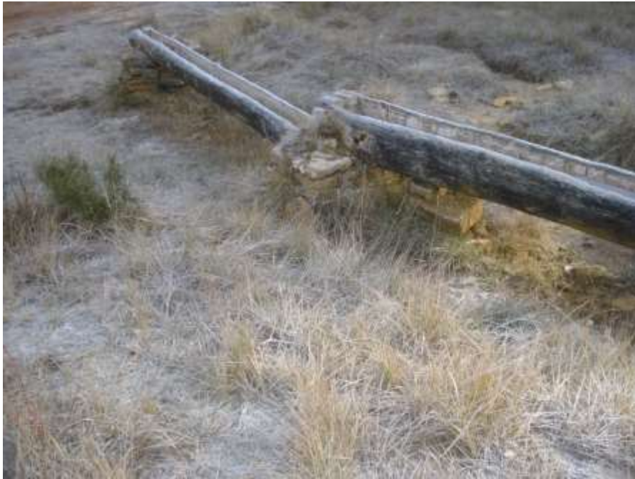
Situación del abrevadero previa a los trabajos
