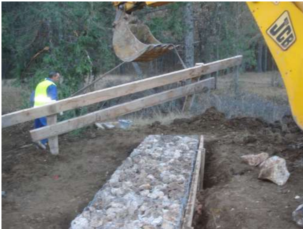
Trabajos de construcción de gavión
