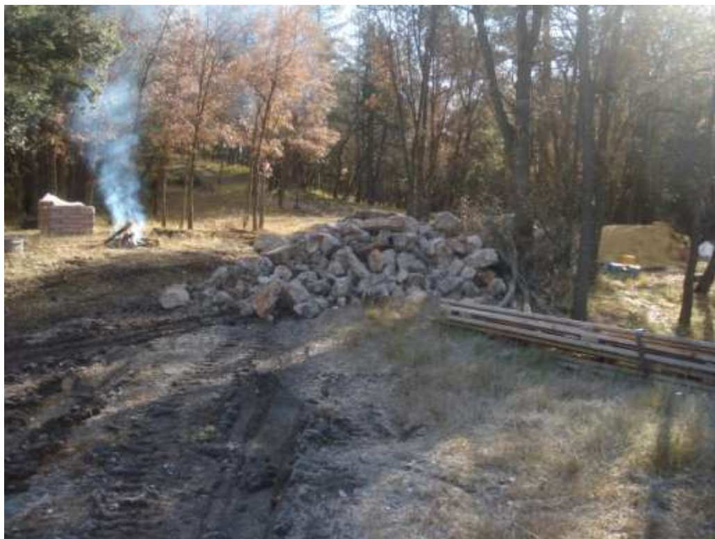
Acopio de piedra
