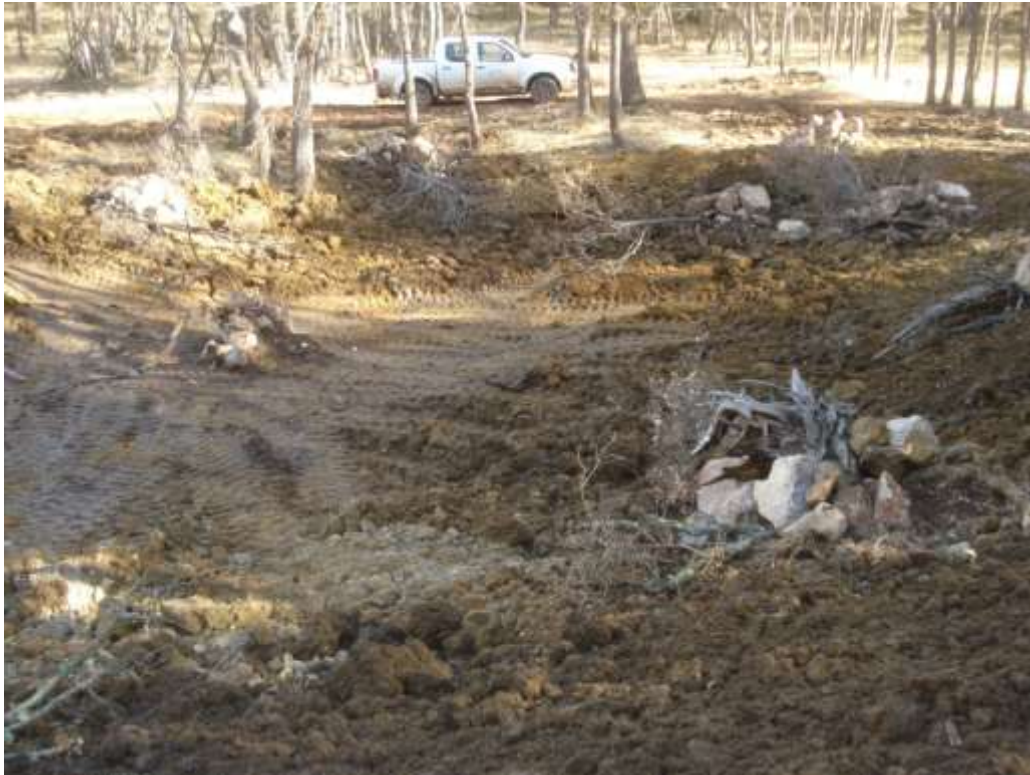
Adecuación de márgenes e instalación de refugios
