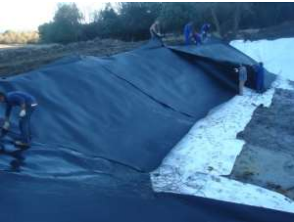
Impermeabilización de charca mediante lámina de polietileno entre geotextil
