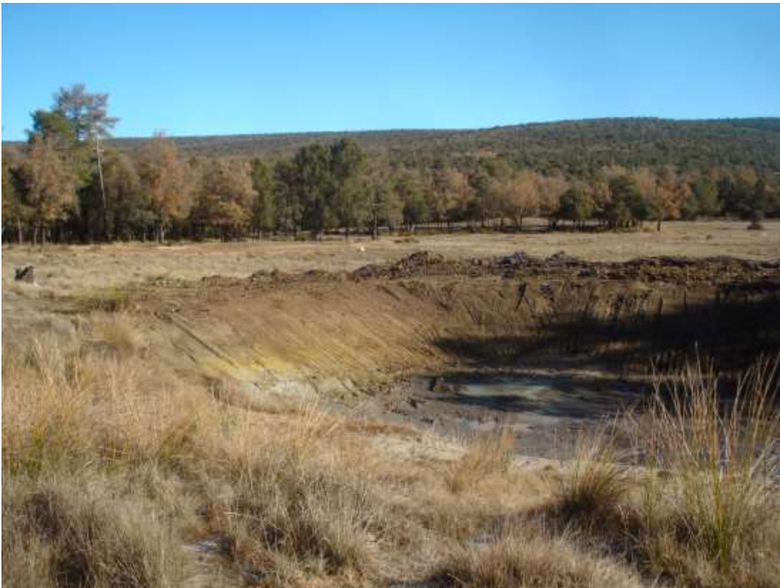
Apertura de charca: excavación
