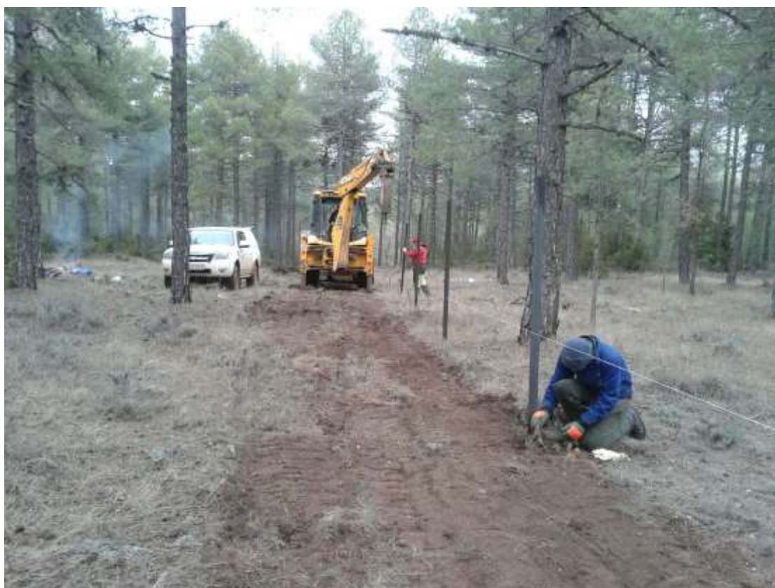
Trabajos de colocación de postes metálicos del cerramiento
