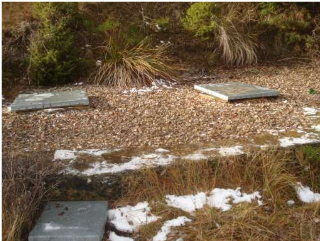
Trabajos de mantenimiento, revisión y limpieza de conducciones existentes
