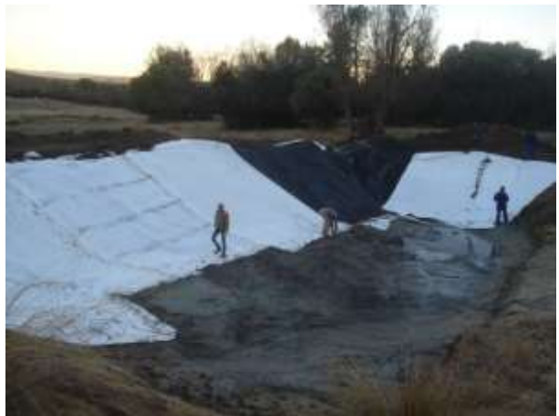
Impermeabilización de charca mediante lámina de polietileno entre geotextil
