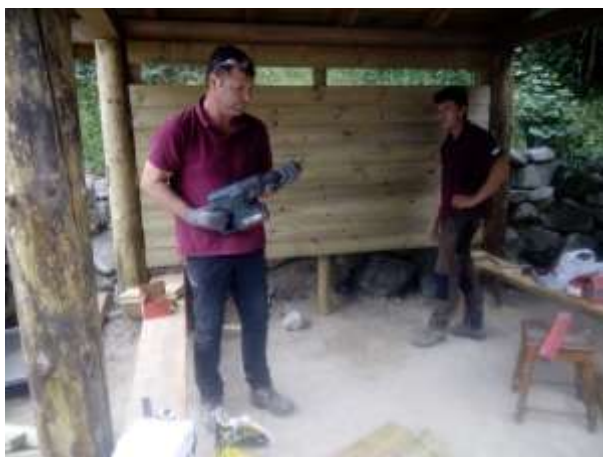
Imatge 14 Muntatge del plafó de fusta a l'aixopluc de Toirigo
