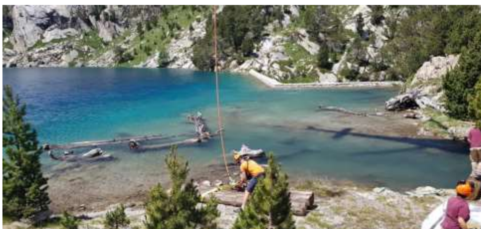
Imatge 31: Construcció del pont de l'Estany Negre. Font: arxiu fotogràfic del Parc Nacional
