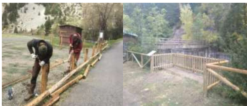
Imatge 15 i 16. Feines de reforç i substitució de les baranes dels aparcaments de Cavallers i La Molina Font: arxiu fotogràfic del Parc.
