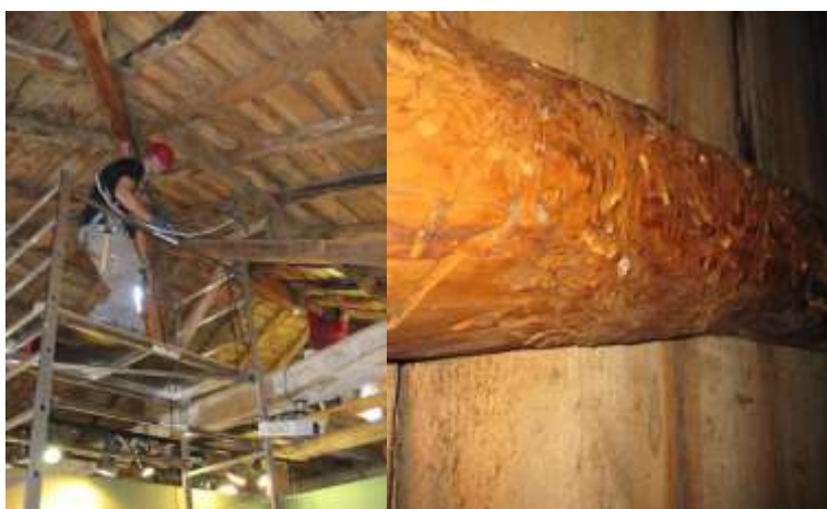
Imatge 12 i 13 Tasques de desinsectació de les bigues del llosat del punt d'informació de Llessui. Font: arxiu fotogràfic del Parc.
