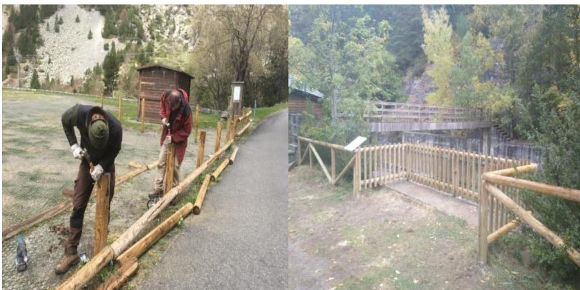
Fotos 15 y 16. Trabajos de refuerzo y sustitución de las barandillas de los aparcamientos de Cavallers y de La Molina. Fuente: Archivo del Parque.
