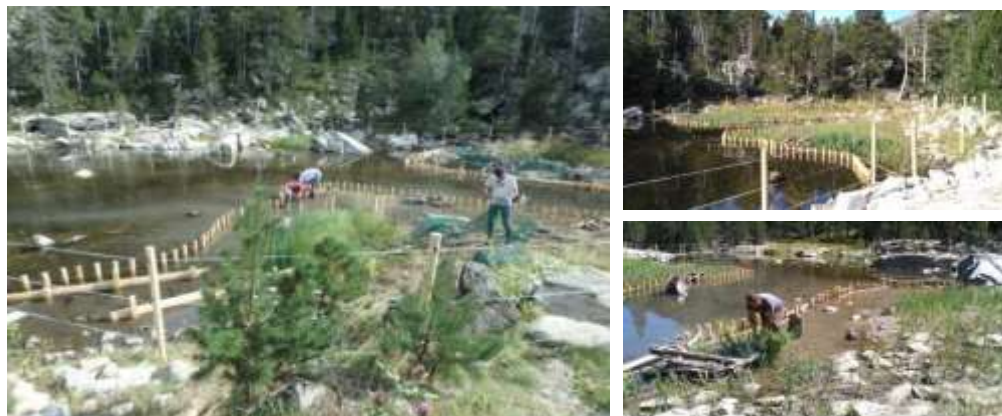
Imatge 11: Treballs de tancament, instal·lació de la tanca ramadera i transplantament de Carex a la Torbera de la Font Grossa. Font: arxiu fotogràfic.
