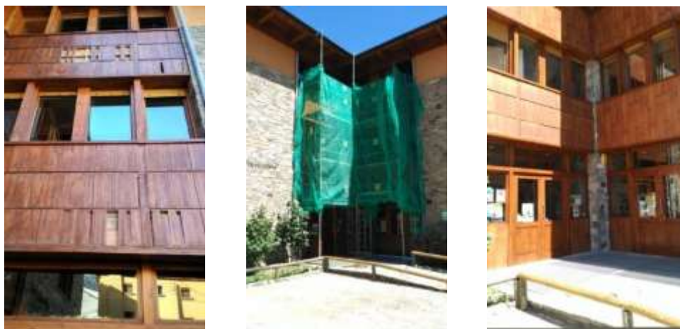
Imatge 22: Procés de substitució de la fusta exterior de la casa del Parc d'Espot. Font: arxiu fotogràfic.
