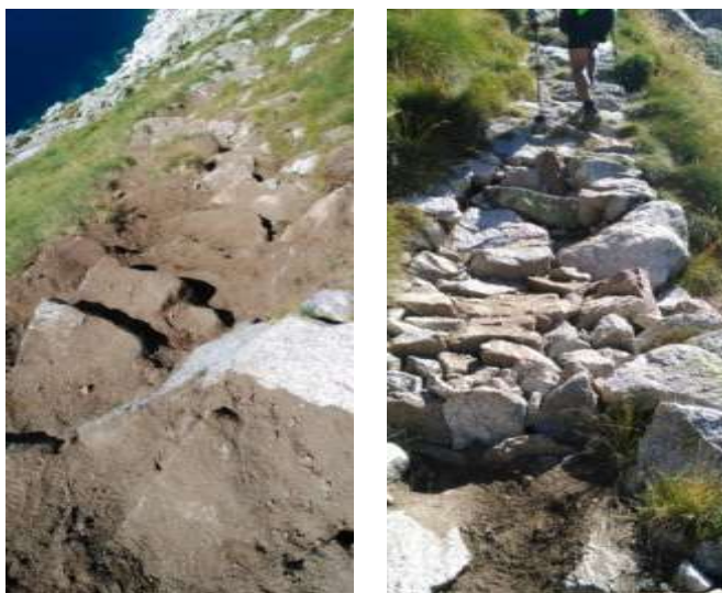
Imatge 28: Construcció d'un empedrat al camí del Pigolo (Sector Vall Fosca) Font: Arxiu fotogràfic
