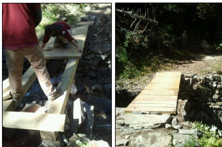
Foto 32. Renovació del pont de Subenuix
