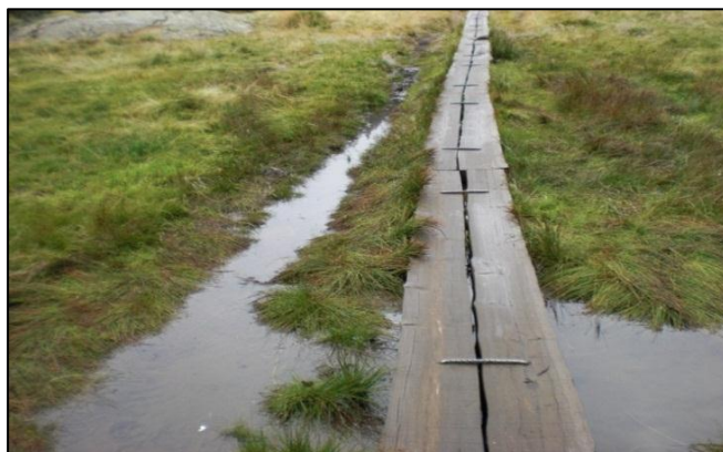
Foto 20. Passarel·la d'accés a la zona de Colomers
