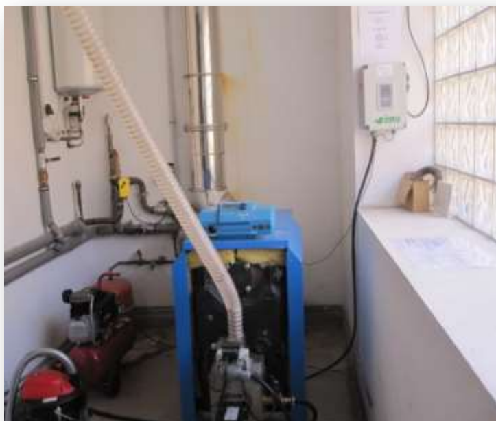
Foto 89: Instal·lació cremador de pellets al centre de Senet
