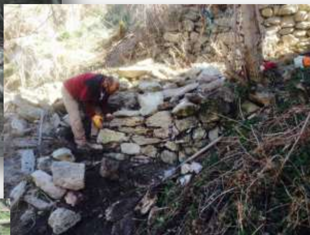
Foto 66: Reparació mur camins vius de Vilaller a Casós
