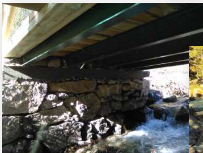
Foto 61: Renovació del pont sobre el riu Ratera a la pista forestal d'Amitges
