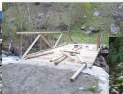
Foto 62: Reconstrucció del Pont de l'Arena
