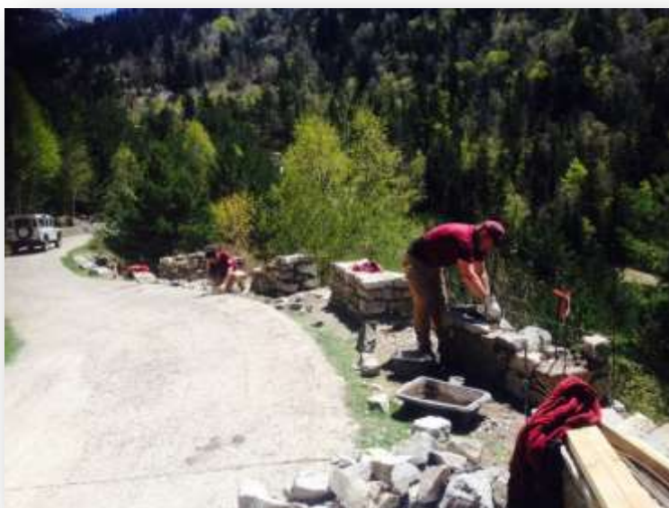
Foto 60: Construcció de murets a la carretera d'Aigüestortes
