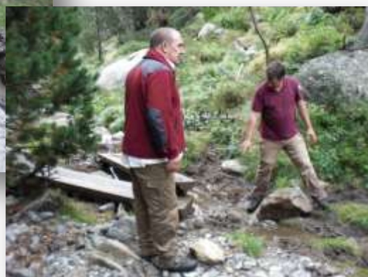
Foto 63: Millora d'un tram de camí d'accés a Colomèrs
