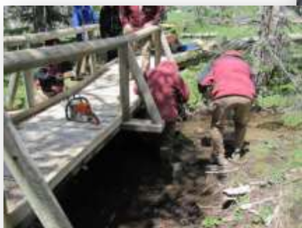
Foto 67: Reparació passarel·la d'Aigüestortes
