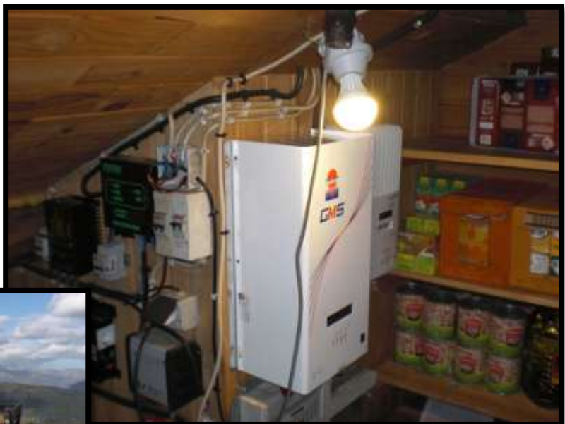
Foto 69: Enllumenat fotovoltaic del refugi del Pla de la Font
