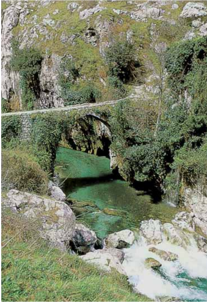
Puente La Jaya
