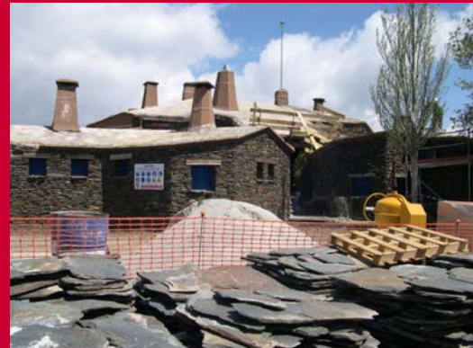
Refugio Postero Alto, durante las obras.
