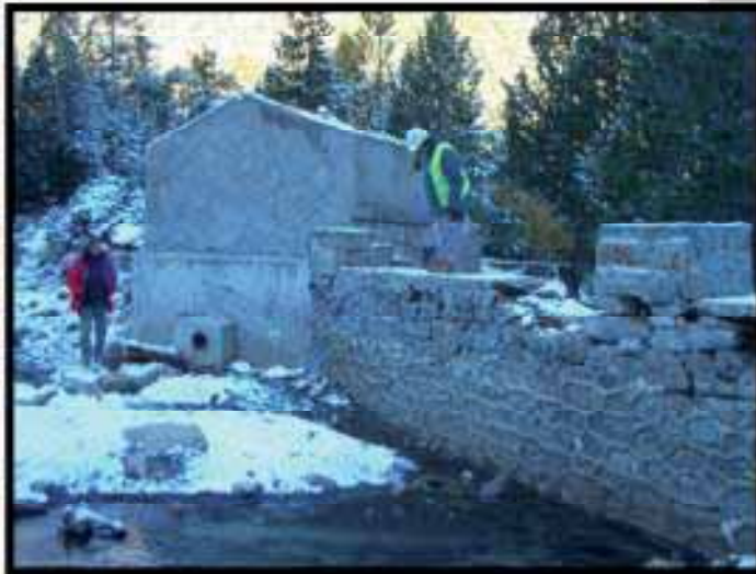
Foto 16: Desmantelamiento presa de la Font Grossa
