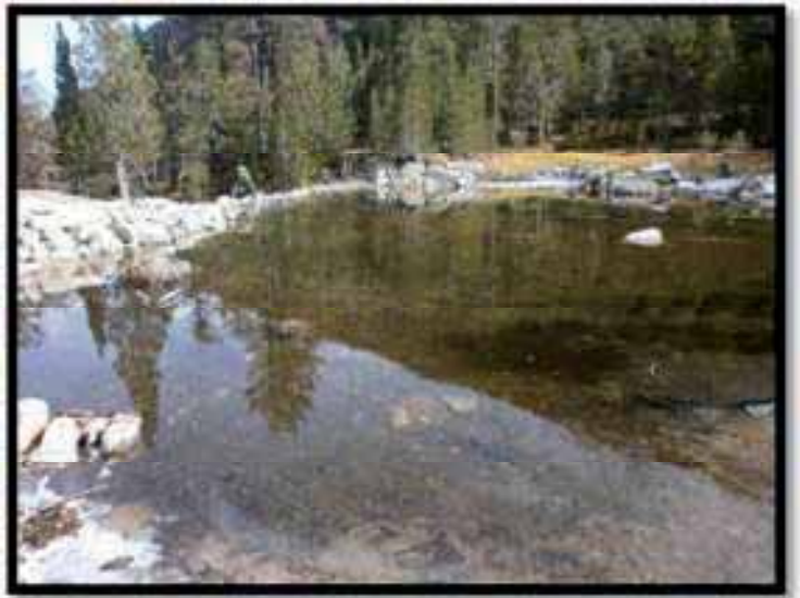
Foto 17: Desmantelamiento presa de la Font Grossa
