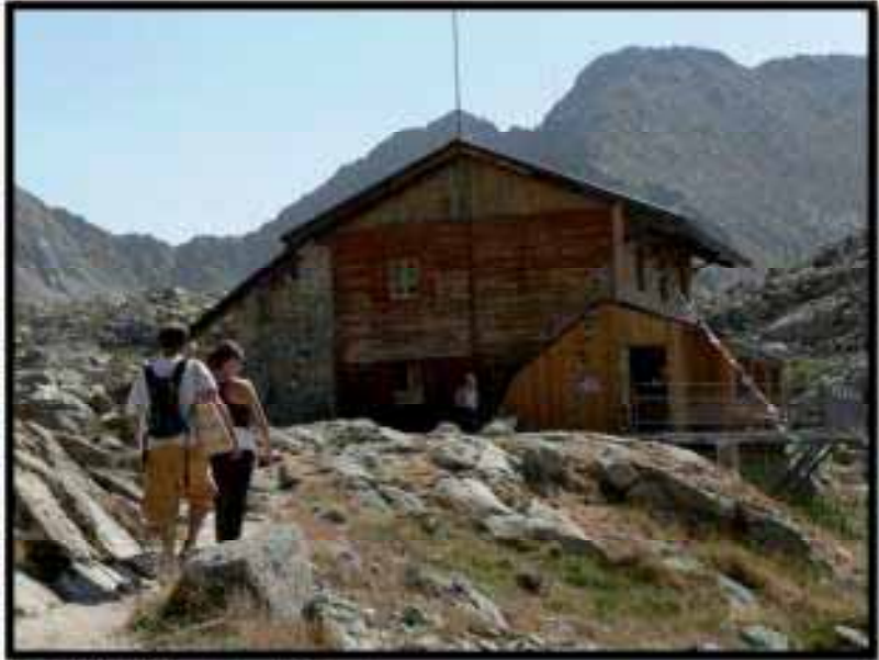
Foto 345: Refugio de la Colomina
