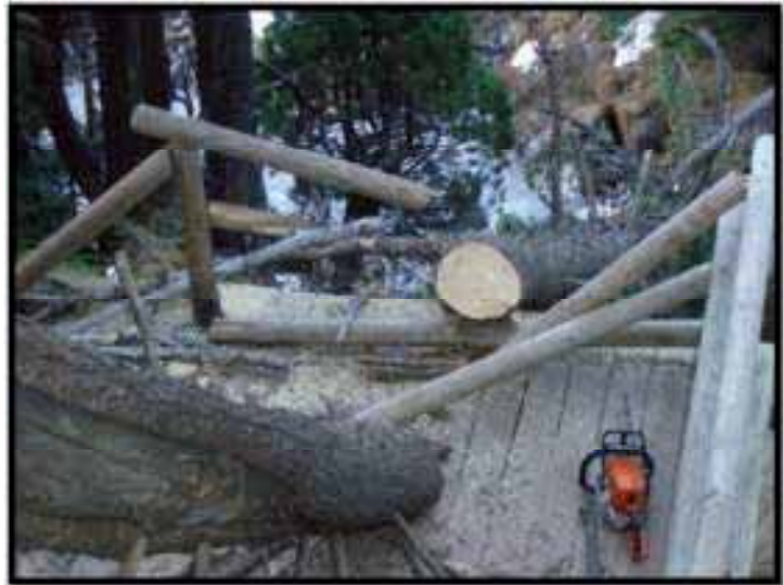
Foto13: Reparación desperfectos en el mirador de la cascada de Gerber
