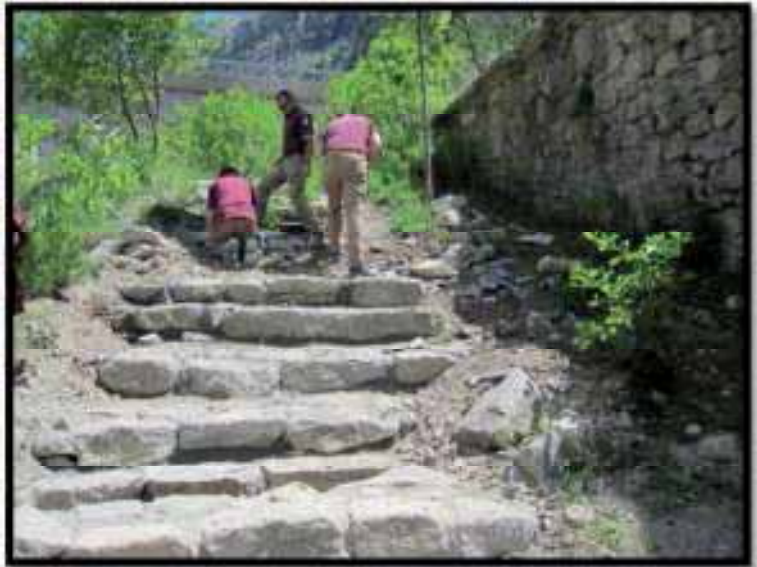
Foto 368: Construcción de peldaños en el camino de Cavallers
