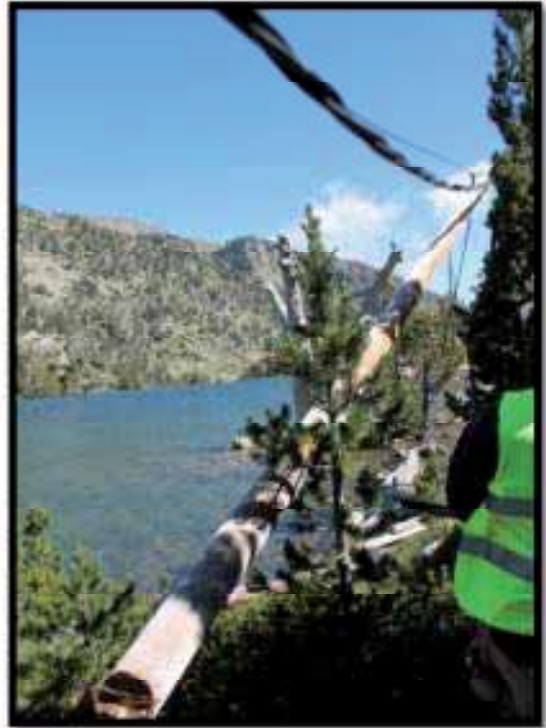
Foto 15: Desmantelamiento línea eléctrica de Peguera
