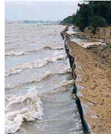
Defensas contra la erosión del río.
