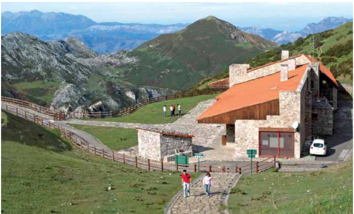
Figura 17: Vista del Centro de Visitantes Pedro Pidal, Parque Nacional de Picos de Europa. / View of the Pedro Pidal Visitor's Centre, Picos de Europa National Park.
