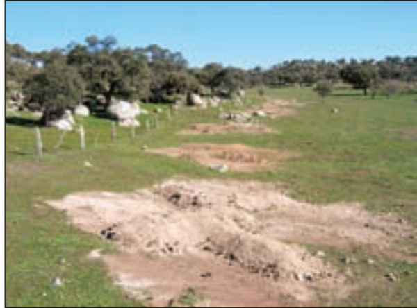
Figura 4-44. Aspecto de un núcleo de refugios subterráneos de tubos inmediatamente después de su construcción. Se han dispuesto entre el berrocal y el pastizal.
