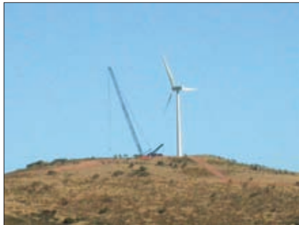
Figura 4-98. Construcción y montaje de un aerogenerador, con grúas de gran altura, en Castilla y León.
