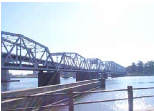
Figura 6. Histórico Puente metálico del Santa Lucía (1925-2005).
