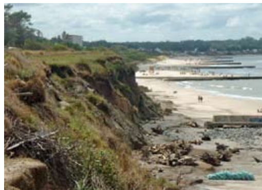
Figura 12. Balneario La Floresta Depto. de Canelones. Detalle de espigones dañados.
