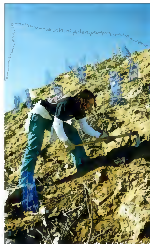
Foto 12. Restauración del Vertedero de Navalagamella
