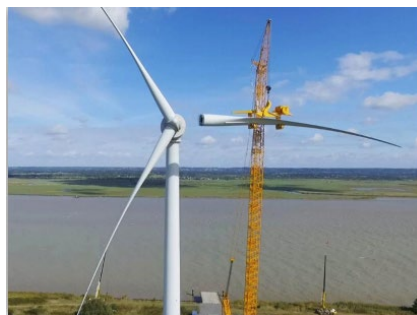
Figura 21. Desmantelamiento de un aerogenerador
