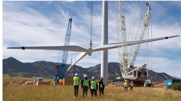
(b) Montaje del aerogenerador
