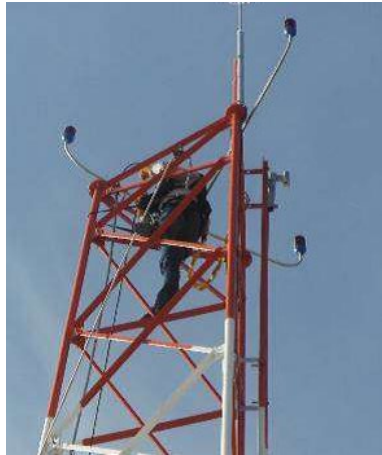
(a) Instalación de torre meteorológica
